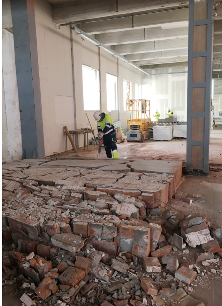
► FASE A Enderroc un cop realitzat l'estintolament.
