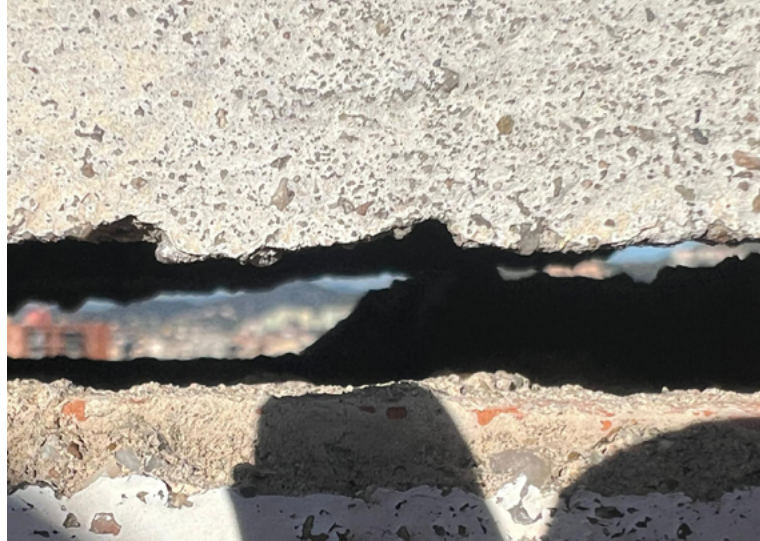
➤ Esquerda per dilatació a l'ampit d'una coberta plana transitable.
