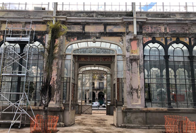
➤ Els treballs de restauració han inclòs reparacions en les cobertes.
