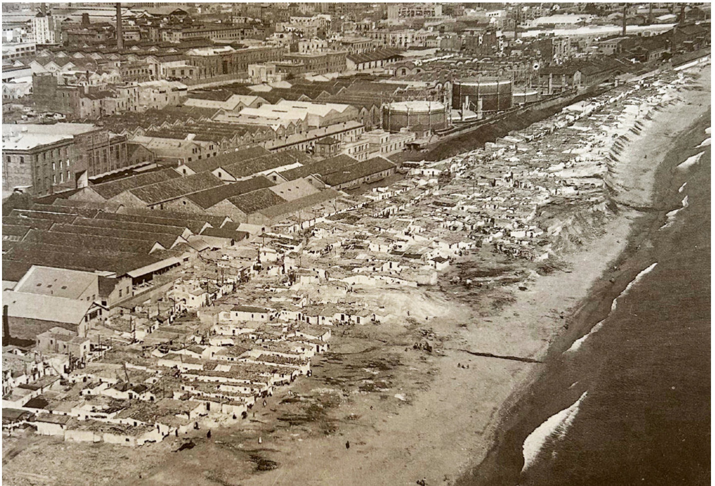
» Vista aèria de les barraques del Somorrostro.
