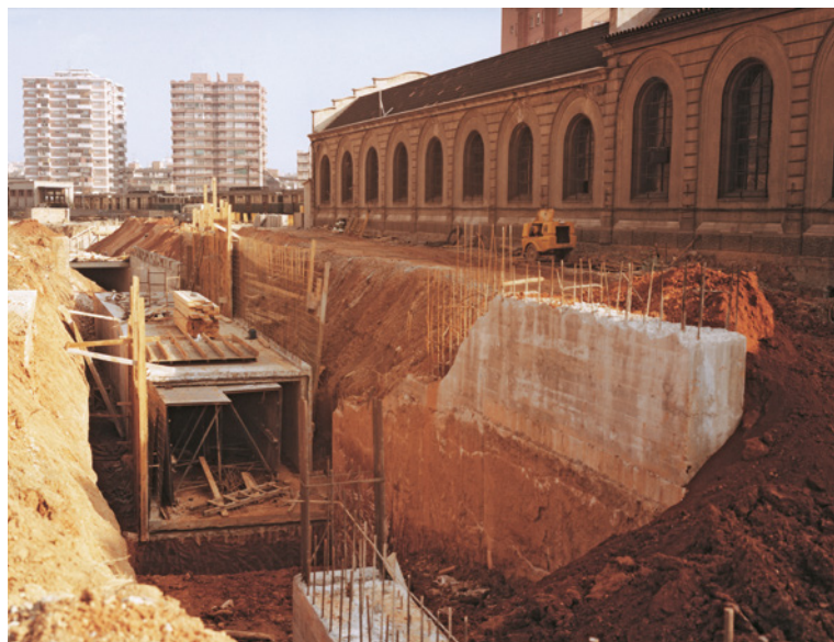
› Soterrament de la L1 a l'estació de Santa Eulàlia.
