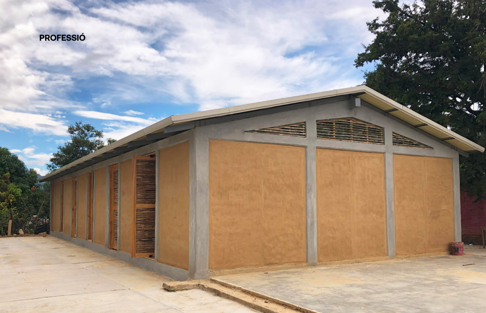
► Reconstrucció de l'escola de Villa Corzo, a Chiapas (Mèxic).
