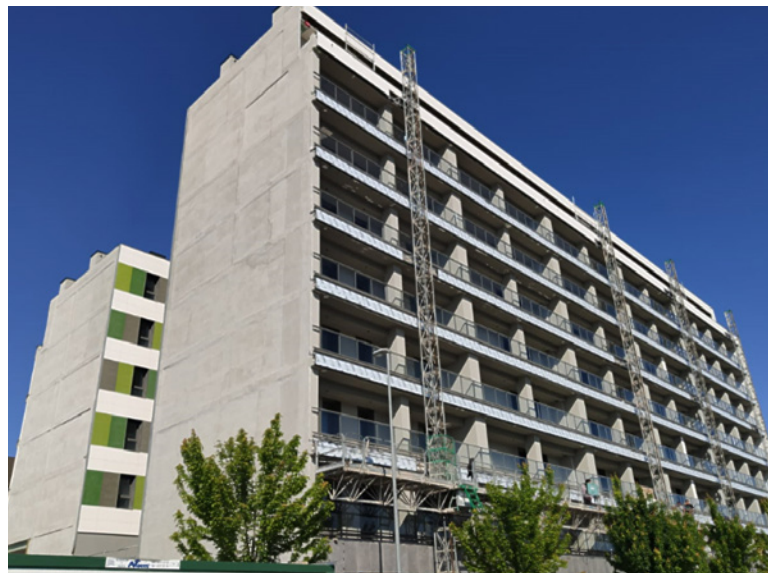
Edifici d'habitatges d'obra nova (País Basc). Façana principal.
