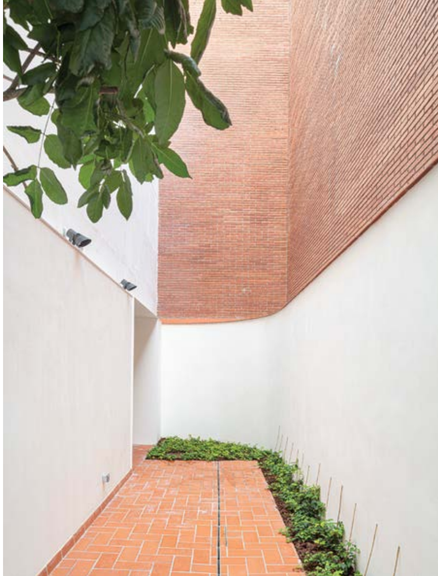
Les instal·lacions de sanejament i reg, integrades al pati, enriqueixen l'entorn amb una dimensió paisatgística
