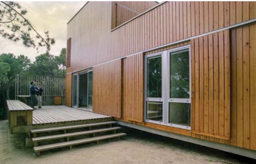
Pavelló de fusta a Cabrera de Mar. L'informatiu núm 128 de juny de 1998
