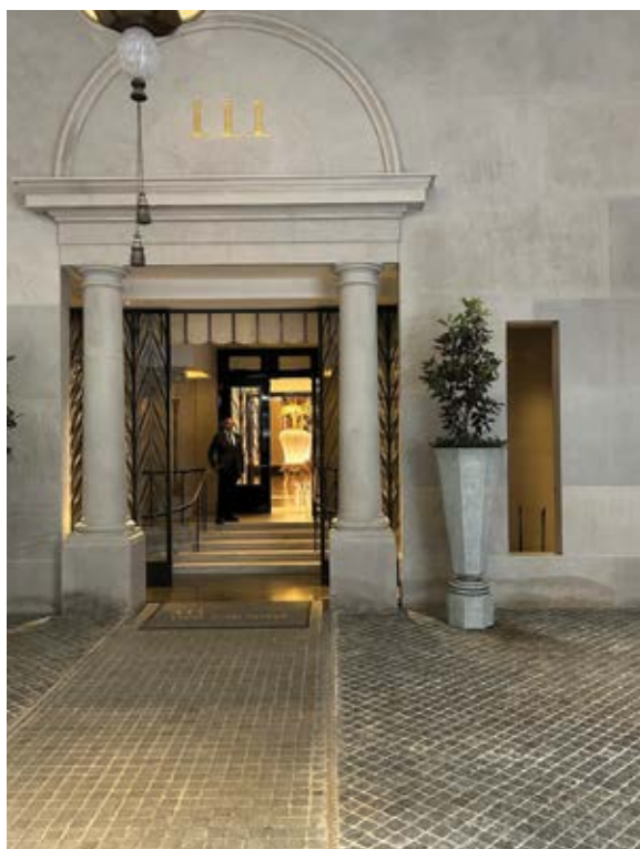
Vista de l'accés nou a la torre on pot accedir el vehicle, creant un porxo per accés rodat i per a vianants.
