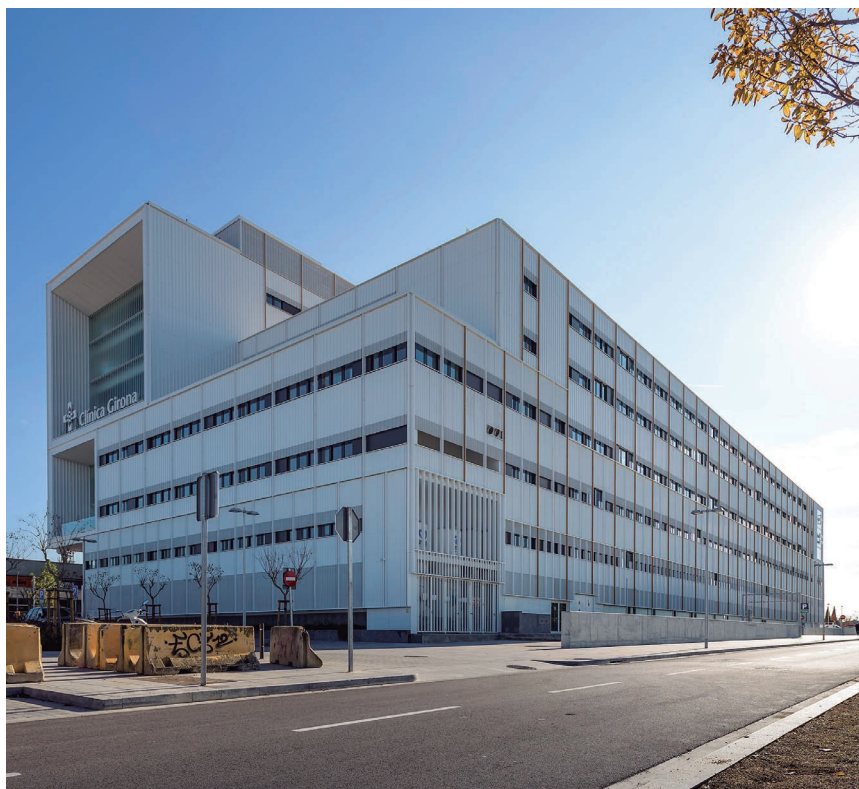
Façanes a sud (entrada), est (carrer Barcelona) i oest (vies) respectivament
