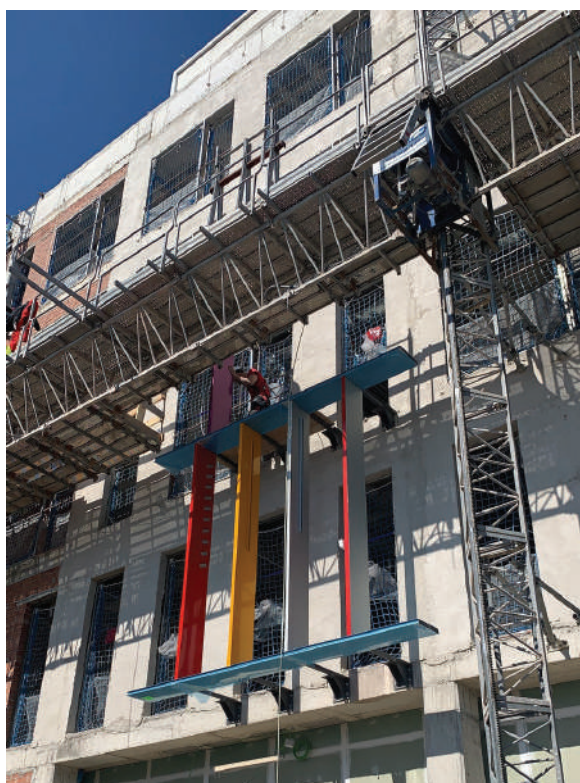
Execució de les ores del SJD Pediatric Càncer Center Barcelona (Foto: Enne Gestión Activa de Proyectos)
