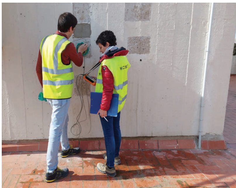
Corrosió detinguda: una solució duradora
