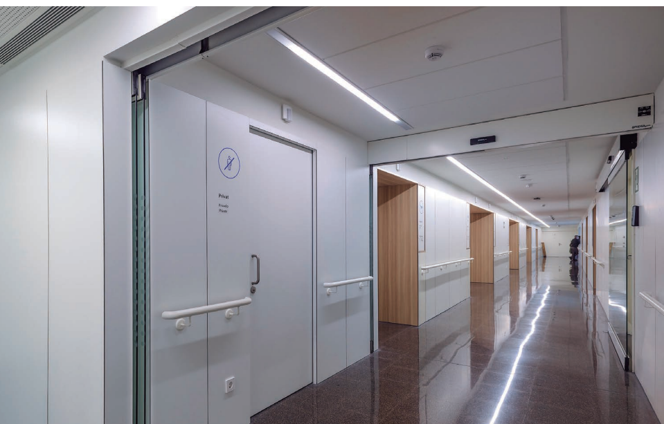
Porta de sectorització per sobrepressió
