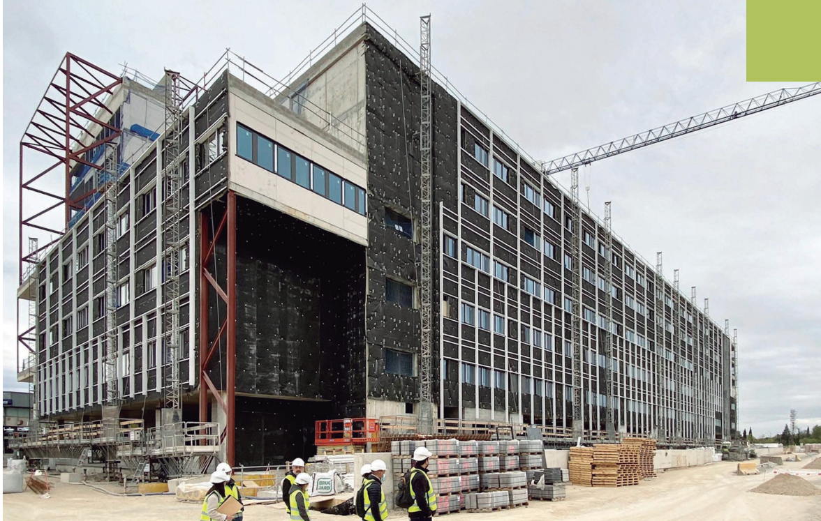
Procés d'execució en fase de tancaments
