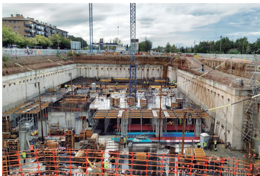
Procés d'execució en fase d'estructura sota rasant
