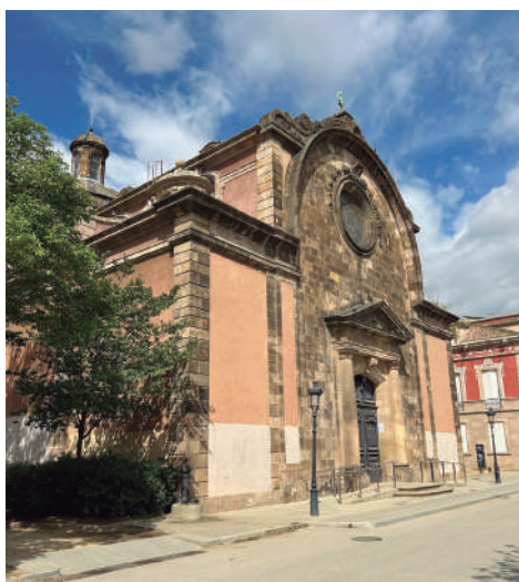
Edificis avui en peu del recinte militar.
