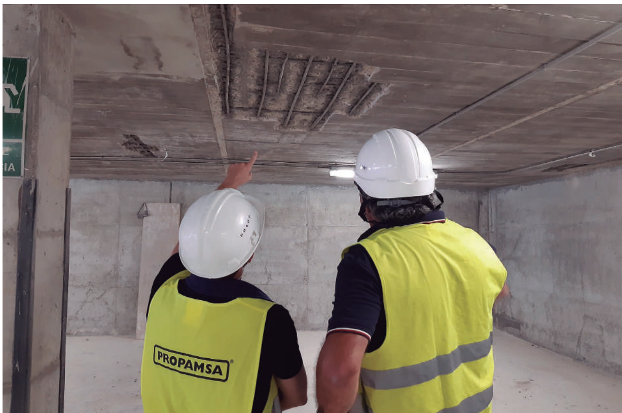
Reparació estructural de forjat de formigó
