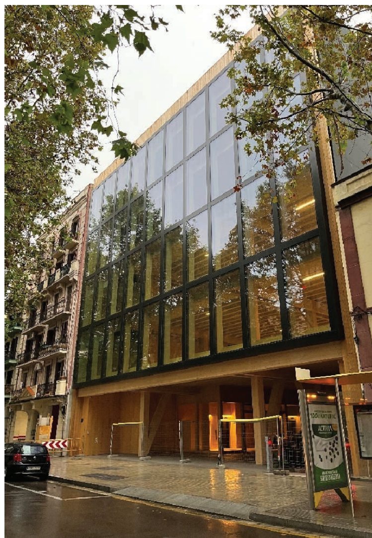
Edifici d'oficines Wittywood a Barcelona (Foto: Betarq Group)
