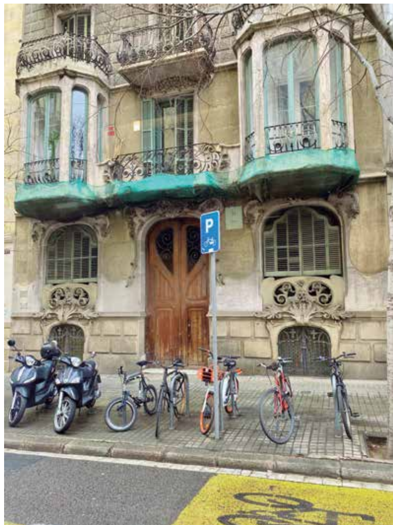
Obres de rehabilitació i de protecció d'elements perillosos per als vianants (Fotos: Aina Gatnau)
