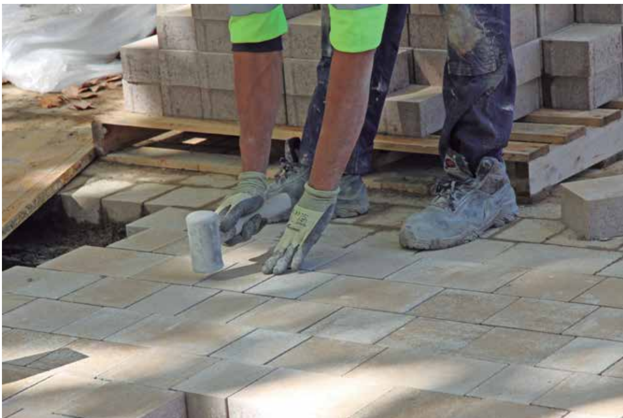
Imatge detall de l'execució del paviment, facilitada pels tècnics directors
