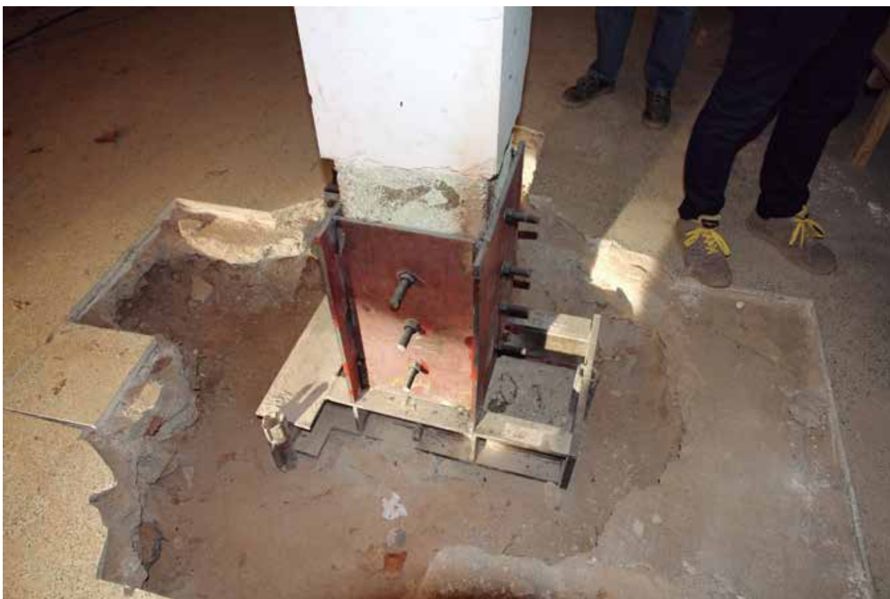
Imatge de la fase de fonamentació on es veu el reforç aplicat al cap dels micropilots, facilitada pels tècnics directors
