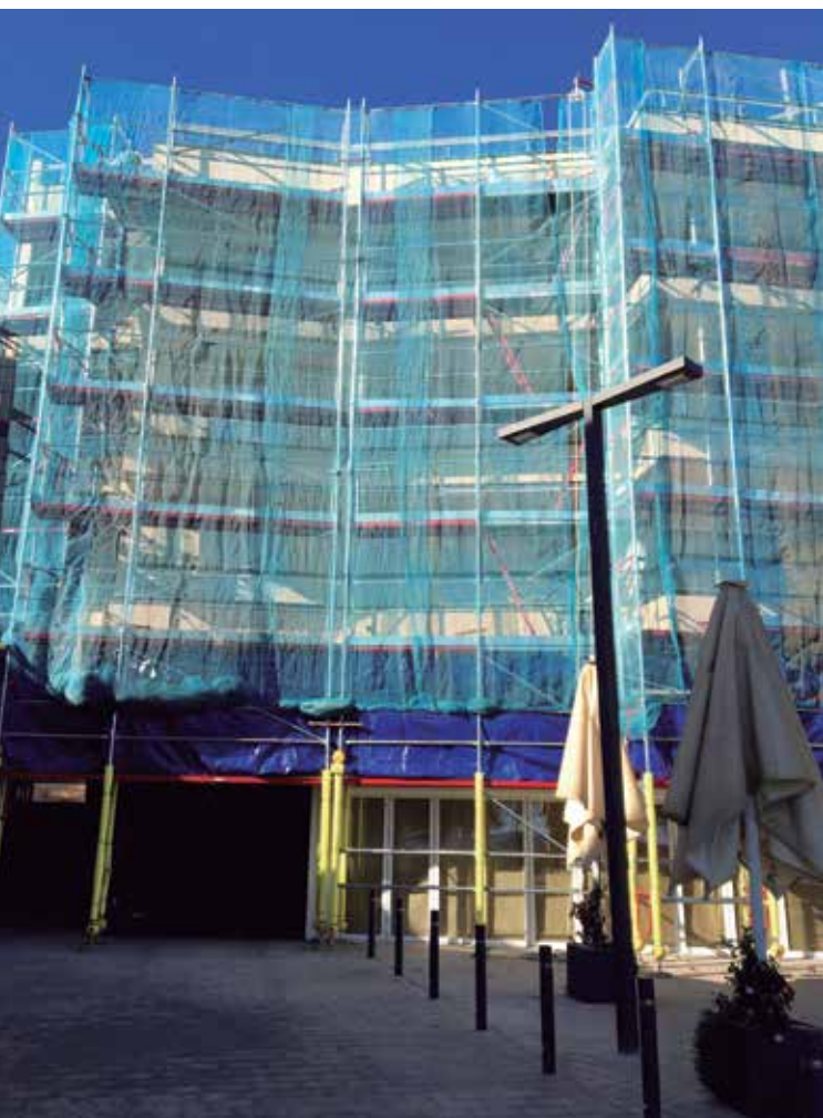
Obres de rehabilitació i de protecció d'elements perillosos per als vianants (Fotos: Aina Gatnau)
