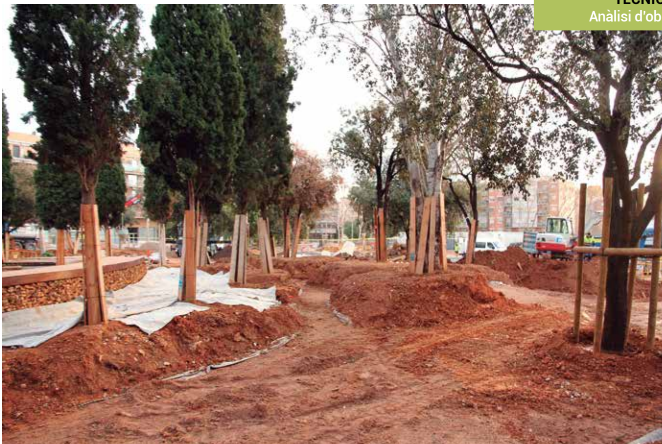
Imatge de la fase d'execució on es veu l'adaptació de l'arbrat existent i l'excavació de la caixa de terra vegetal. Imatge facilitada pels tècnics directores
