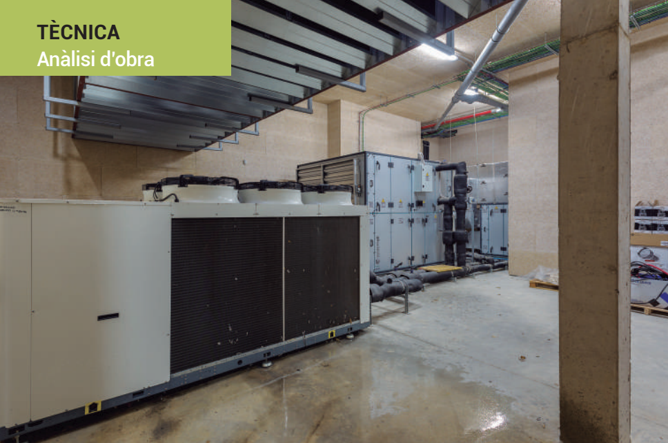
La planta d'instal·lacions
