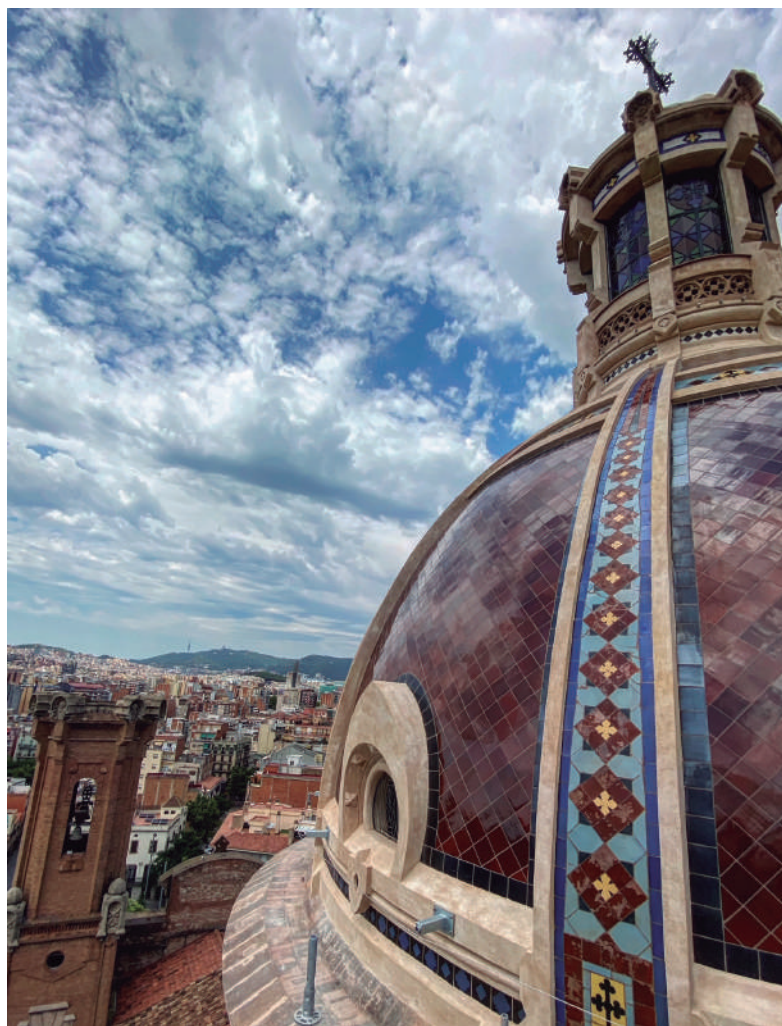
Restauració de la cúpula de l'església de Sant Andreu del Palomar (Foto: Francesc Belart)
