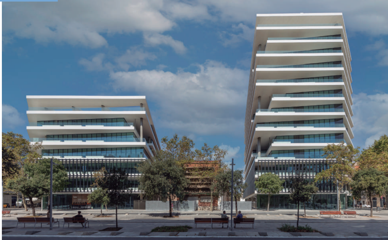
Complex d'oficines Sea Towers a l'avinguda Icària de Barcelona (Foto Francesc Belart)
