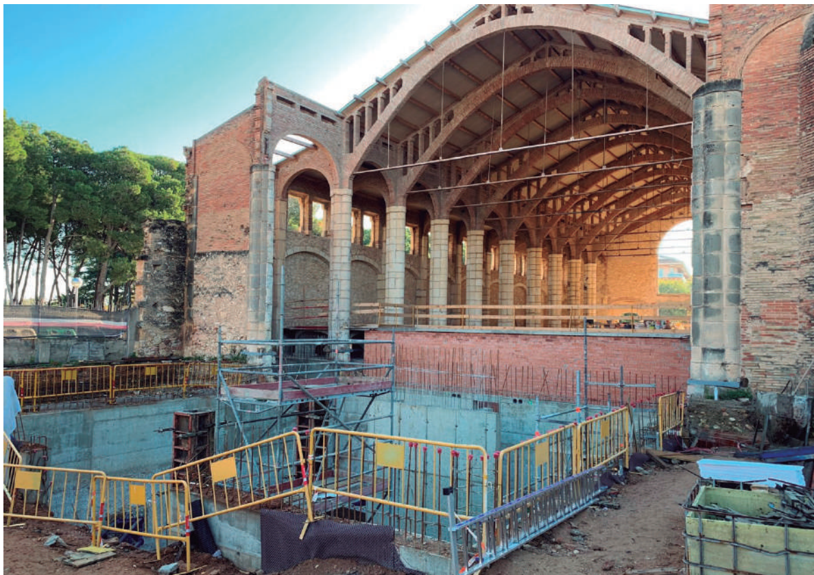
Treballs de fonamentació de la caixa escènica a la capçalera de la nau principal
