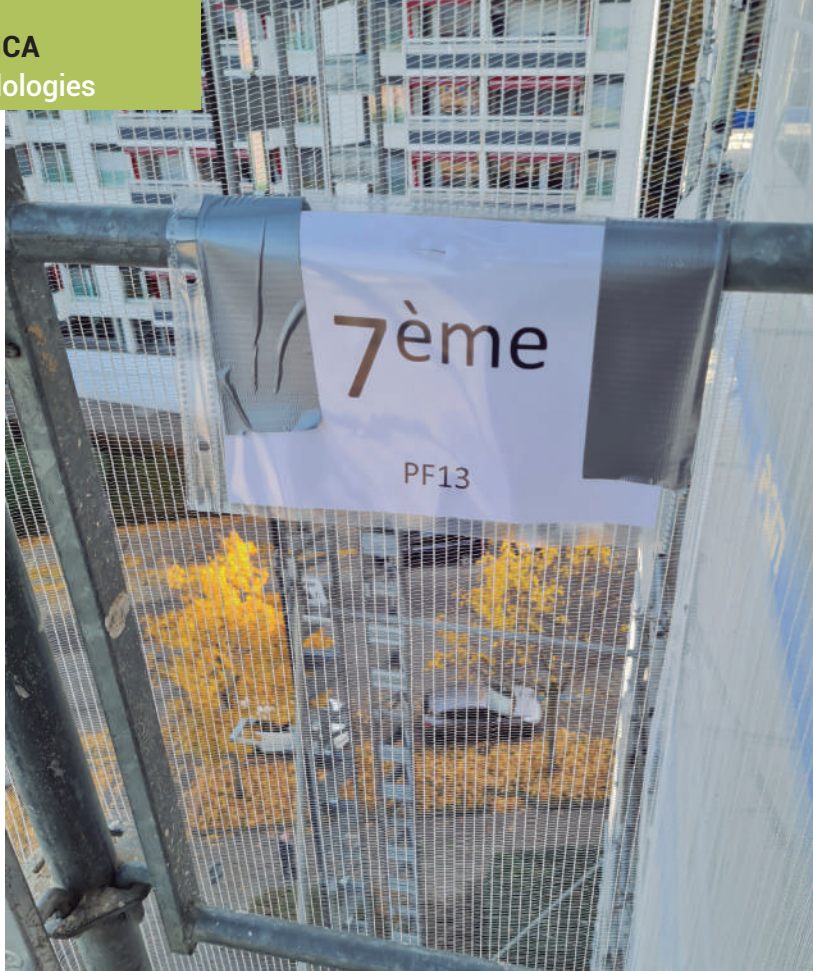
Durant el procés d'obra, indicar el número de la planta a la bastida evita pèrdues de temps
