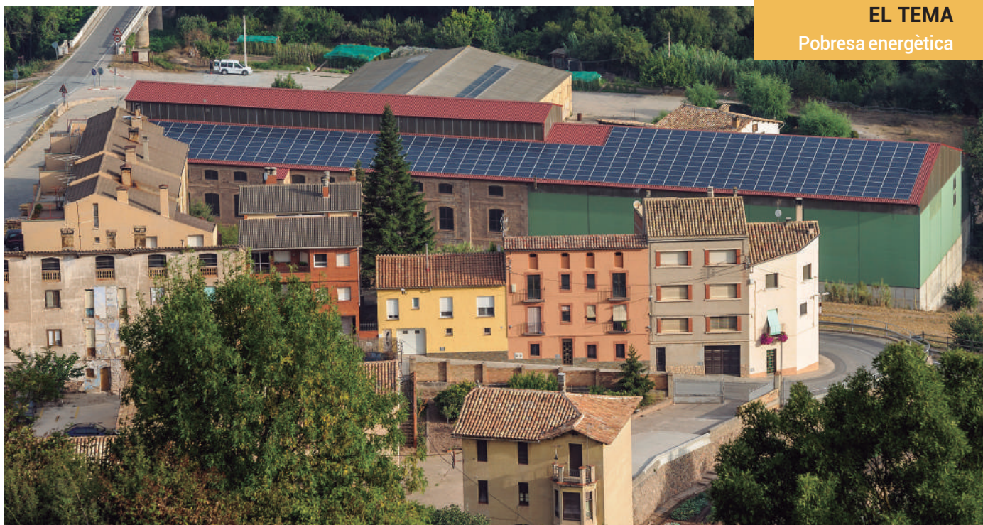
Antic edifici industrial rehabilitat i dotat d'una instal·lació de captació solar fotovoltaica
