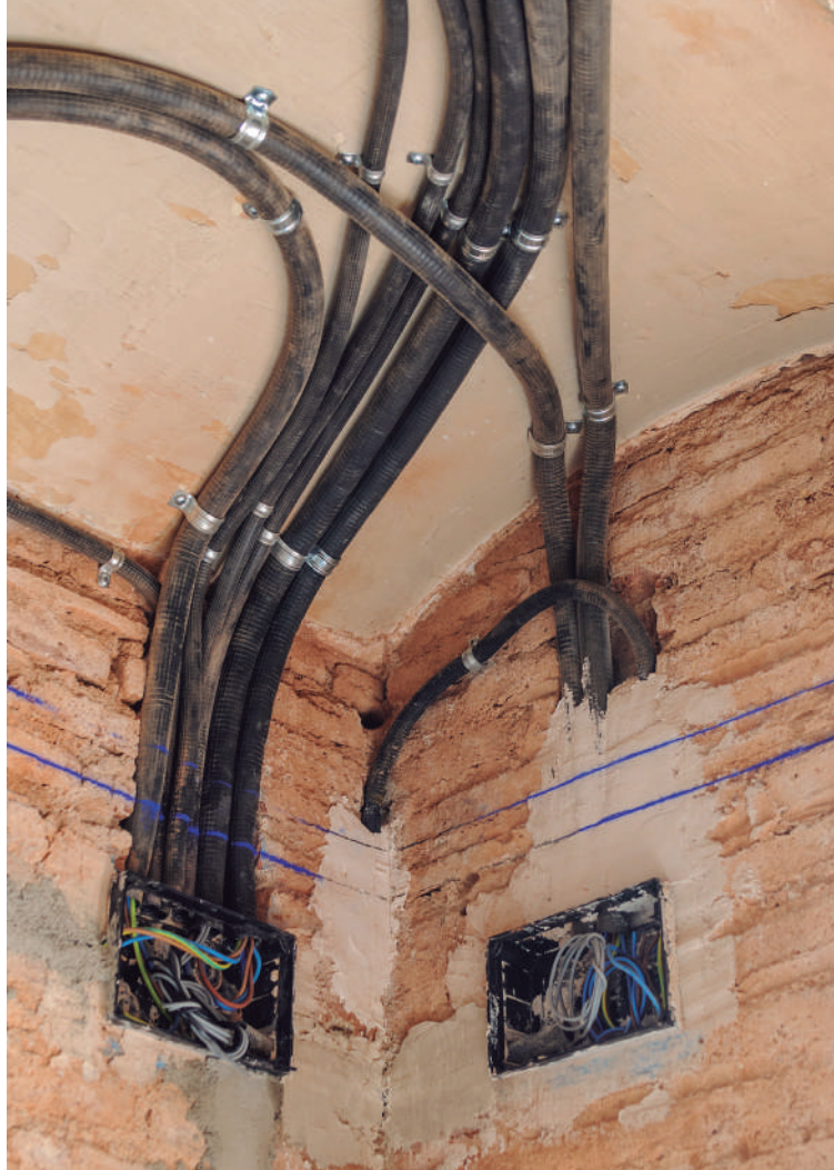
Obres de reforç de la instal·lació elèctrica
