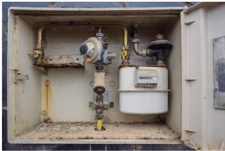
La clau de pas i el comptador del gas en una casa antiga
