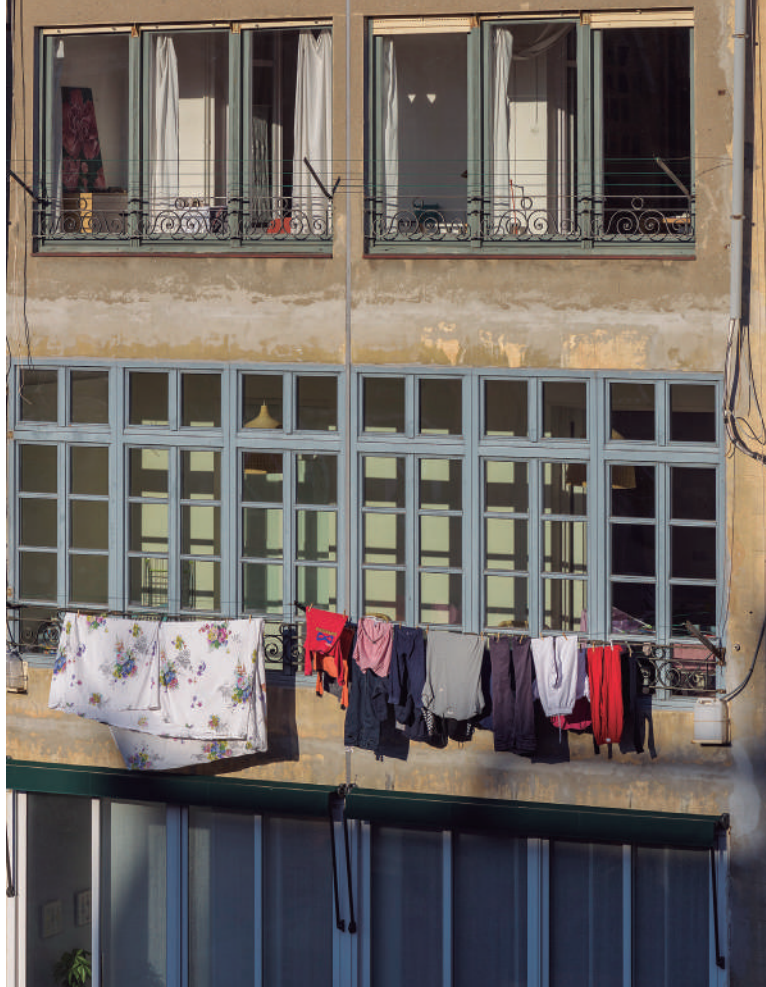
Façana d'un pati interior amb galeries
