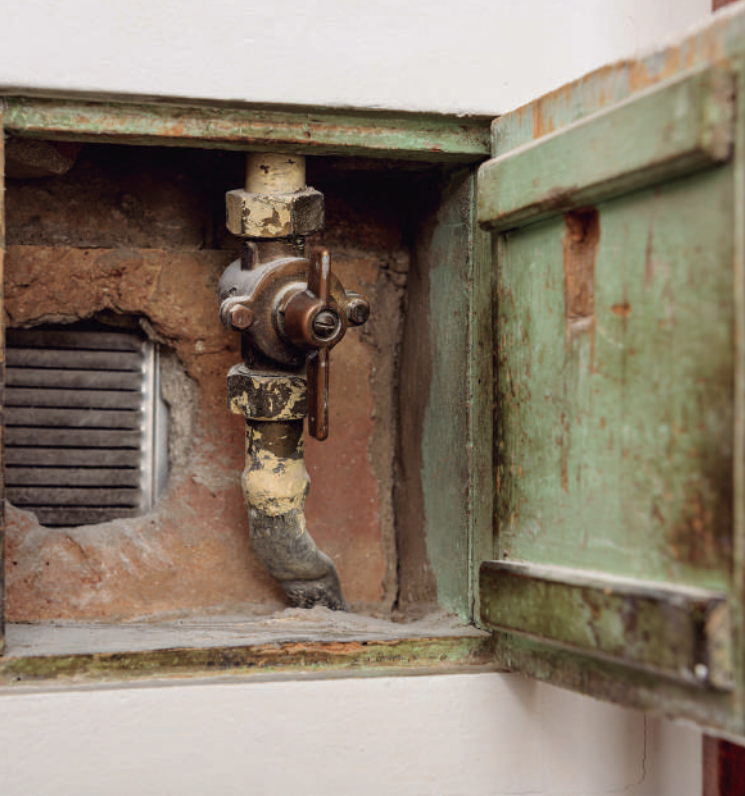
La clau de pas i el comptador del gas en una casa antiga
