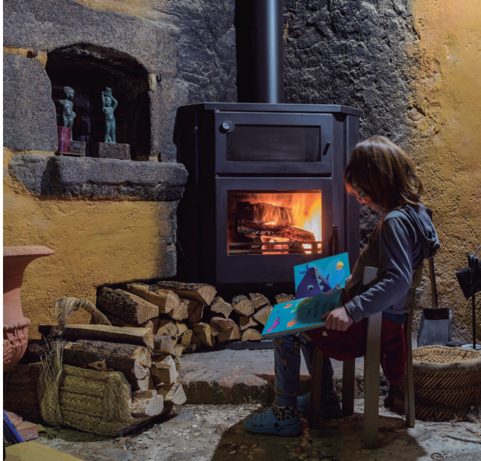
Caldera de calefacció confortable d'una llar rural alimentada amb fusta
