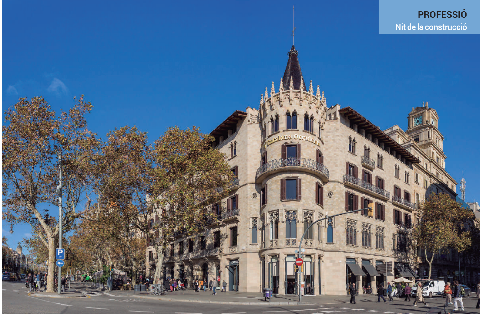
Rehabilitació i reforma del Palau Pascual i Pons a Barcelona (Foto: Chopo)
