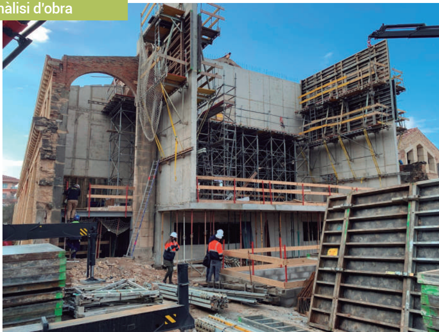
La construcció de la caixa escènica
