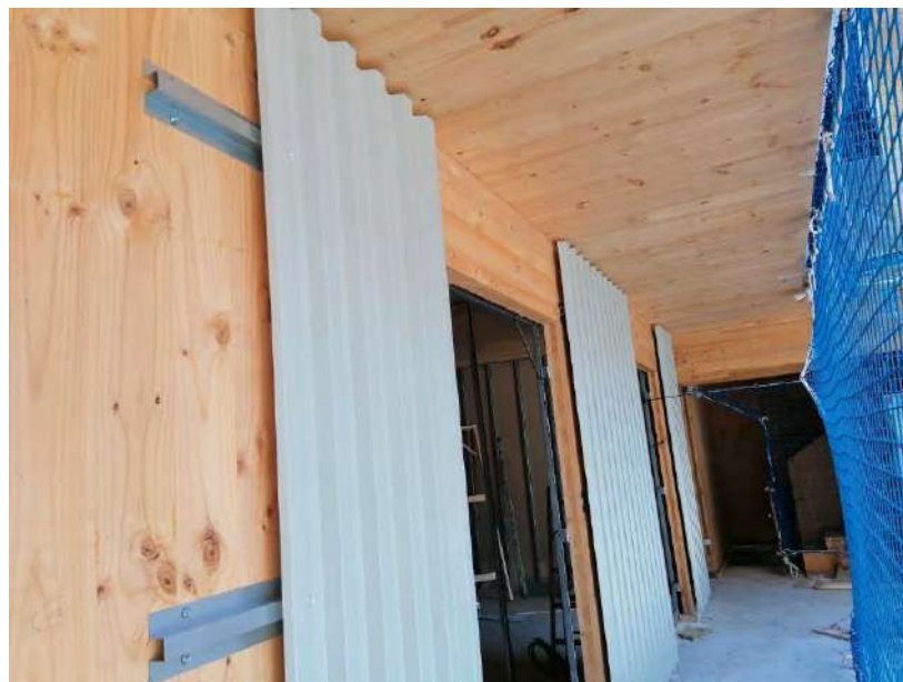
Detall del procés d'instal·lació
