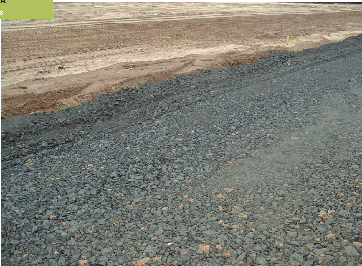
Ús de Cofalit® en subbases de ferms en carreteres Imatge cedida per Inertam
