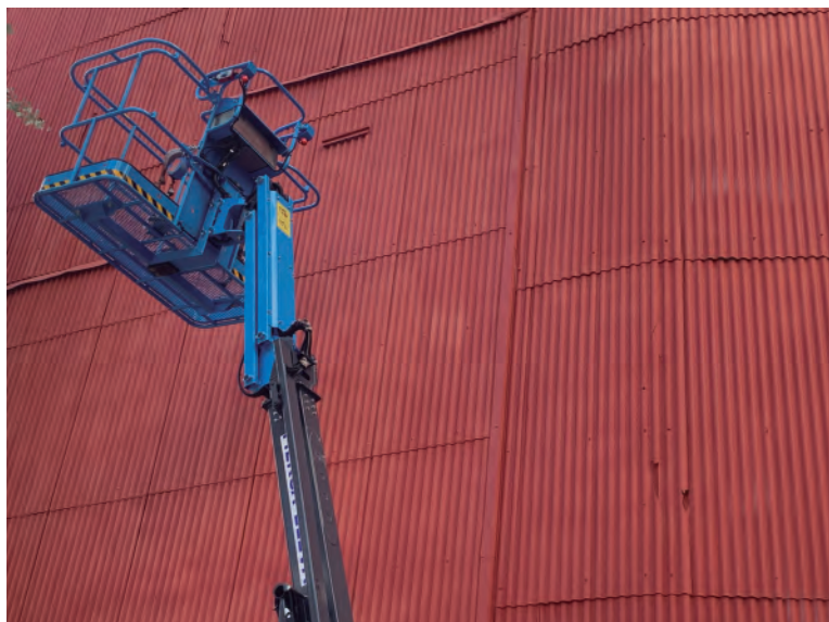
Treballs d'encapsulament d'una mitgera (Foto: Lara Trujillo)
