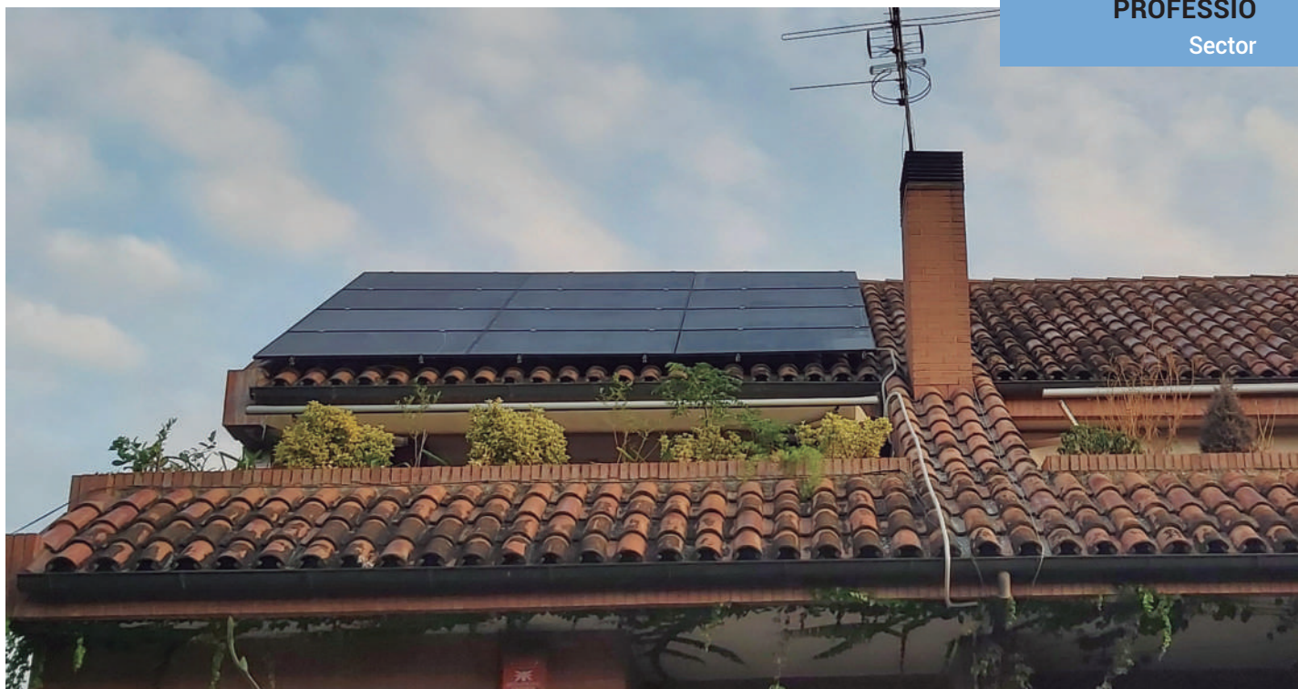
Instal·lació de plaques solars a la teulada
