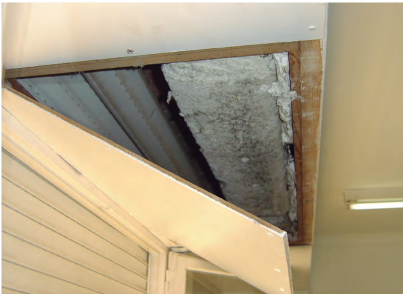
Aïllament friable dins d'una caixa de persiana. Imatge cedida per Joan de Monserrat
