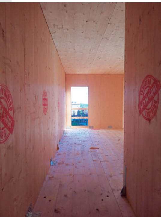
Edifici en construcció amb estructura de fusta
