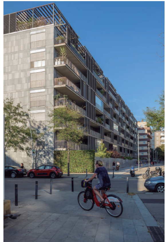
Habitatges de nova construcció al barri del Poblenou
