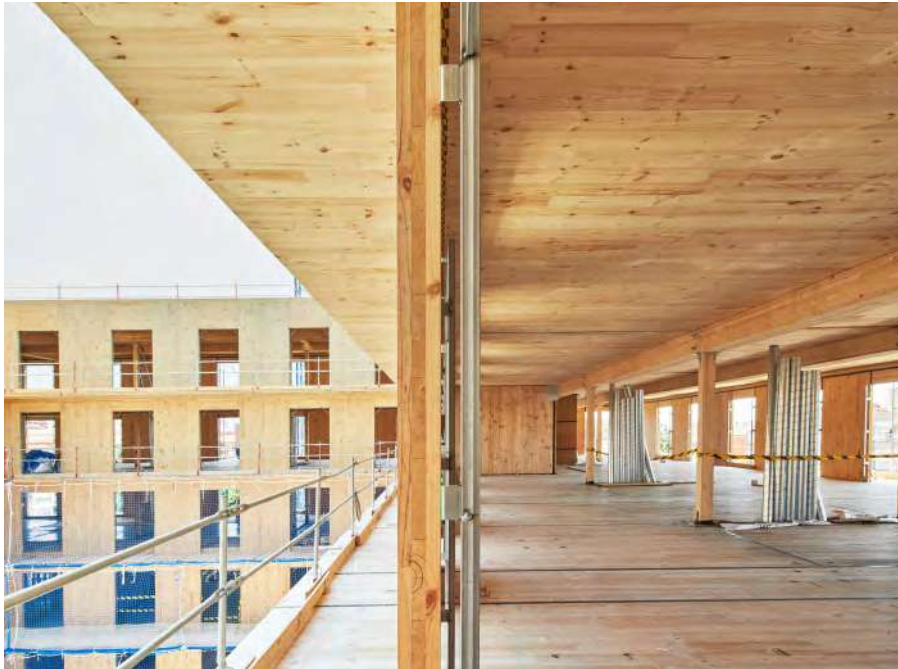
Estructura interior porticada
