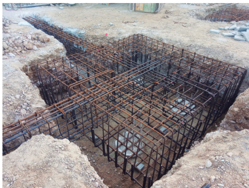
Procés de fonamentació d'un edifici
