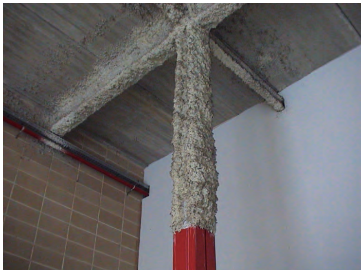
Ignifugació d'estructura metàl·lica molt friable (Imatge cedida per Joan de Monserrat)
