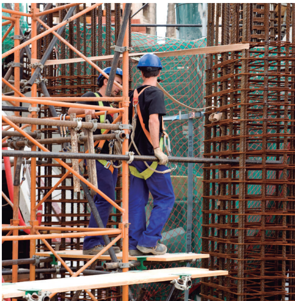
Treballadors de les obres de la Sagrada Família amb les proteccions adients (Foto Chopo)
