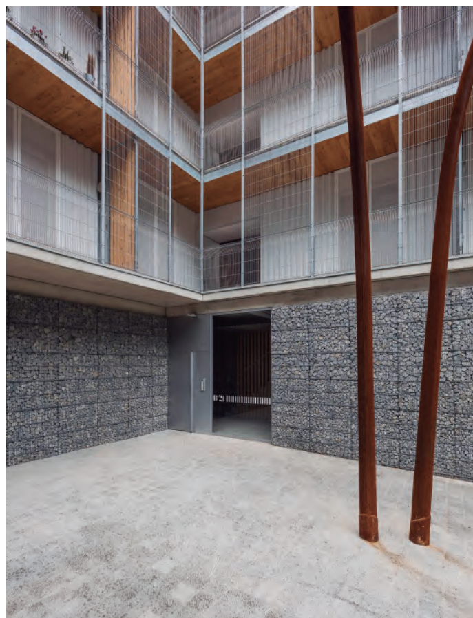
Mur de gabions instal·lat al pati interior
