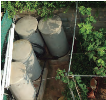
Dipòsits d'aigua de fibrociment (Foto: Lara Trujillo)
