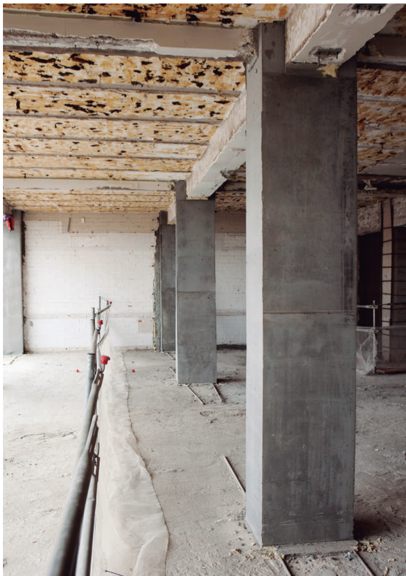
El reforç dels pilars un cop finalitzat
