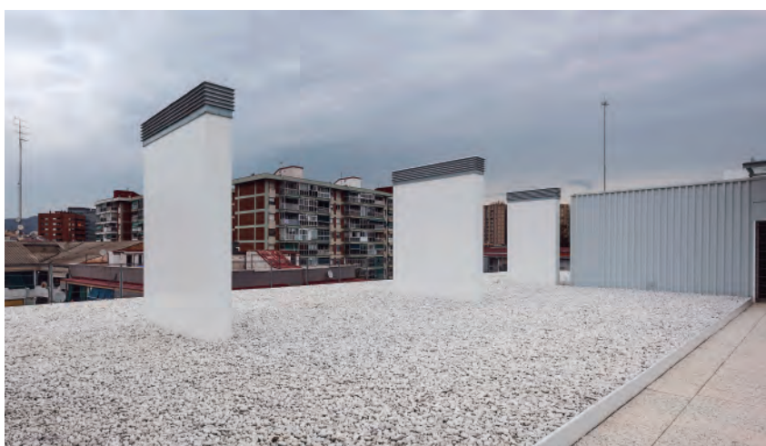
Detall de la coberta de l'edifici
