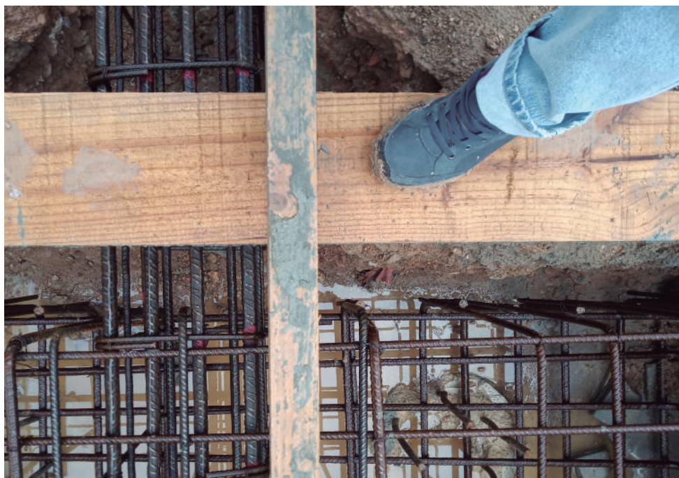
Armat d'una estructura de fonamentació
