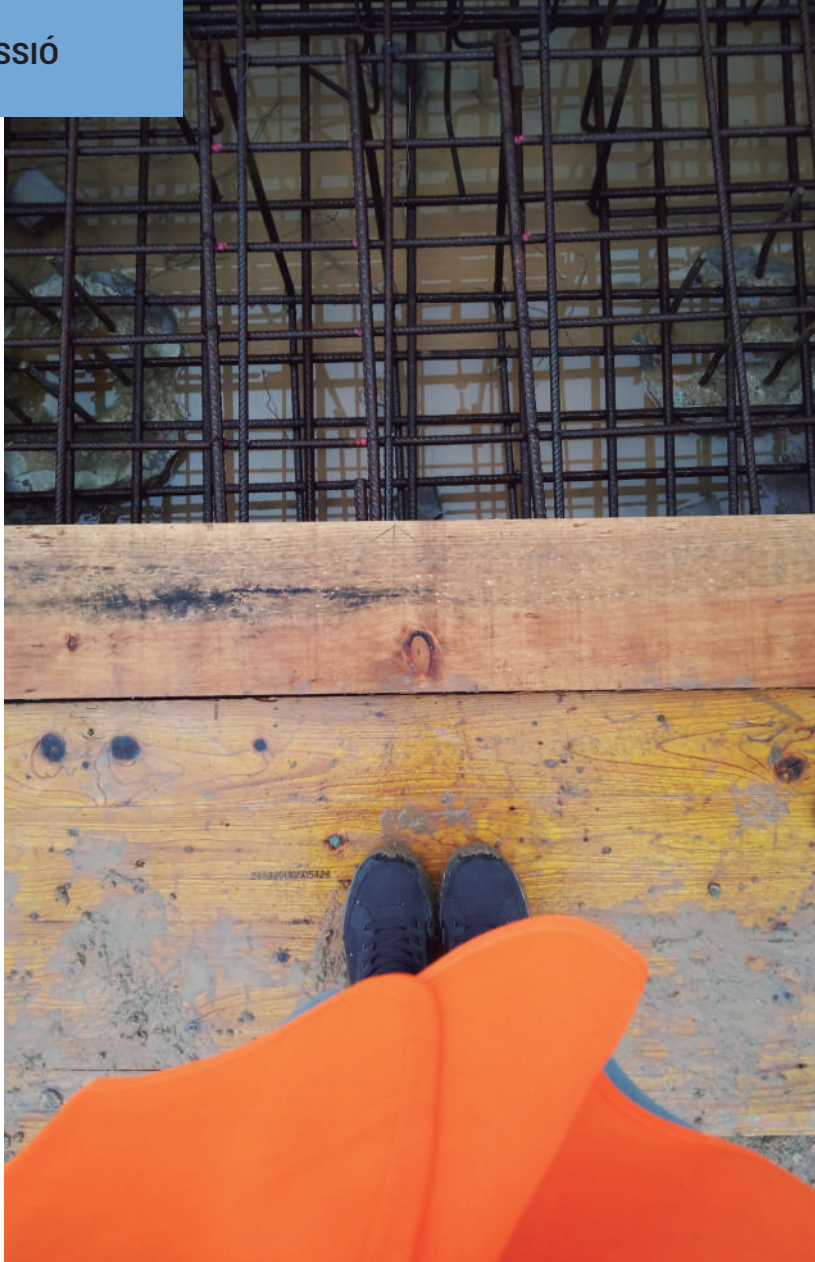
Revisió de l'armat d'una sabata de formigó
