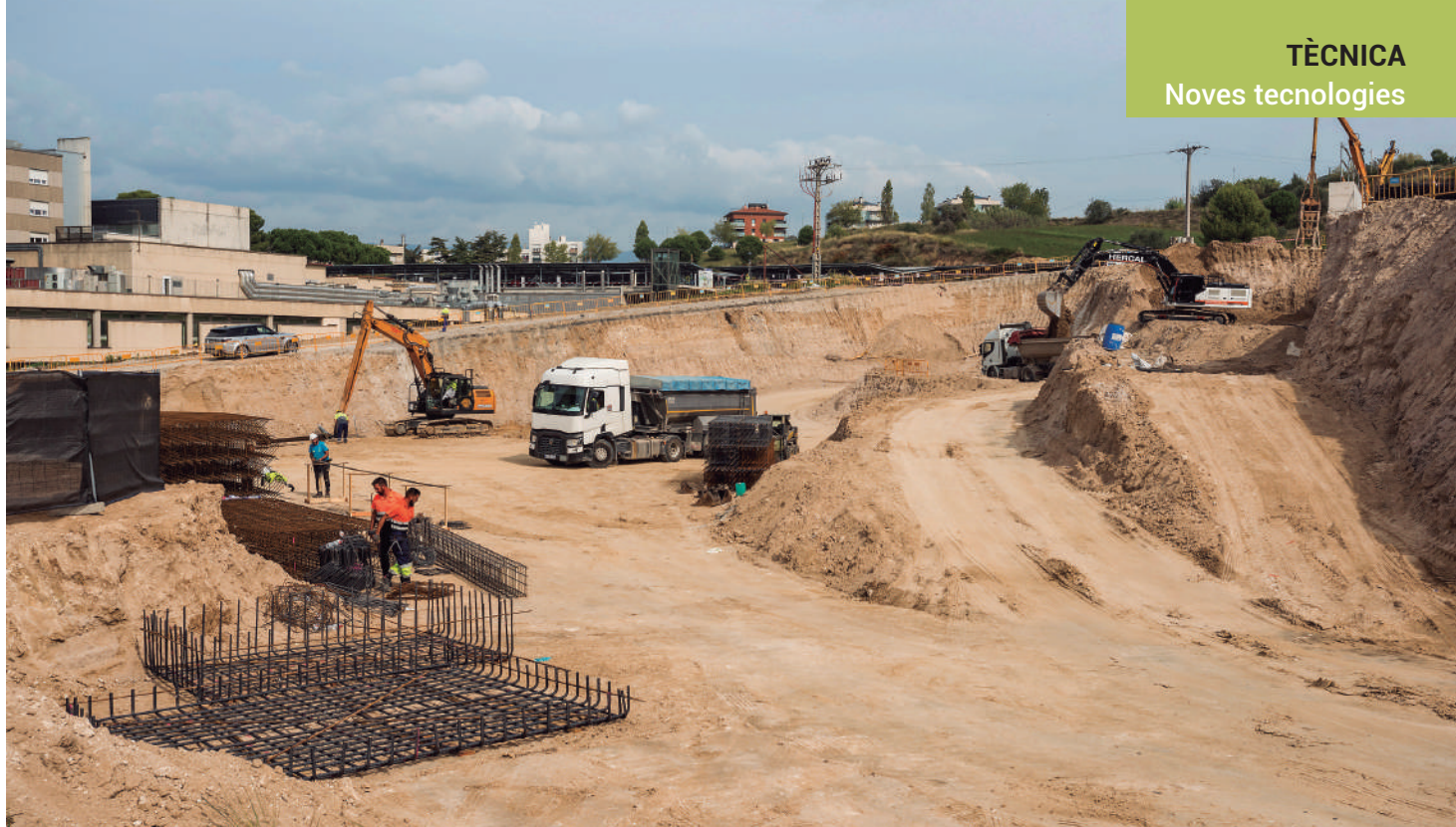
Fase de moviment de terres a l'inici del procés de producció d'una obra
