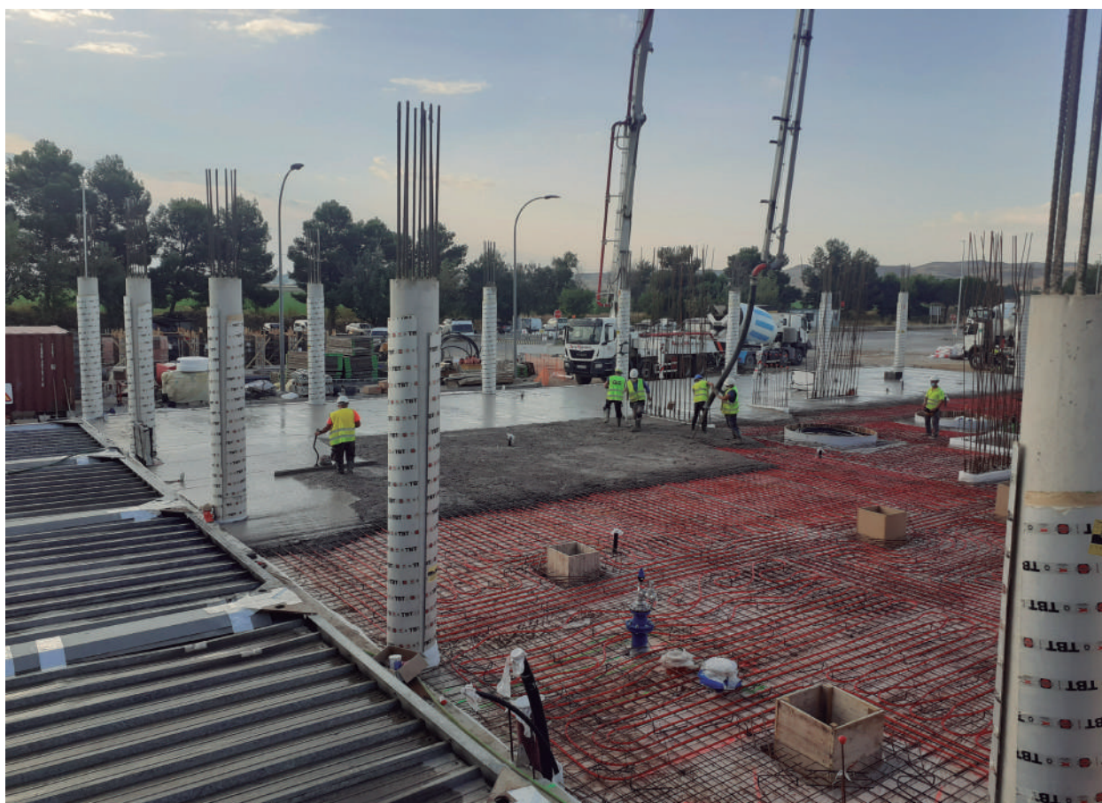
Procés de formigonat del forjat una vegada instal·lat el sistema de climatització
