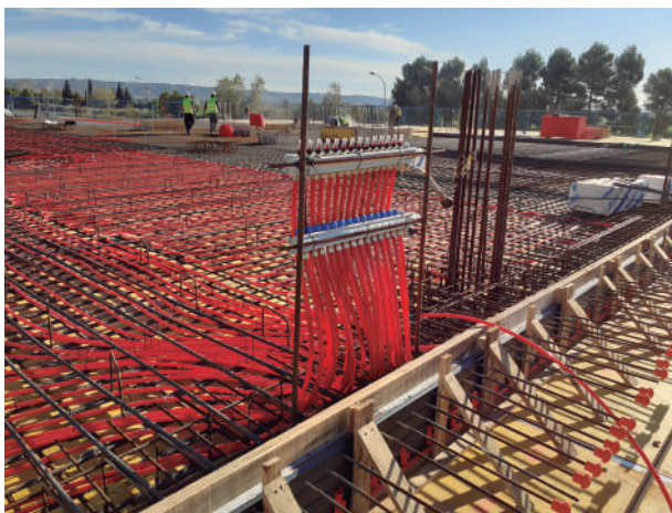
Les diverses fases en el procés d'introducció del sistema de climatització
