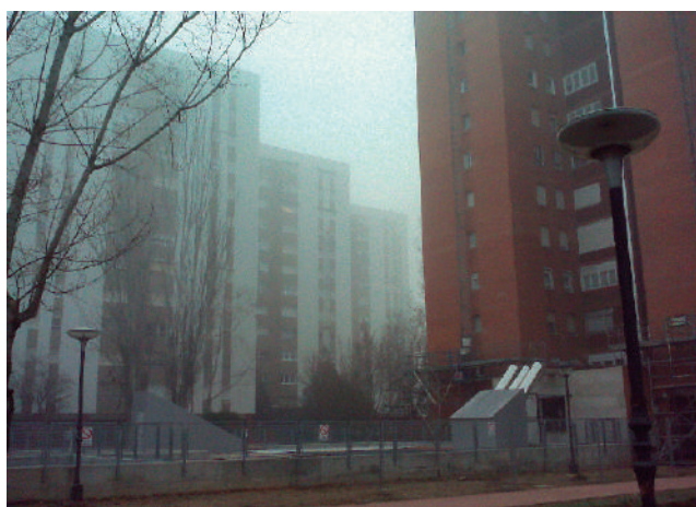
Els edificis a l'esquerra de la imatge amb sistema MAPETHERM. A la dreta sense aïllament exterior
