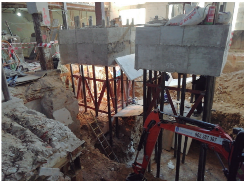
Excavació amb platabandes d'unió provisionals prèvia a l'execució de nou fonamentació (Fig. 5)
