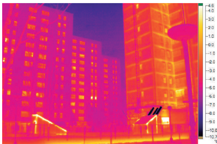
Termografia dels edificis a l'esquerra de la imatge amb sistema MAPETHERM. Els edificis a la dreta no tenen aïllament exterior
