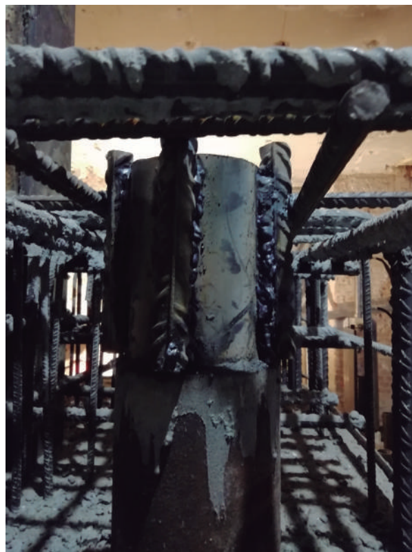
Camisa metàl·lica a través de la qual passa el micropiló solidaritzada amb armadura de fonamentació (Fig. 4)
