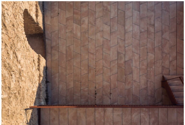
Detall de la nova pavimentació
