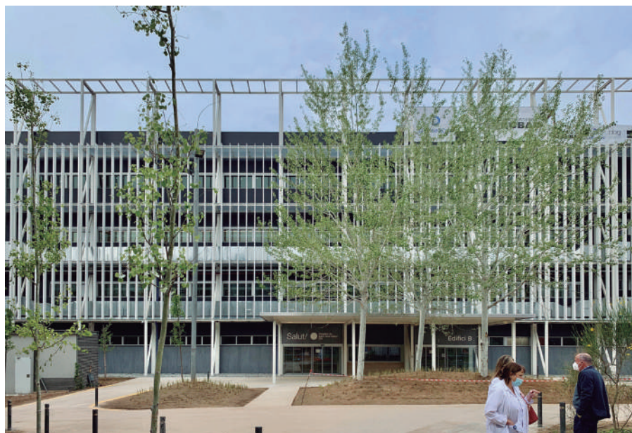
Edifici sanitari a l'Hospital Moisès Broggi a Sant Joan Despí (Foto: Adrià Goula)
