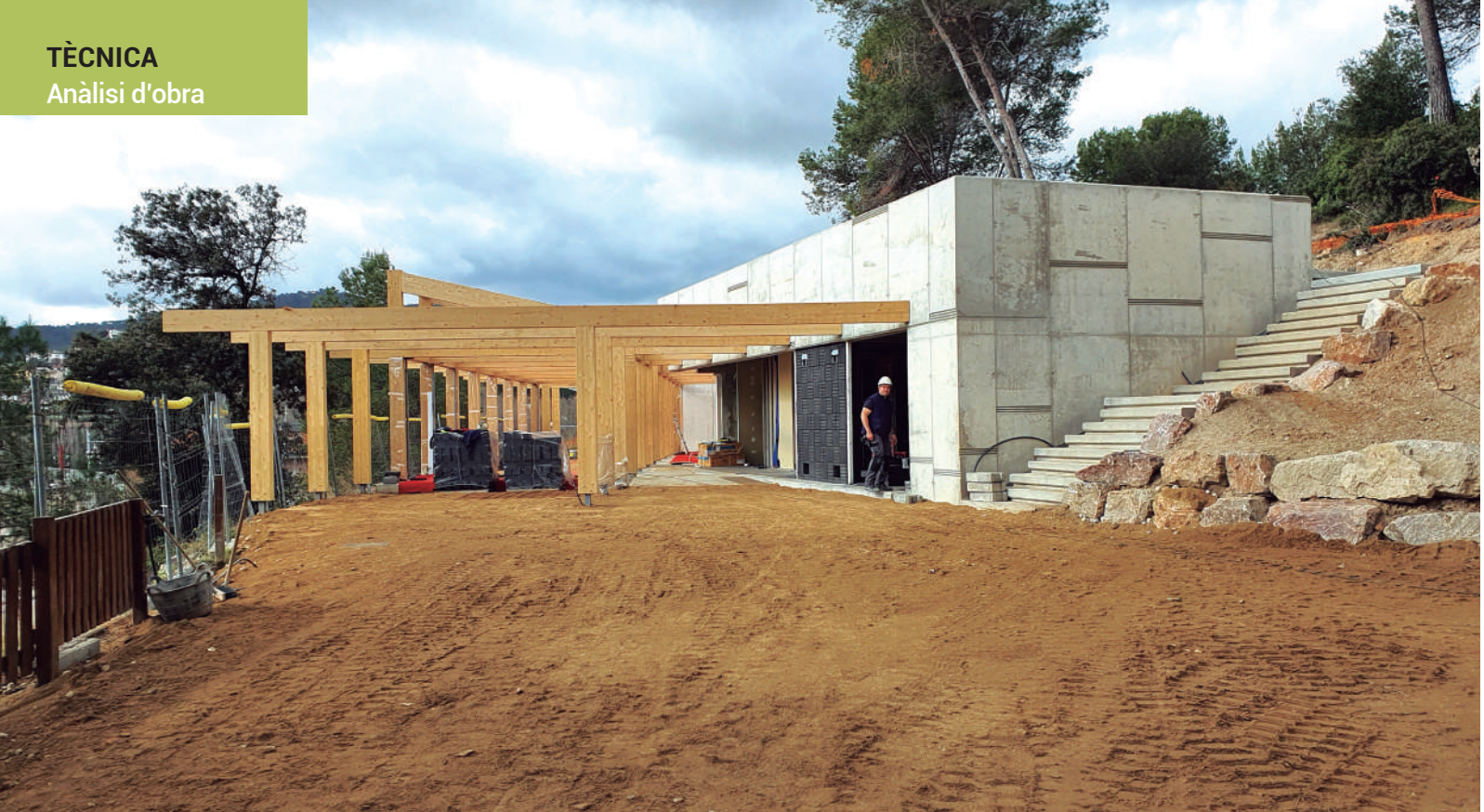
Construcció de l'estructura de fusta adjacent a l'edifici existent
