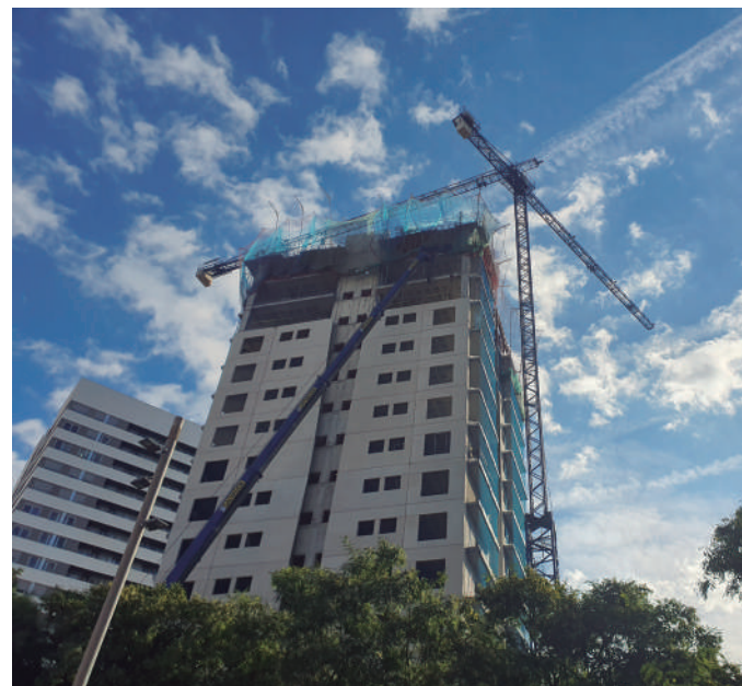
Torre de 77 habitatges a la Plaça Europa de l'Hospitalet de Llobregat (Foto: Sílvia Costa)
