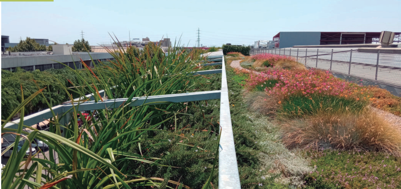
El tipus de coberta determinarà el pla de manteniment © Foto: Eix Verd
