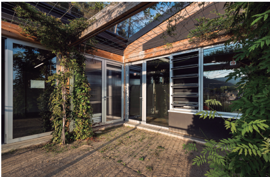
Les imatges mostren el mur Trombe, la seva posició a l'estiu i el procés d'obra
