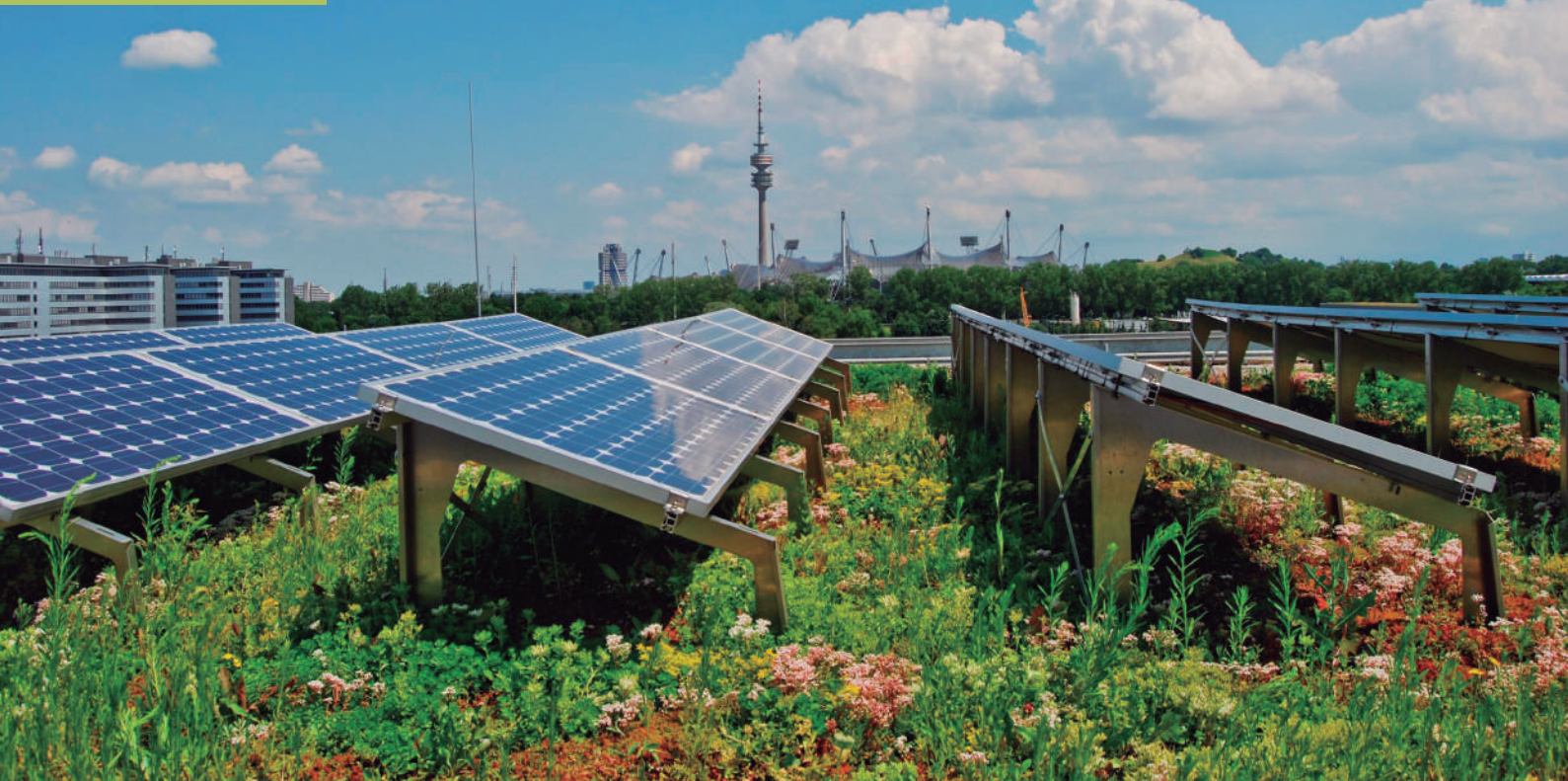
Coberta que combina la vegetació i plaques solars a Alemanya (c) Foto: Zirco
