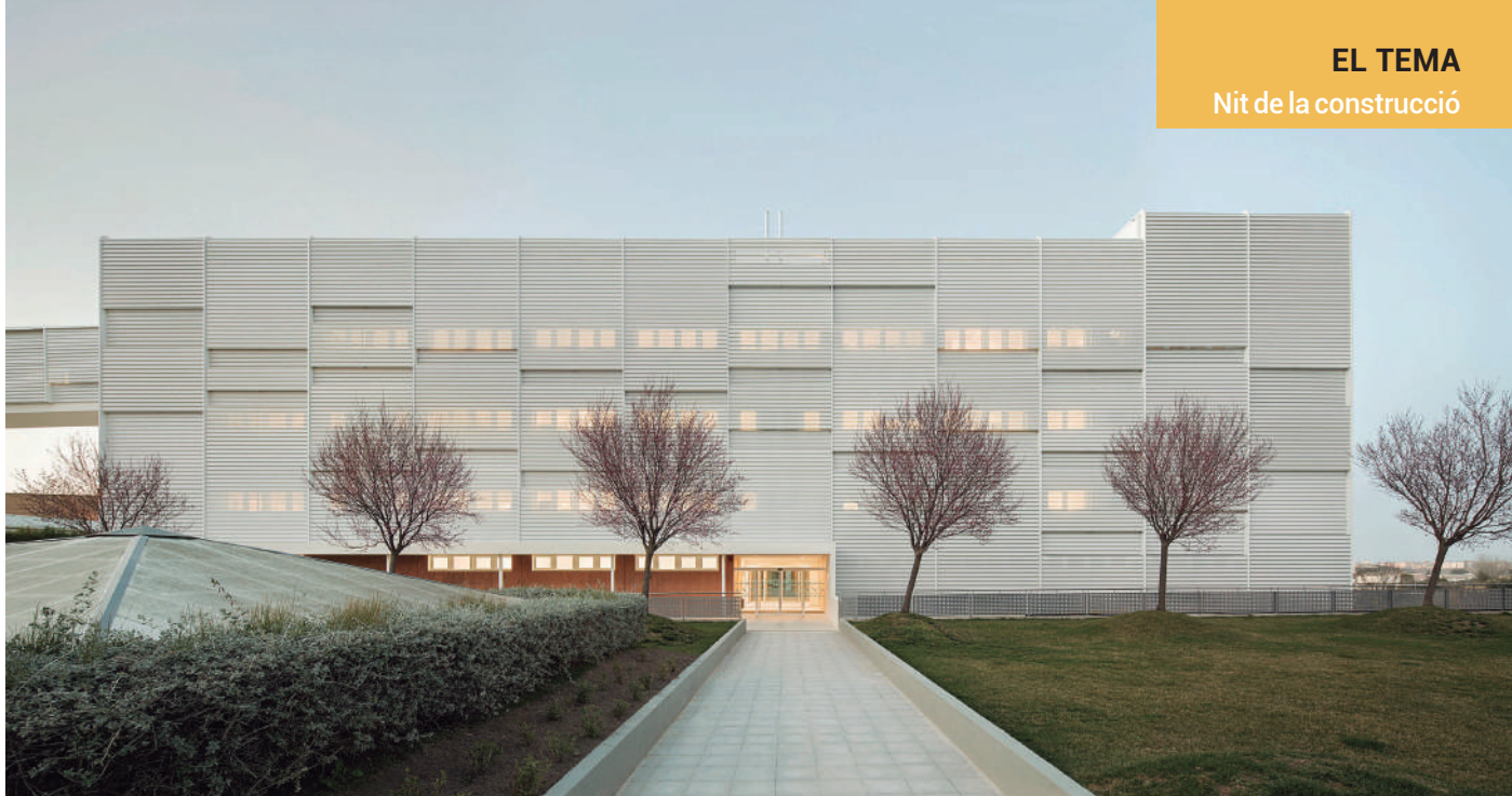
Edifici sanitari a l'Hospital Arnau de Vilanova de Lleida (Foto: Del Río Bani)
