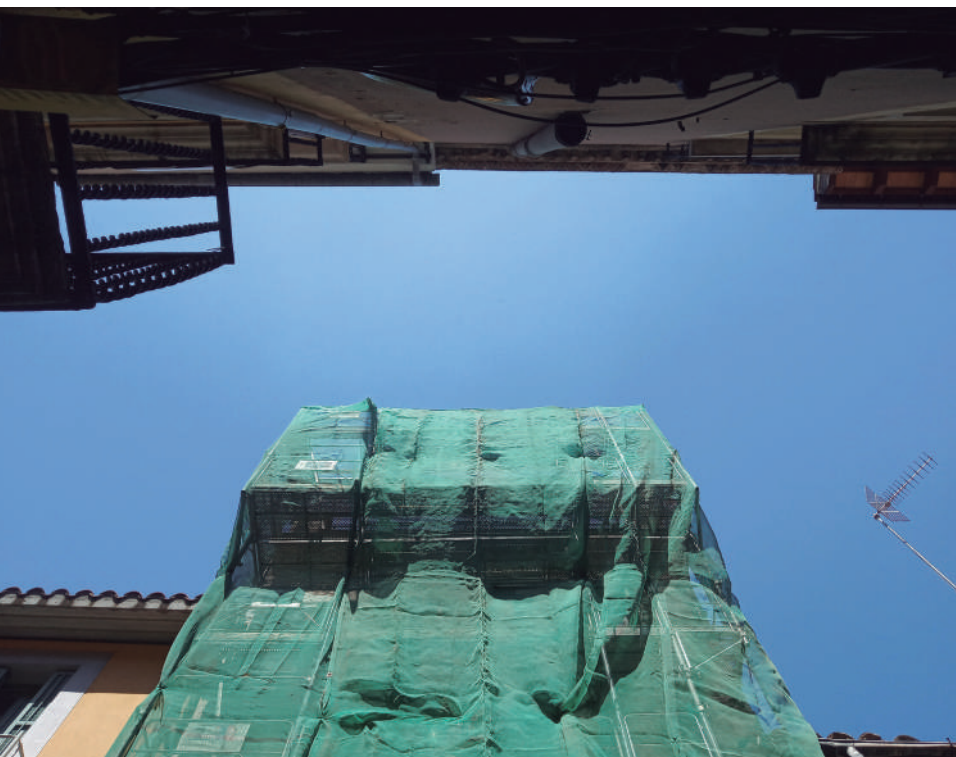
Obra de rehabilitació (Foto: Lis Gadea)
