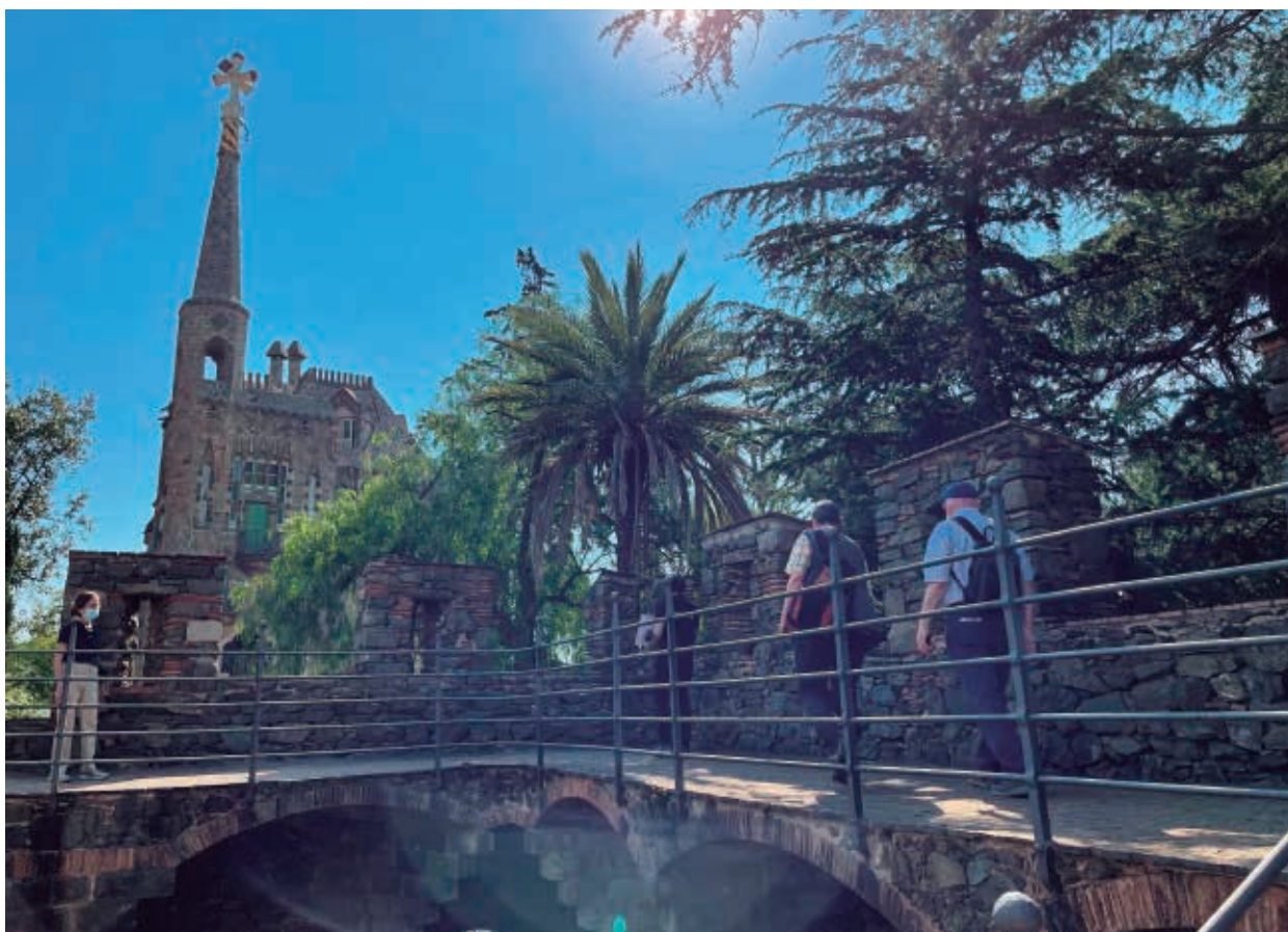
La Torre Bellesguard projectada per Antoni Gaudí sobre les restes d'una construcció medieval
