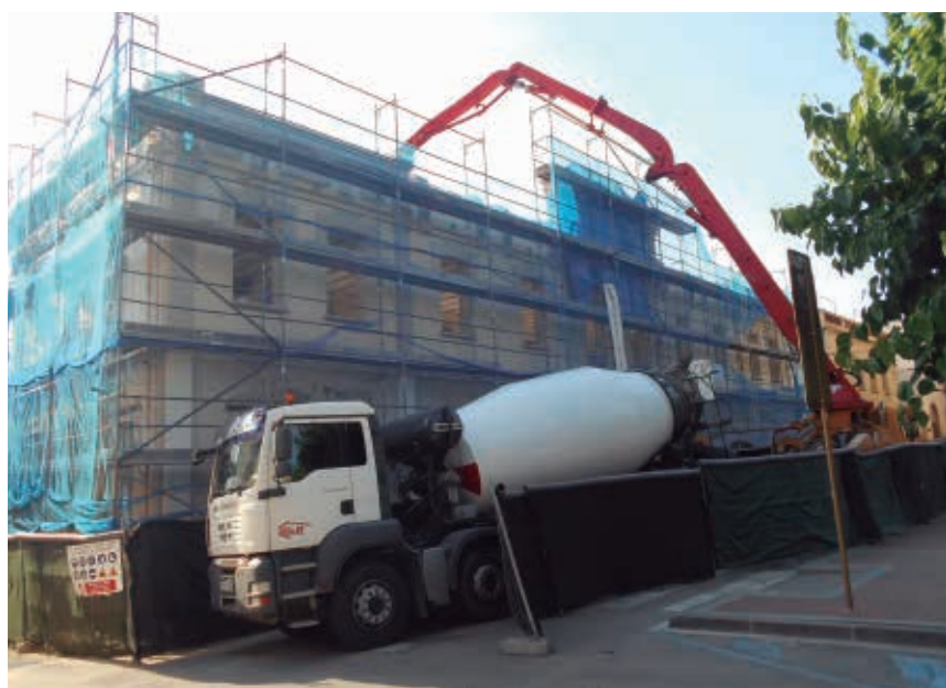
Consolidació i reparació de l'edificació original
