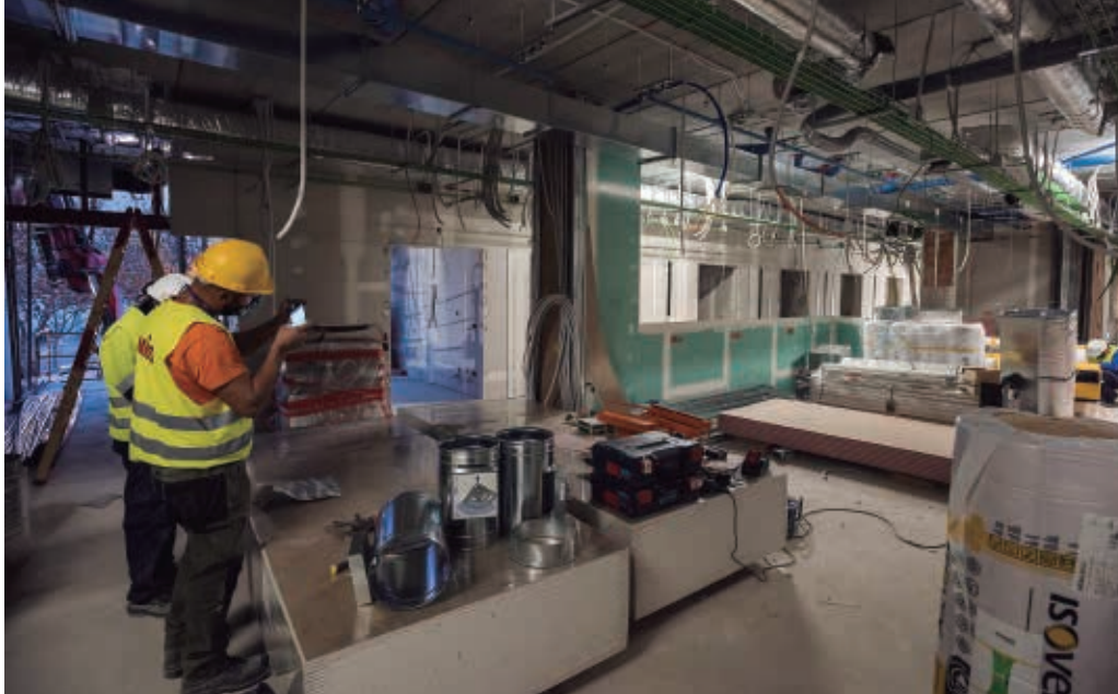
A baix, instal·lació de la passera entre la nova unitat Covid i el cos de l'Hospital
