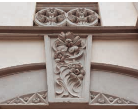
Alguns detalls de façana
