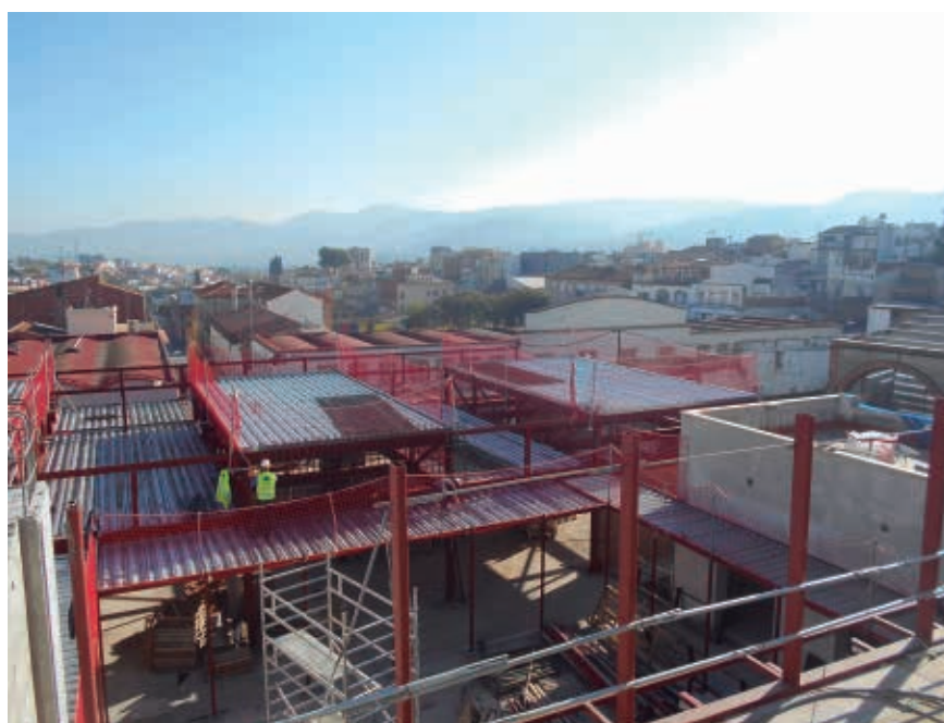
Muntatge de l'estructura porticada de l'edifici nou
