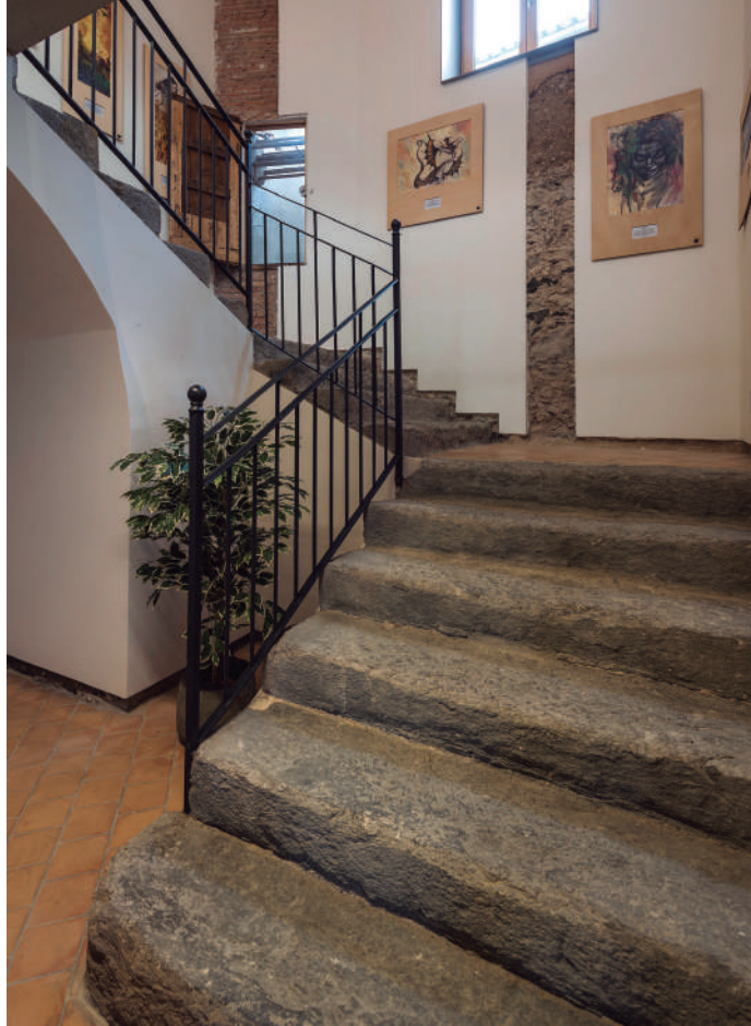
En aquest parament de l'escala s'aprecia una de les franges sense acabat que deixa a la vista l'obra de fàbrica estructural
