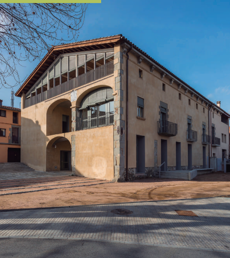
Façana lateral de l'edifici i placeta adjacent la qual envolta les bandes de llevant i migdia i completa el conjunt
