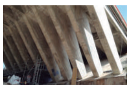
Control de qualitat del formigó armat Data: 25/06/2020
