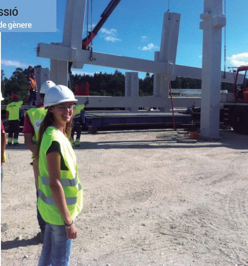
Arquitecta tècnica dirigint el procés d'execució d'una obra
