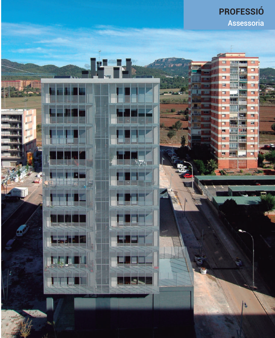
Les noves instal·lacions d'alta eficiència pretenen millorar la qualitat de l'aire a les ciutats
