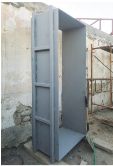
Reforç de les obertures en els murs de tàpia
