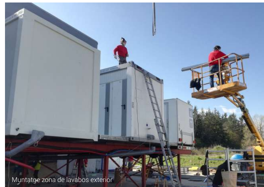
Muntatge sala 1 zona magatzem
