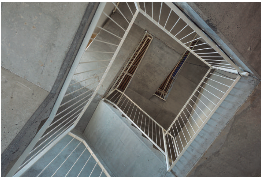
Escala de servei i d'emergència realitzada en formigó armat
