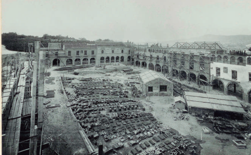
Fotografia de les obres del Poble Espanyol de Montjuïc: plaça major en construcció amb la barraca d'obres. Fons privat de la família Reventós.
