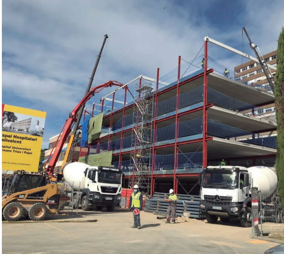
Direcció d'execució i coordinació de seguretat i salut de l'edifici hospitalari polivalent de l'Hospital Germans Trias i Pujol de Badalona
