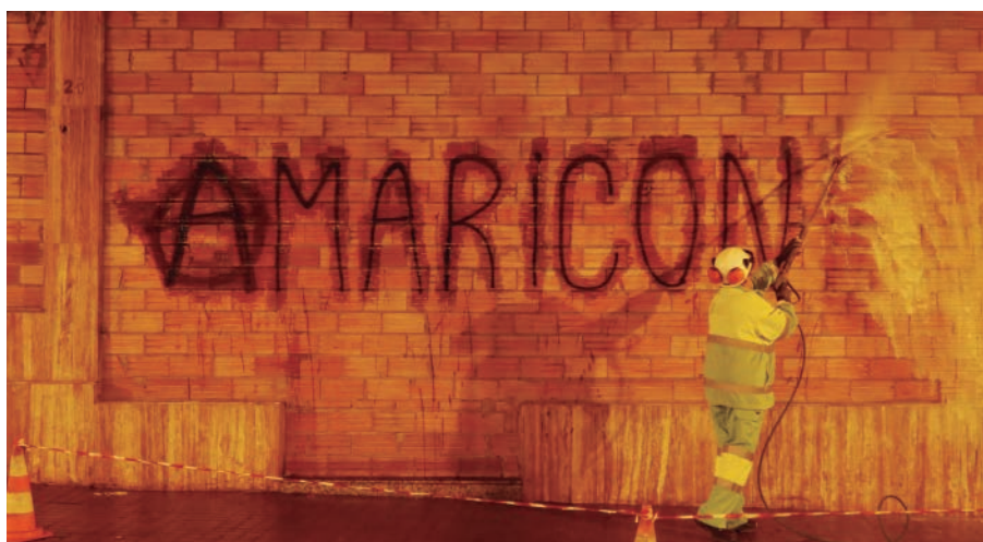
Imatge d'operari netejant paret al carrer Pujades de Barcelona
