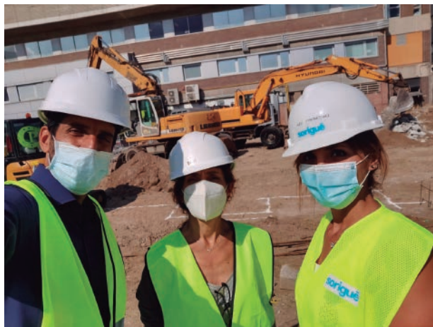
Visita d'obra de la DEO i CSS a l'edifici hospitalari polivalent Hospital Germans Trias i Pujol de Badalona-Covid
