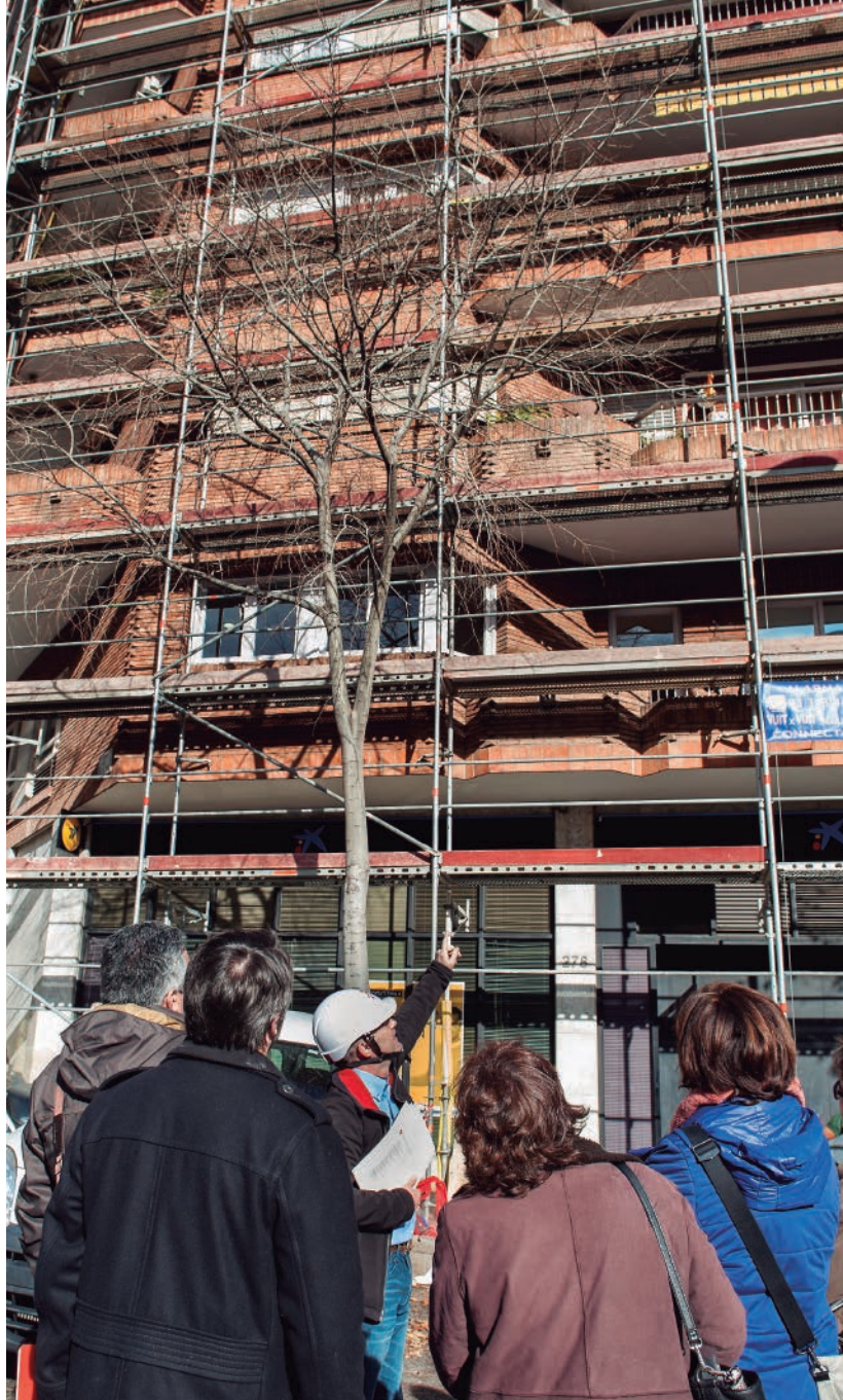
Rehabilitació d'un edifici d'habitatges
