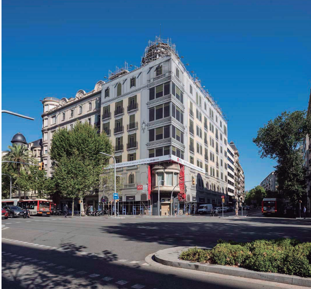
Rehabilitació integral d'un edifici al centre de Barcelona
