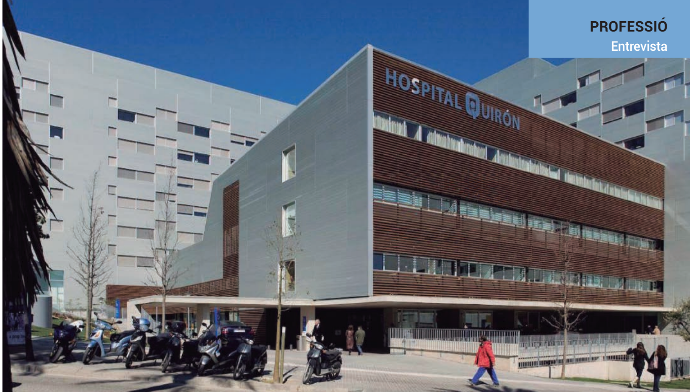
Direcció d'execució i coordinació de seguretat i salut de l'Hospital Quirón de Barcelona
