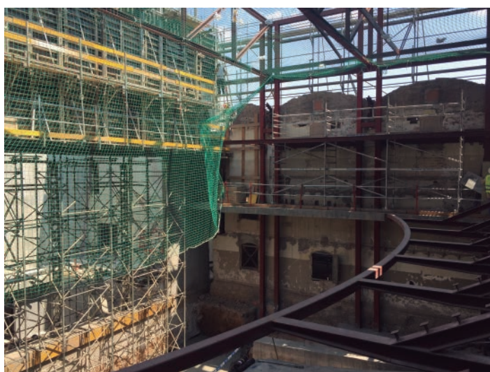
Obres al Teatre de l'Artesà del Prat de Llobregat (Foto: Pep Sau)
