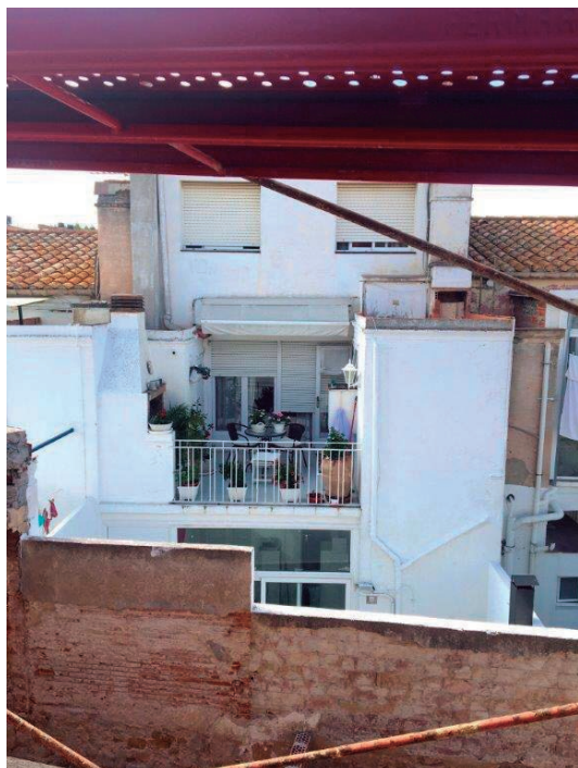
Obres de rehabilitació
