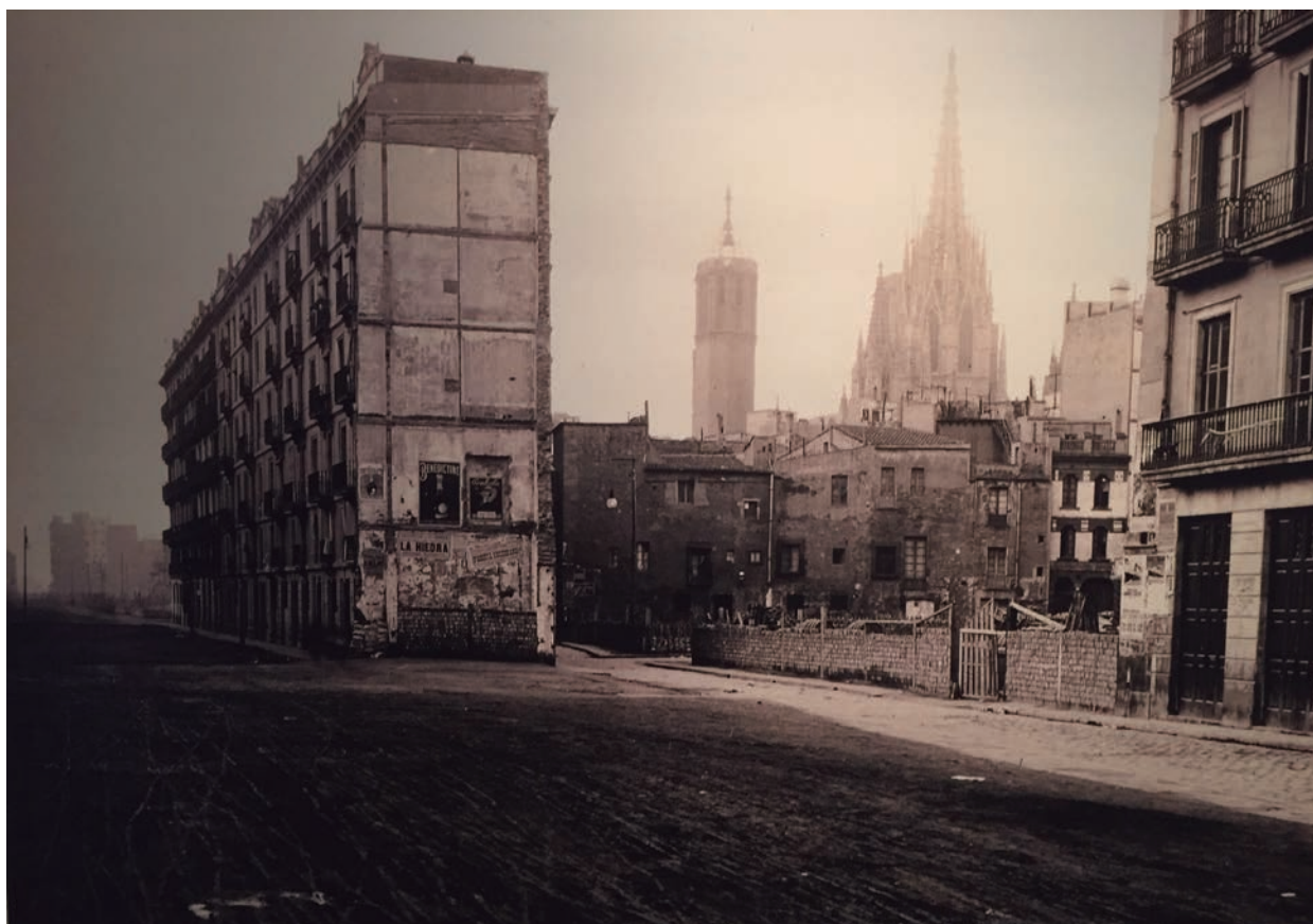
La Via Laietana en construcció a l'alçada del carrer del Dr. Joaquim Pou, amb la Catedral al fons.
