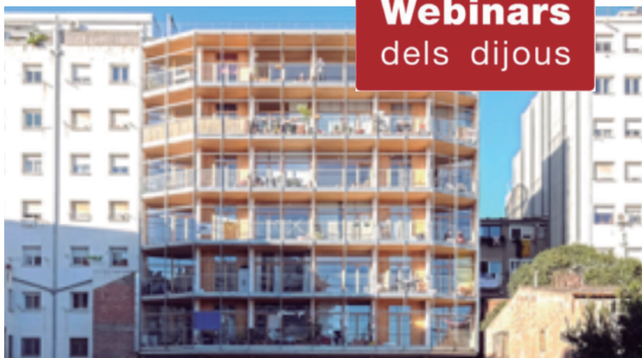
Sessió webinar dedicada a la direcció d'execució de l'edifici d'habitatges plurifamiliar La Borda al barri de Sants de Barcelona
