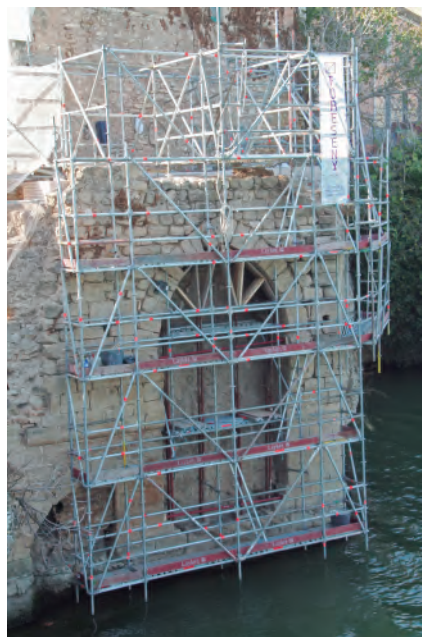
Instal·lació de bastida penjada
