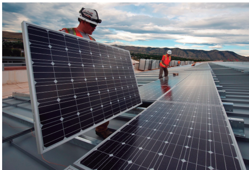
Instal·lació de panells captadors d'energia fotovoltaica en un edifici existent
