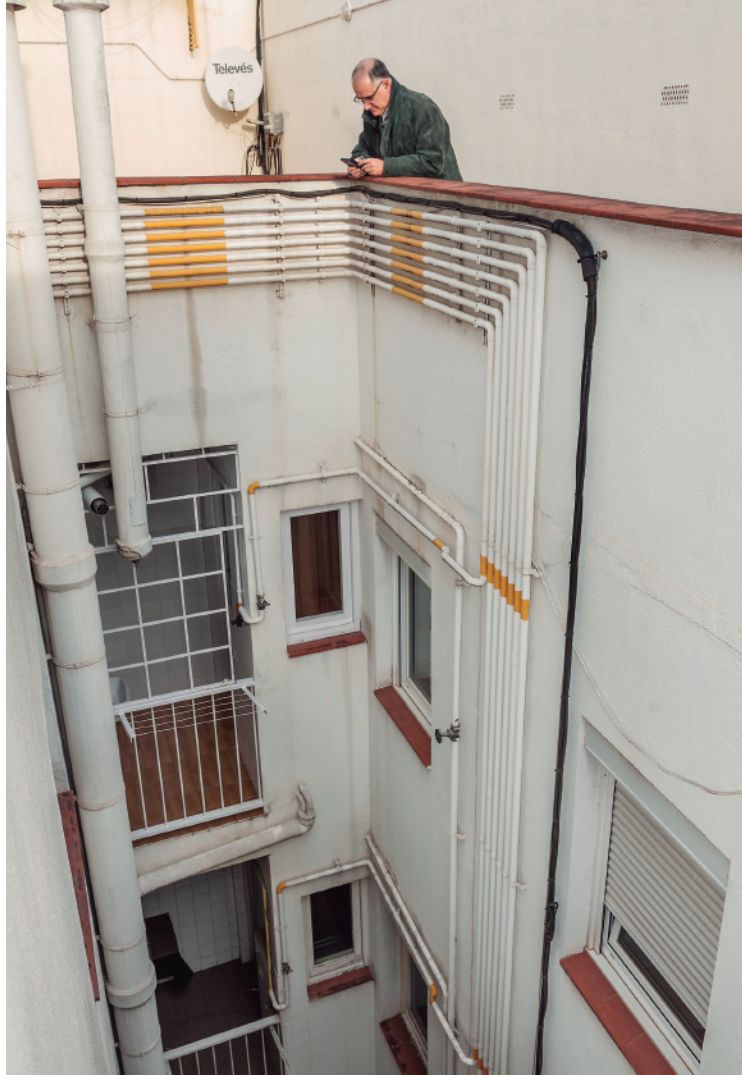
Revisió de les zones comunes de l'edifici. (Foto: Chopo)
