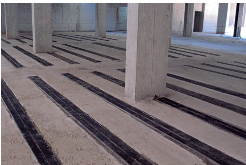
Reforç d'estructures de fibra de carboni
