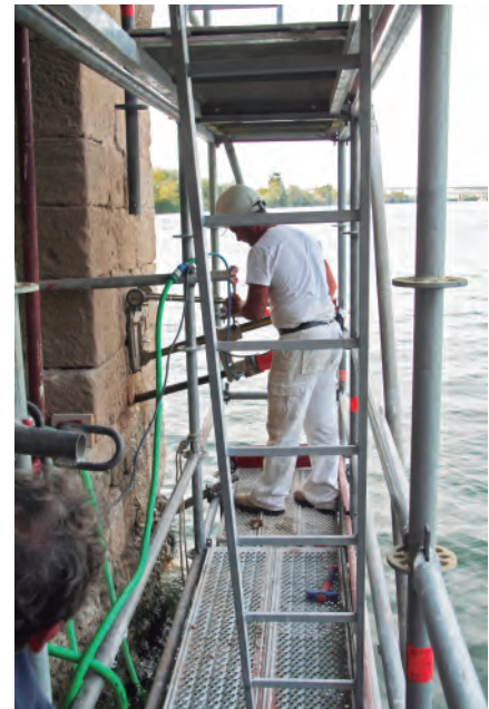
Treballs d'ancoratge del parament de l'arc a la roca
