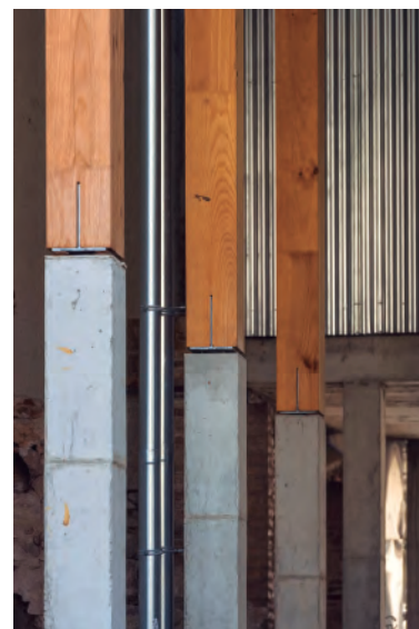
Encontre estructura formigó-fusta
