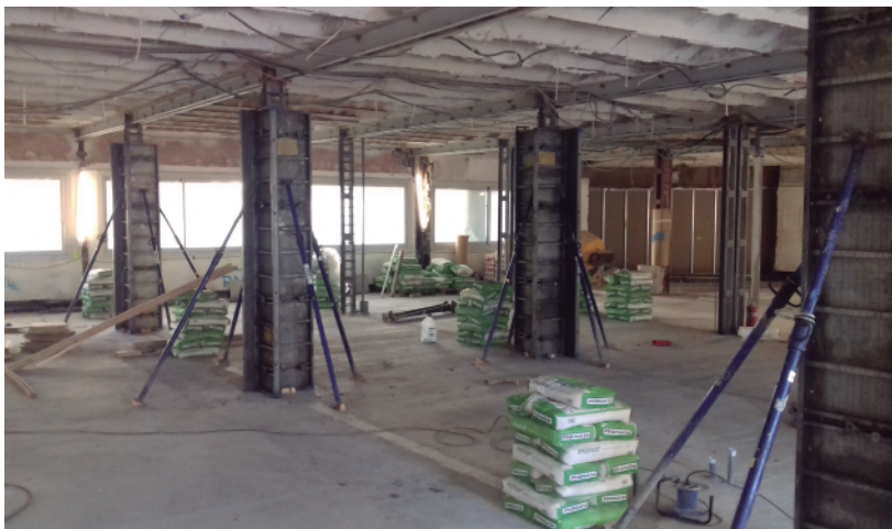
Reforç d'estructures Propam Repar Techno
