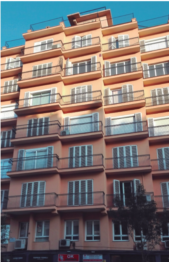
Edifici rehabilitat a Barcelona
