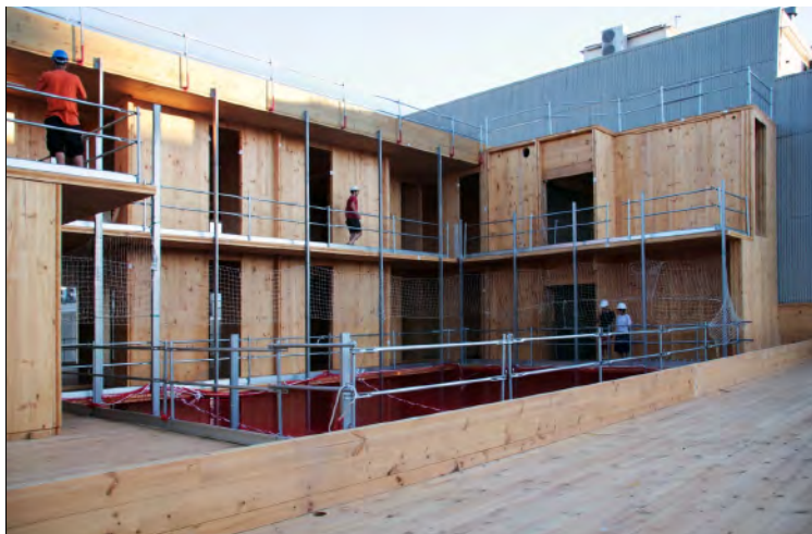
Muntatge de l'estructura amb CLT: Cross Laminated Timber
