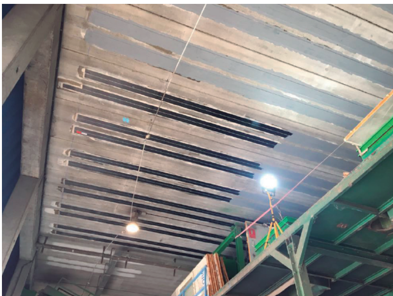
Reforç d'estructures de fibra de carboni amb productes avalats pel Sistema de Qualitat que té Prop-amsa segons la norma ISO 9001
