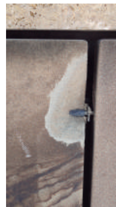
Trencament del full exterior per dilatació tèrmica de l'ancoratge. Font pròpia
