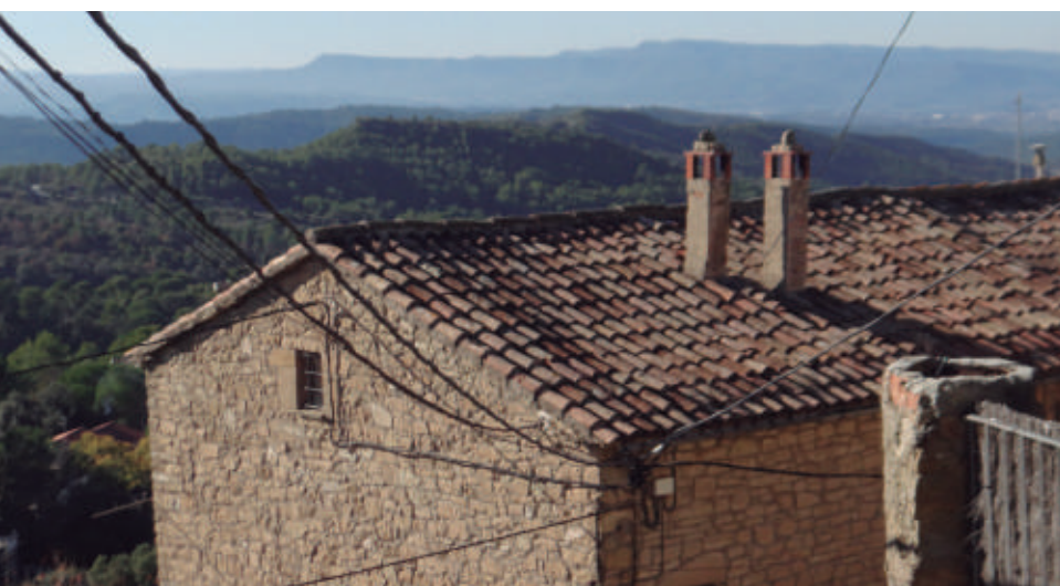
Tot i que va ser reurbanitzat fa pocs anys el nucli de Talamancá pateix la invasió dels cables en espais públics i privats
