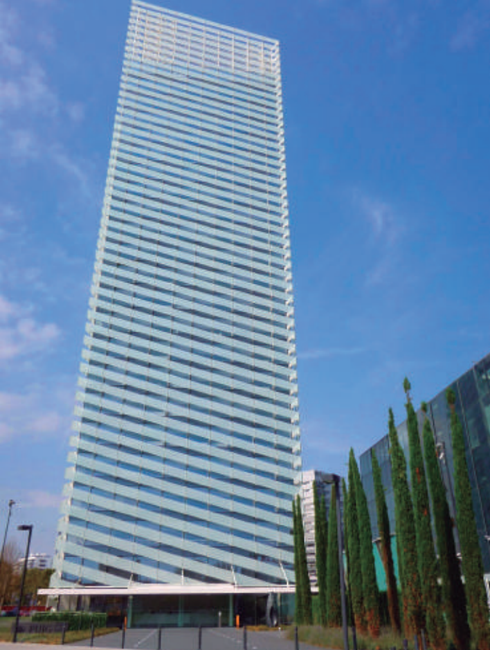
Torre Puig a L'Hospitalet de Llobregat
