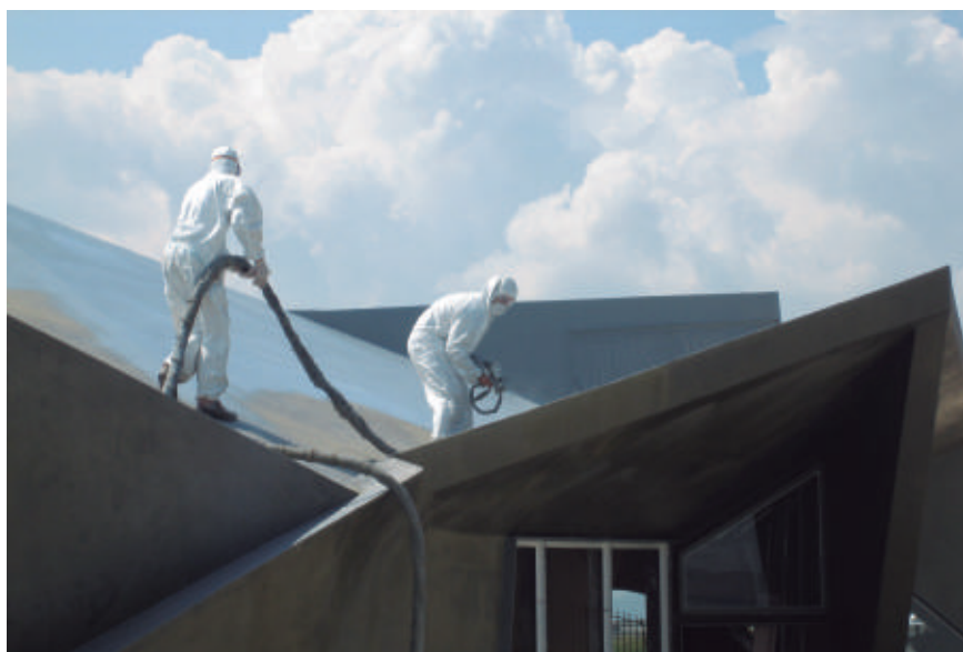
Aplicació de capes de bituminós
