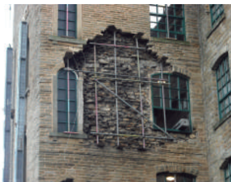
Desvinculació del full exterior. Font https://www.helifix.co.uk/
