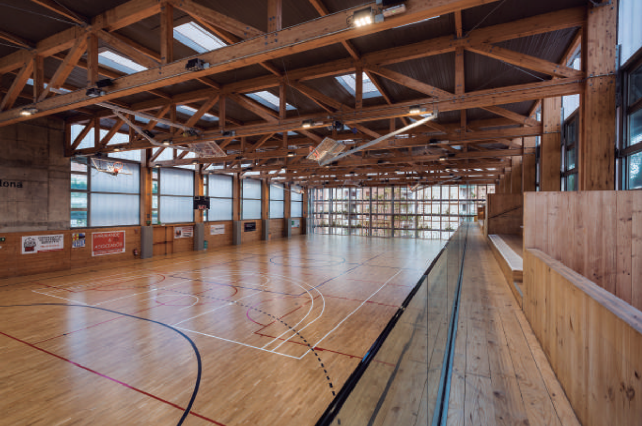
Vista general on es pot apreciar la tipologia de l'estructura i les grans llums entre suports
