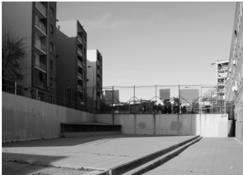
Foto de l'estat previ a la intervenció actual
