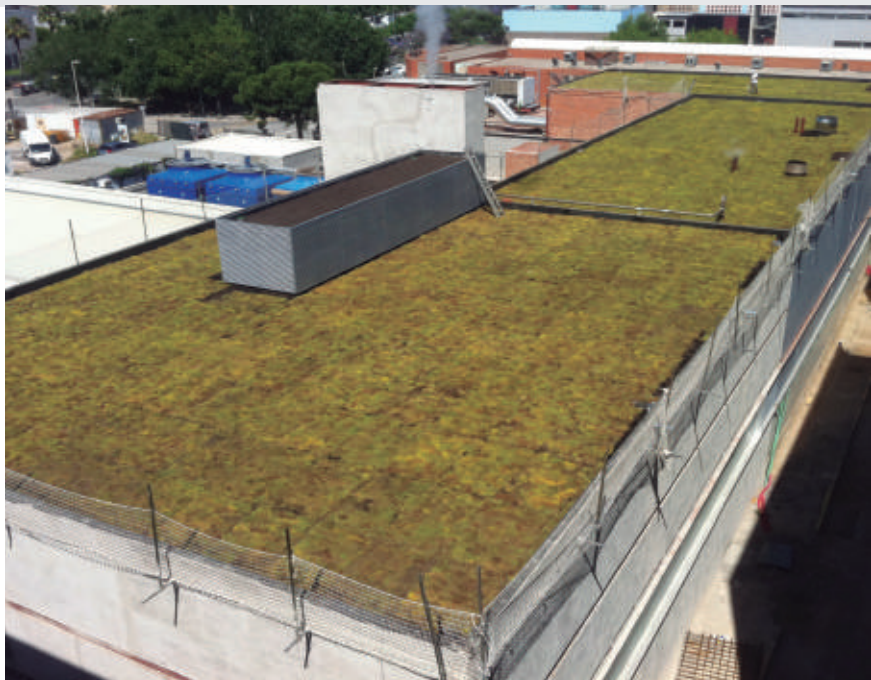
Coberta Sopranature Sedum Mix Mat. Hospital de Bellvitge
