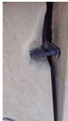
Trencament del full exterior per dilatació tèrmica de l'ancoratge. Font pròpia
