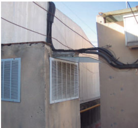
Instal·lacions de telefonia en un terrat de Barcelona: part de les conduccions estan anul·lades però mai s'han retirat
