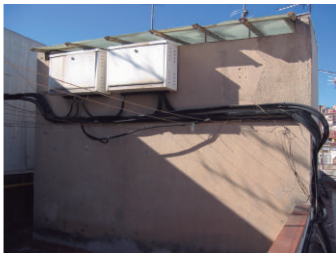
Instal·lacions de telefonia en un terrat de Barcelona: part de les conduccions estan anul·lades però mai s'han retirat
