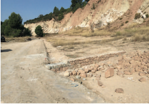
Construcció de murets de pedra successius
