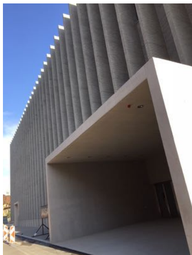
Detalls de la façana principal de l'edifici de formigó amb façana ventilada ceràmica
