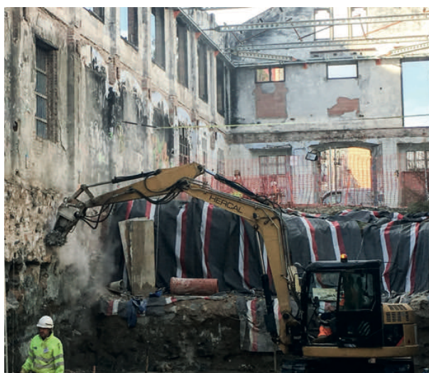
Fressat dels fonaments originals per aconseguir un sol plànol amb el terreny consolidat
