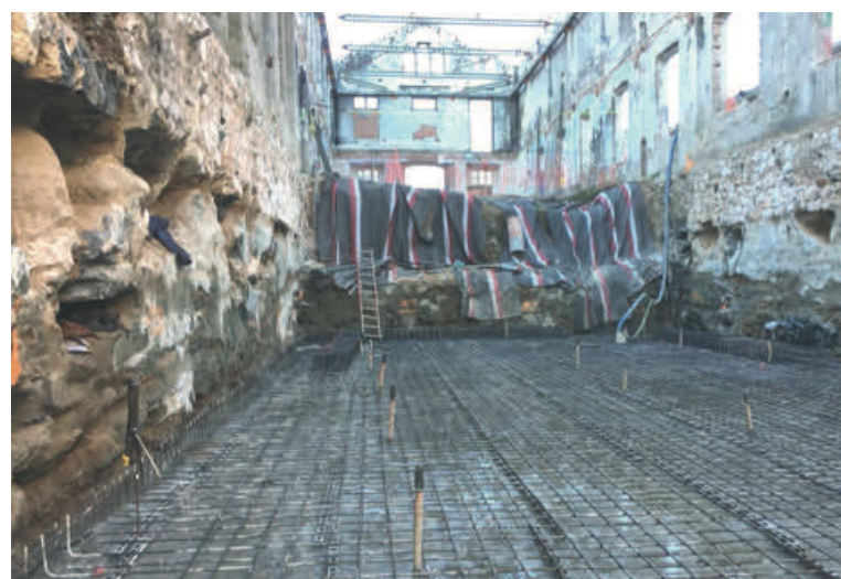
Armadura de la llosa inferior del soterrani.
