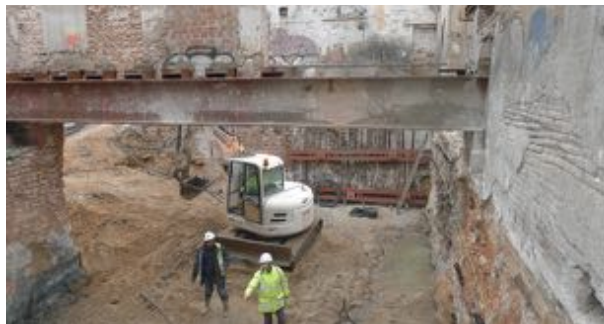
Encofrats del mur del soterrani i estintolament del mur de façana per a pas de l'estructura del soterrani.
