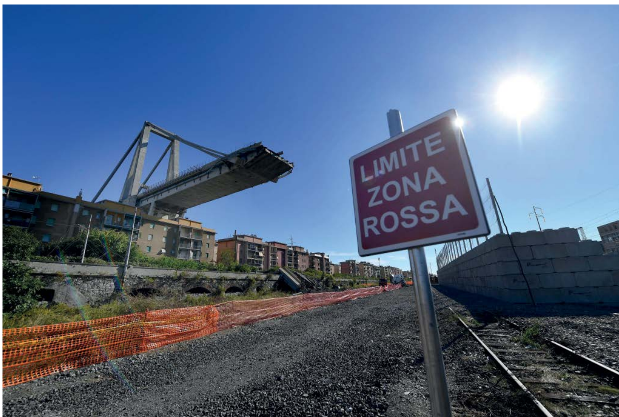
Imatge 11. El pont en fase de demolició. Font: tv2000.it - Foto: Luca Zennaro /ANSA
