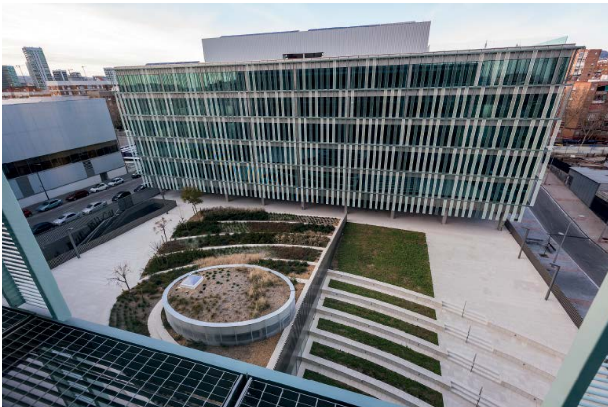
Vista general del nou complex d'oficines
