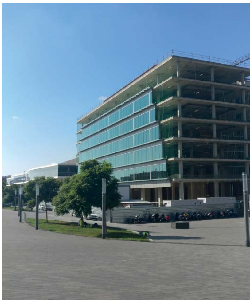
El projecte s'ha desenvolupat amb metodologia BIM i l'edifici ha obtingut la certificació Leed Platinum i l'etiqueta Well
