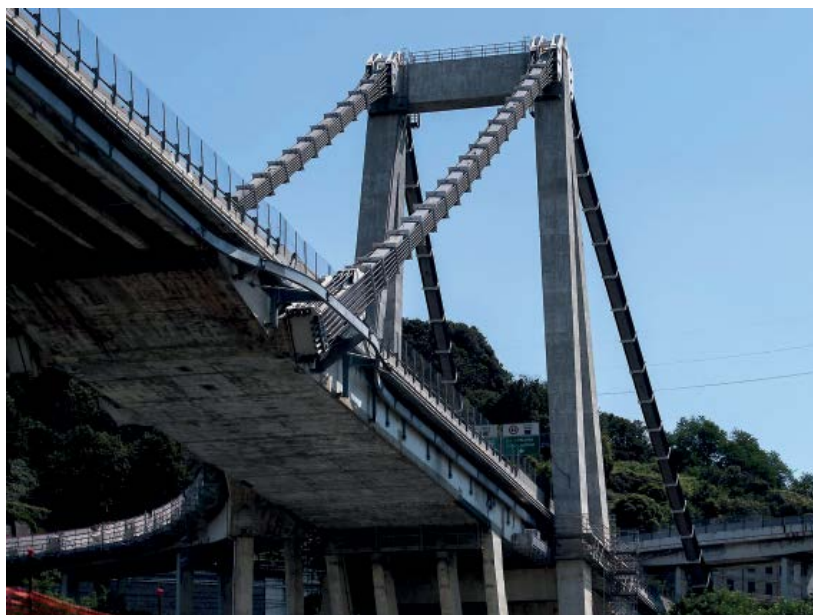
Imatge 9. Tirants substituïts a la pila 11. Font: liberoquotidiano.it
