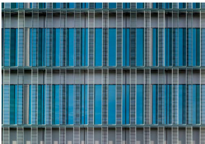
Detall de la doble façana del conjunt amb els mòduls verticals de xapa
