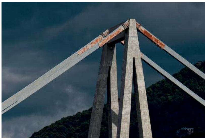
Imatge 10. Reforç del tram superior dels tirants de la pila 10. Font: ilgiornale.it. Foto: AFP/LA Prese
