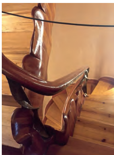
A l'esquerra i de dalt a baix, presència de fongs sota el trencadís de vidre de la façana posterior, i a la dreta, els arrambadors de fusta i la barana de l'escala al soterrani
