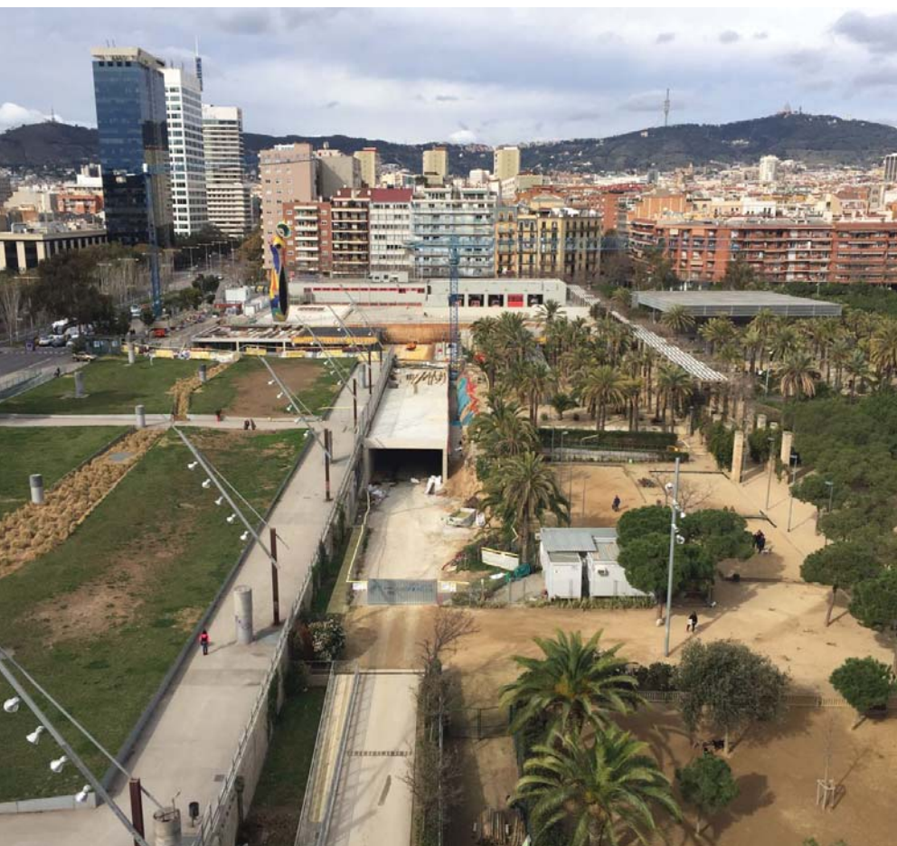
Una vista general de l'obra en fase d'execució
