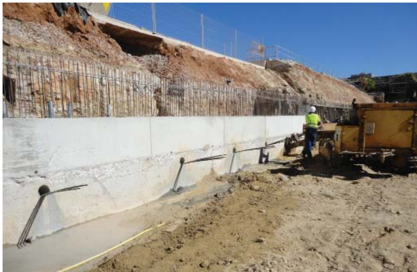
Treballs d'ancoratge de la base de fonamentació
