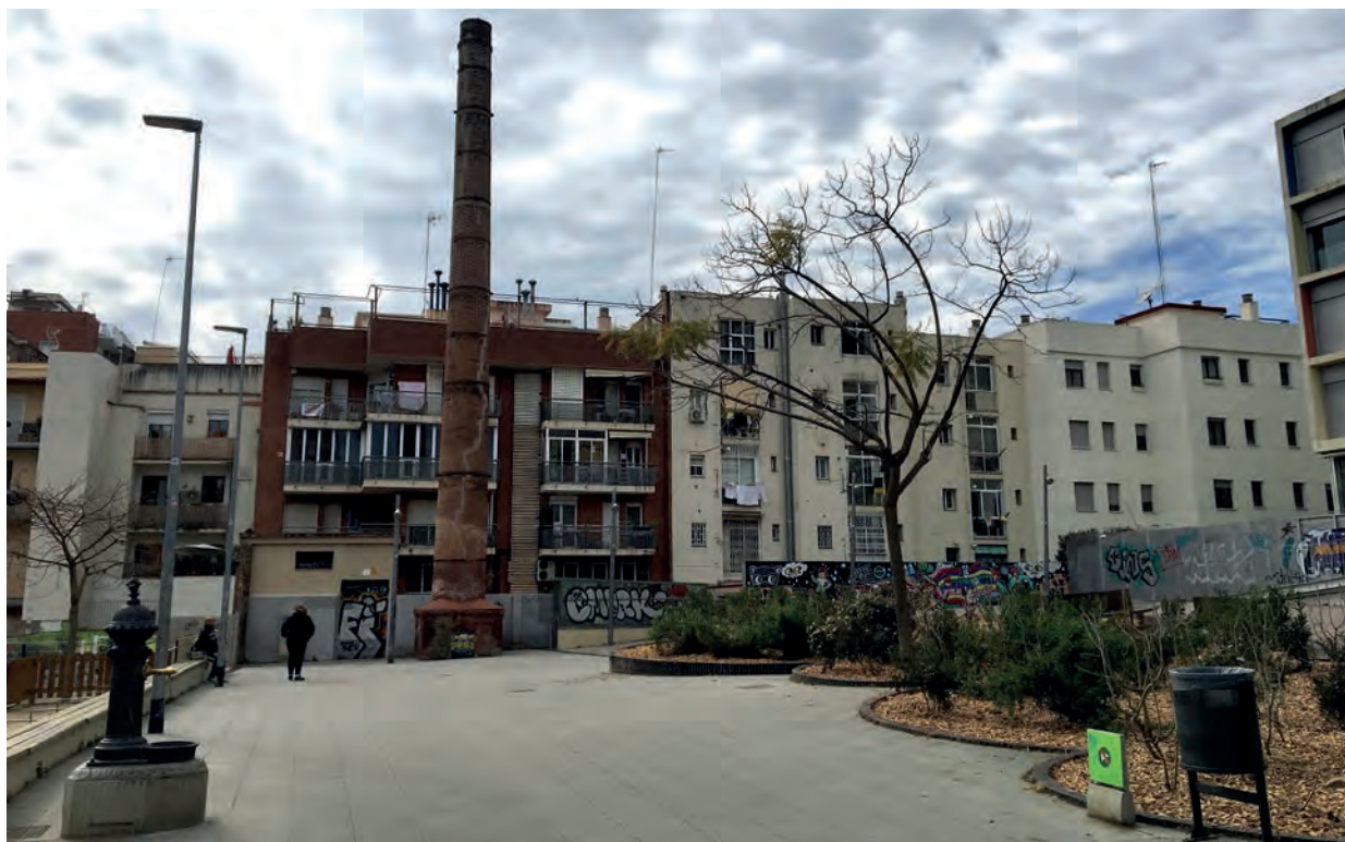
Ens cal avançar cap a una legislació que impulsi les actuacions de manteniment, conservació i millora dels edificis existents (Foto: Aina Gatnau)
