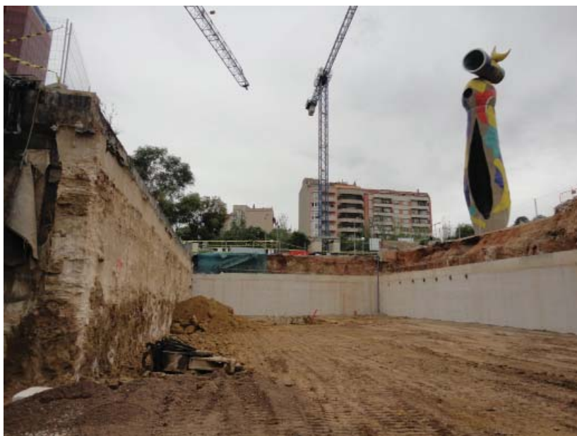
Execució de les pantalles de fonamentació
