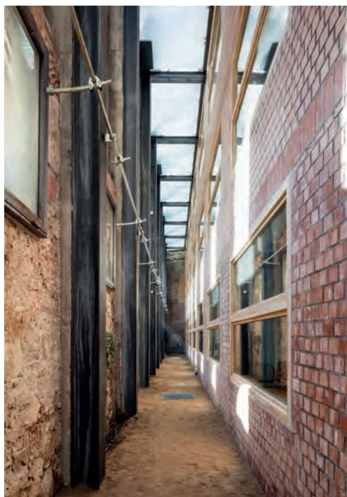
Convecció de les xemeneies tant per refrigerar com per escalfar l'edifici
