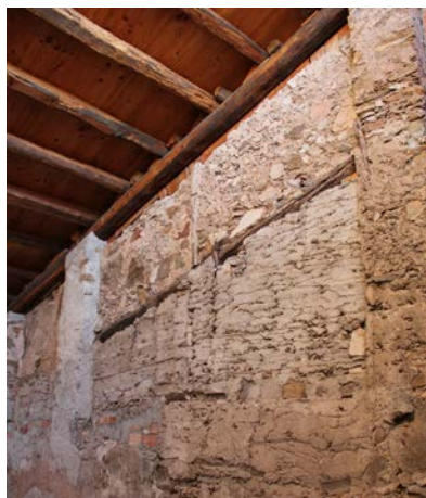
1-2-3: Talarn: sostre de revoltó de guix, pilar de maçoneria i guix i paret de tàpia amb maçoneria de guix
