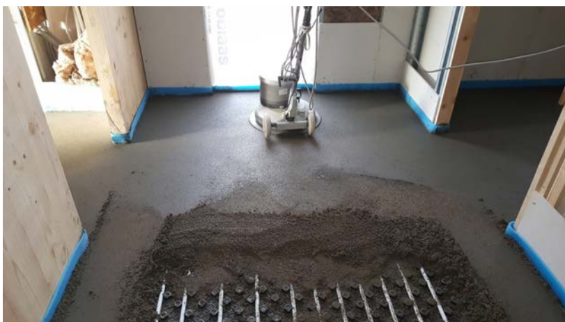
Col·locació del terra radiant en habitatge passiu de House Habitat
