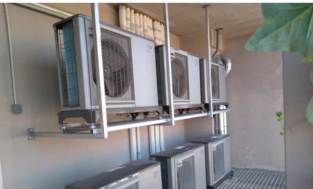
Unitats exteriors aerotèrmiques NIBE per a la producció de calefacció i refrigeració ACS
