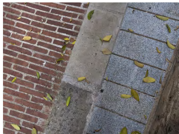
Vista aèria del paviment del carrer de la Costa i els diferents materials emprats en la seva secció
