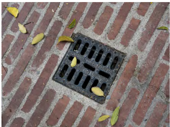
Embornal de mínimes dimensions per a permetre la curvatura
