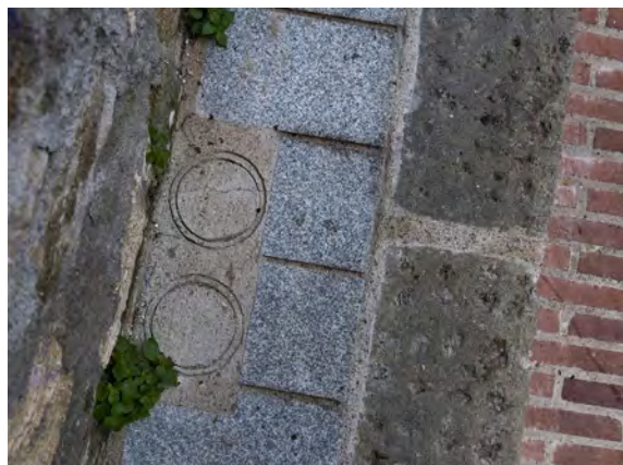
Detall dels pavimenys amb pas d'instal·lacions marcat
