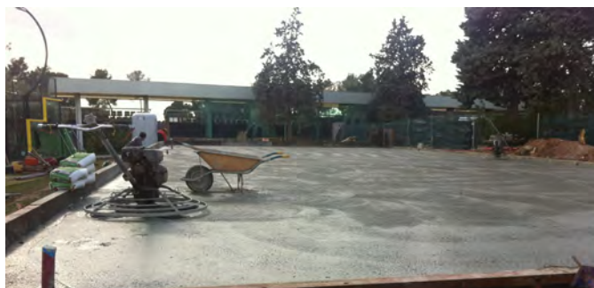
Procés d'execució de la llosa
