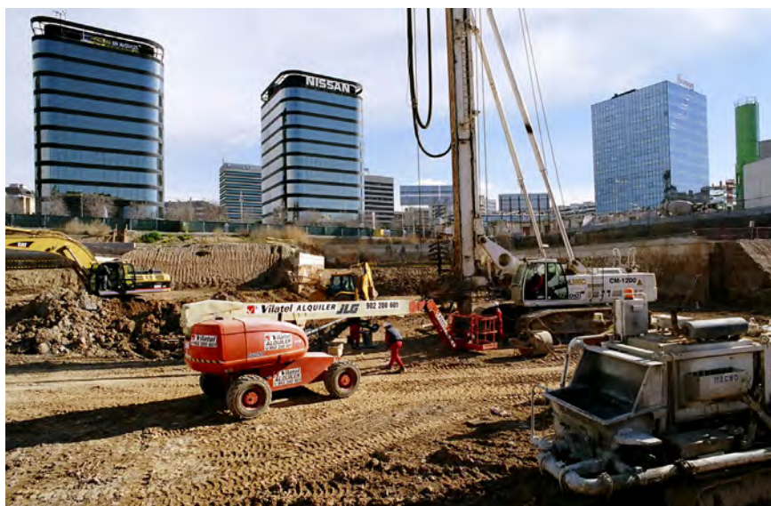
Fase de moviment de terres en una obra a L'Hospitalet de Llobregat. (Foto: Chopo)
