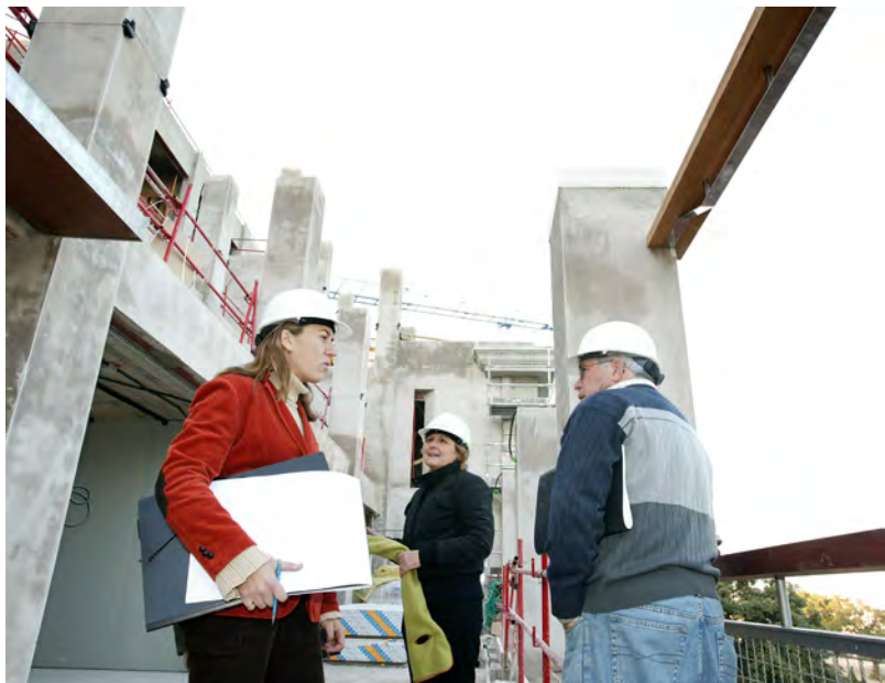
Susana Pavón i Maria Roger dirigint l'execució de les obres del nou Hotel Miramar de Montjuïc a Barcelona
