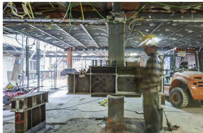
Estintolament de pilars
