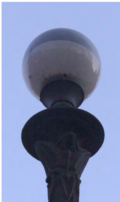
Globus de la tanca del Parc de la Ciutadella que es van pintar amb pintura opaca el casquet superior per no tirar llum cap amunt. Actualment les reposicions no es pinten, però tampoc s'encenen a la nit, i es perd l'agradable efecte visual de la llum dels globus.
