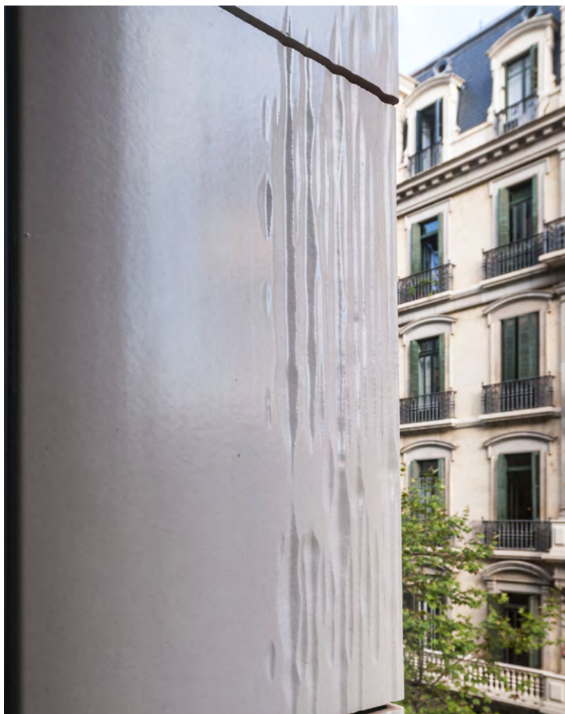
Textures de les peces ceràmiques de la façana de l'hotel (Foto: Chopo)
