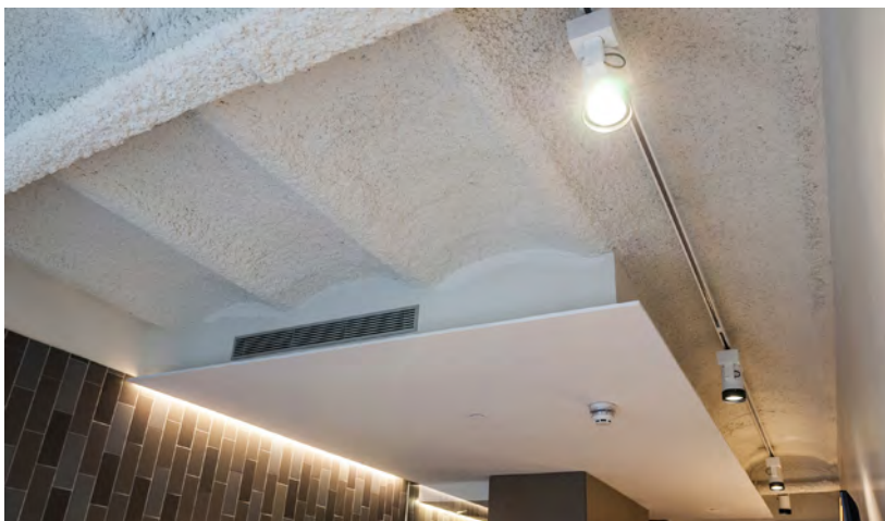
La proposta estableix un diàleg entre l'estructura existent, nua i exposada i l'ús hotel·ler, que es manifesta en materials de gran qualitat
