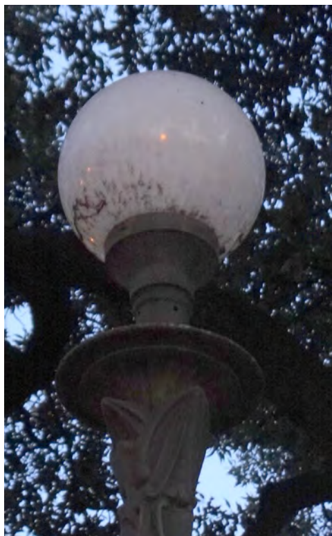
Globus de la tanca del Parc de la Ciutadella que es van pintar amb pintura opaca el casquet superior per no tirar llum cap amunt. Actualment les reposicions no es pinten, però tampoc s'encenen a la nit, i es perd l'agradable efecte visual de la llum dels globus.
