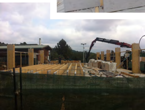
Muntatge de l'estructura de fusta
