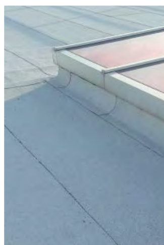
Rehabilitació coberta Centre Comercial Luz del Tajo (Toledo)
