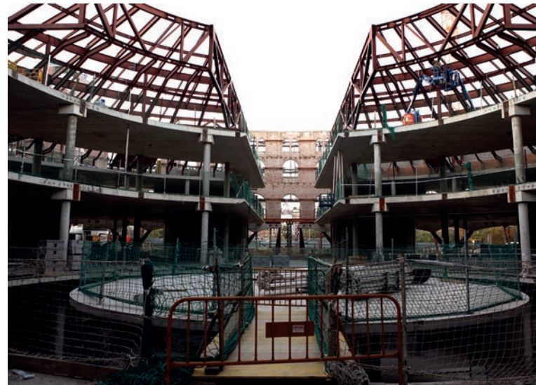
Obres de rehabilitació de Las Arenas a Barcelona. Foto: Albert Casanovas
