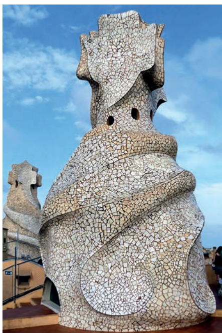
Trencadís d'una de les xemeneies de la Casa Milà, la Pedrera
