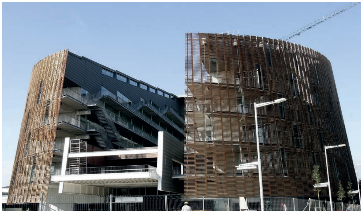
Obres de construcció de l'edifici del Parc de Recerca Biomèdica de Barcelona. Foto: Albert Casanovas
