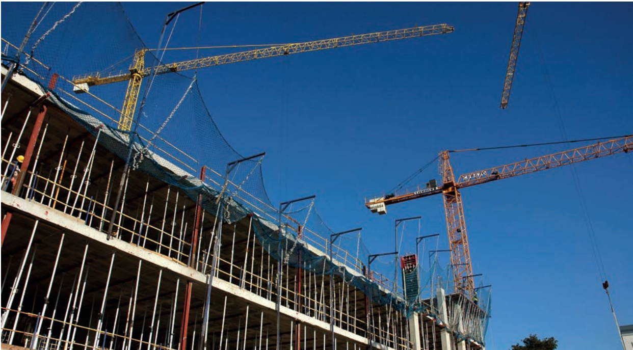
Fase d'obra d'una promoció residencial d'habitatges plurifamiliars
