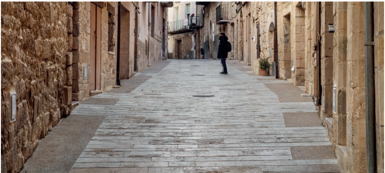
Pavimentació diferenciada en la banda de sòcol amb formigó rentat i empedrat a l'entrada de les cases
