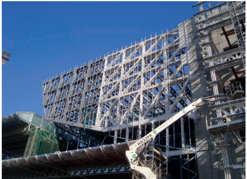
Estructura metàl·lica de l'edifici Disseny Hub a la Plaça de les Glòries de Barcelona
