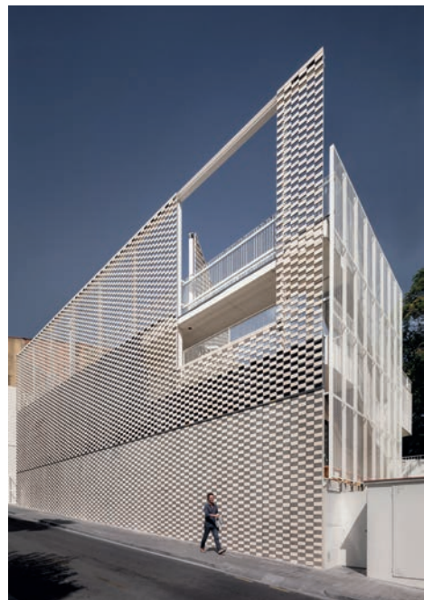
Escola Virolai Petit: Flexbric aplicat sense marc i encastrat en formigó.
