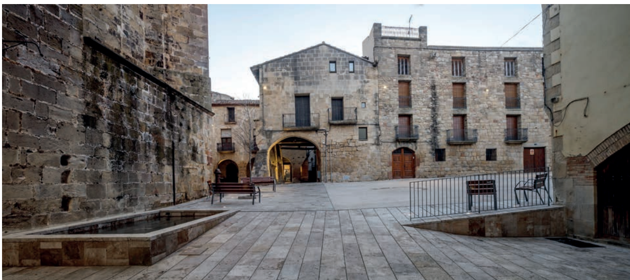
Detall amb el paviment que s'adapta al pendent existent
