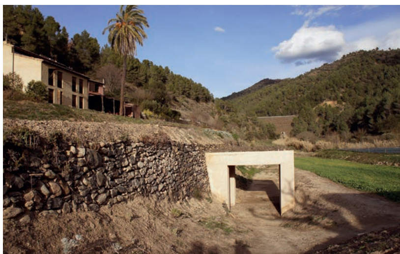
Vista general de l'entrada
