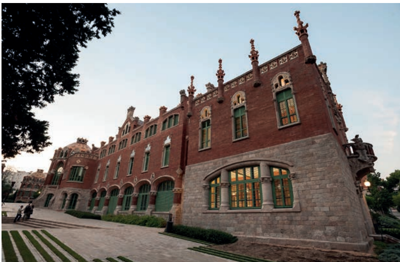
Façana lateral i detalls a la dreta d'interior, exterior i túnels
