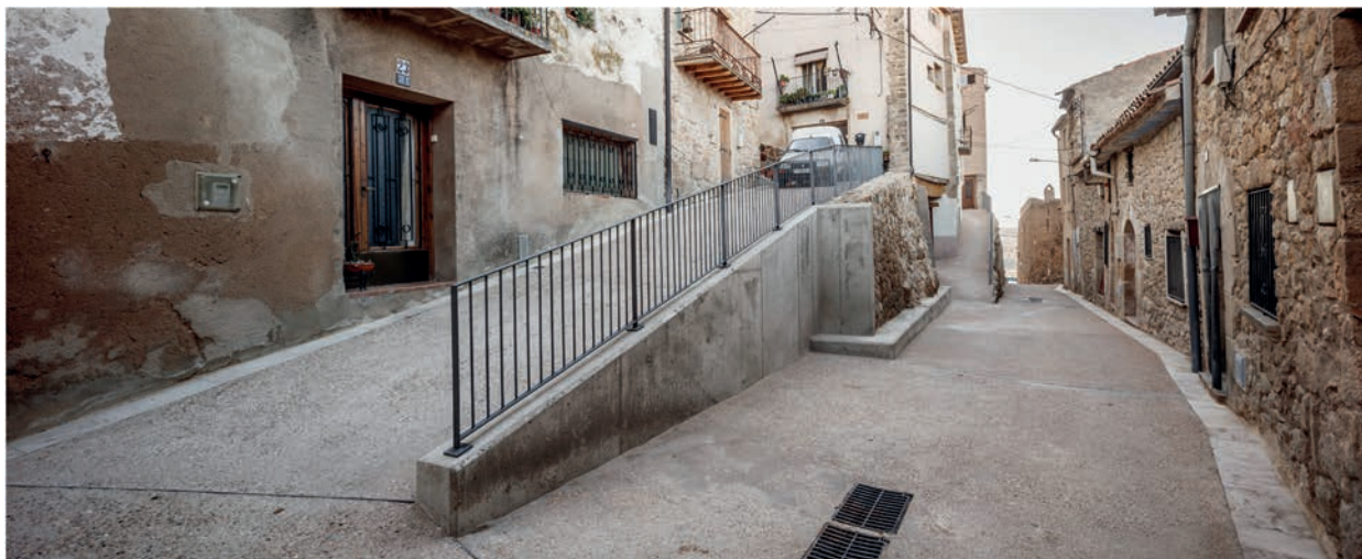
Pavimentació contínua, baranes i desguassos a la zona del Castell
