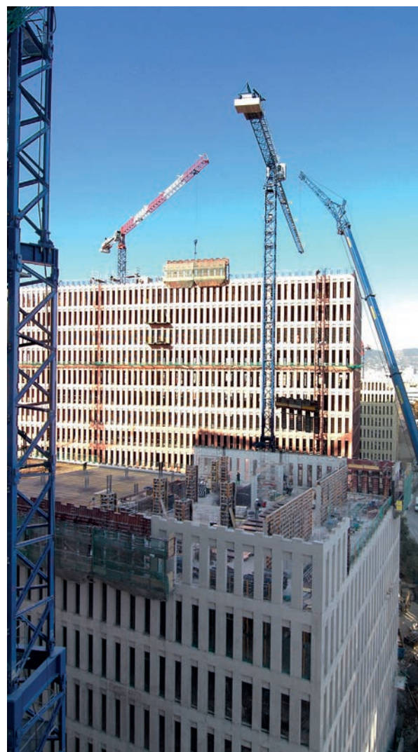
Construcció de la Ciutat de la Justícia a L'Hospitalet de Llobregat. Foto: Chopo
