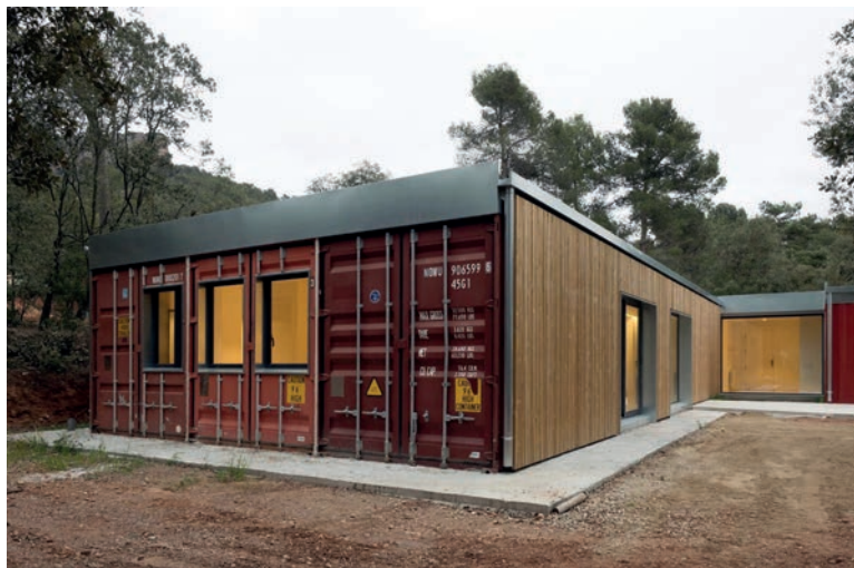
Combinació tant a l'exterior com a l'interior de paraments on els contenidors es deixen vistos o amagats. Casas VIP de Matadepera
