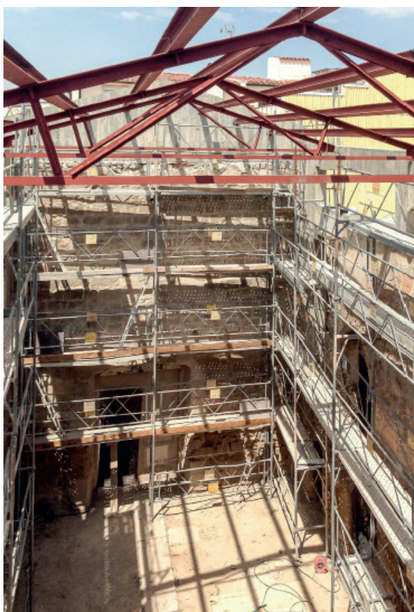
Estructura metàl·lica de coberta i bastides
