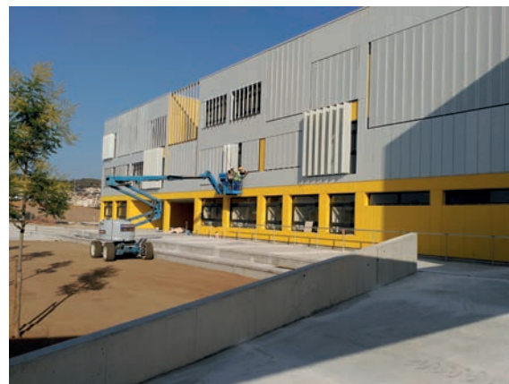
Instal·lació de les lames de façana
