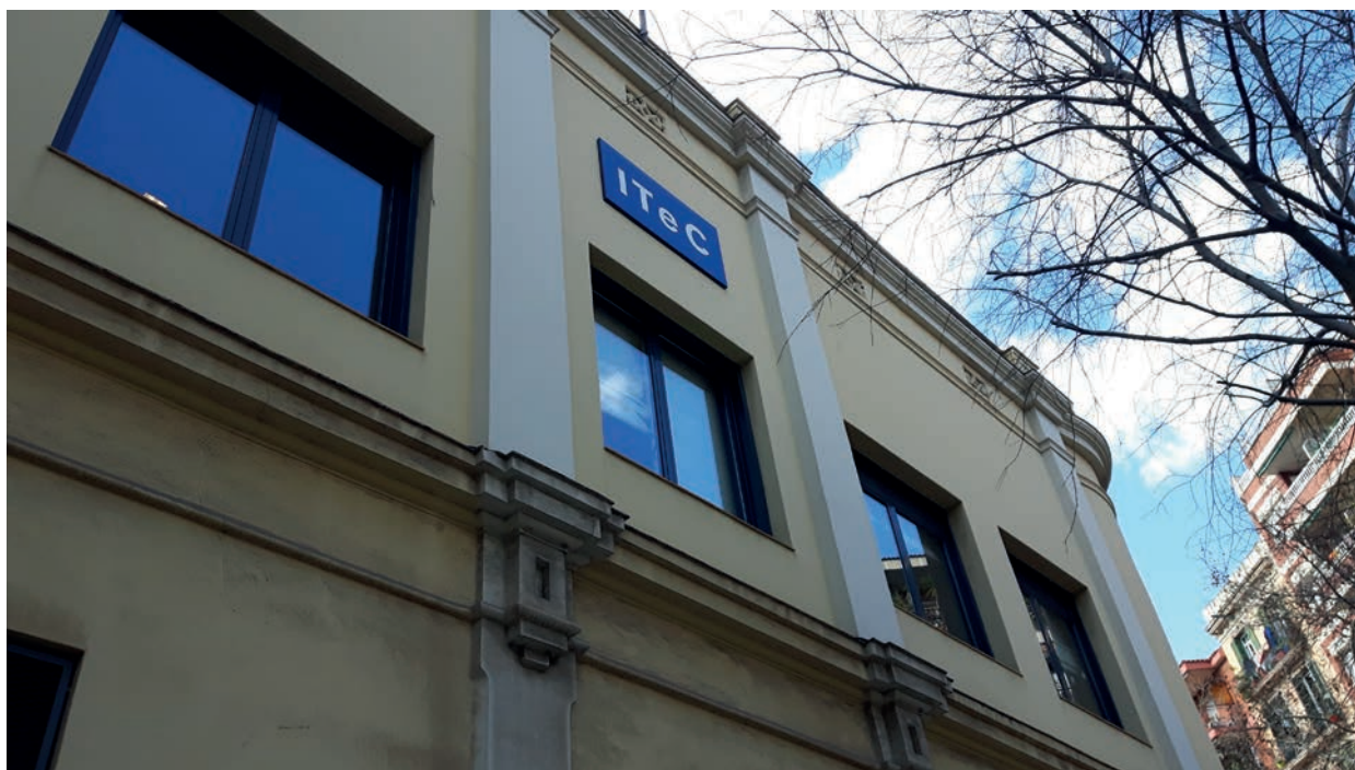
La seu de l'ITeC al barri de Sant Martí de Barcelona
