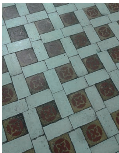
Paviment de gres Nolla a la Casa Segarra de Barcelona
