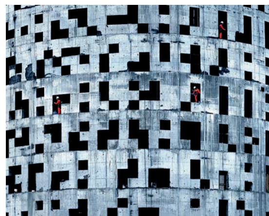
Estructura de la Torre Agbar a Barcelona
