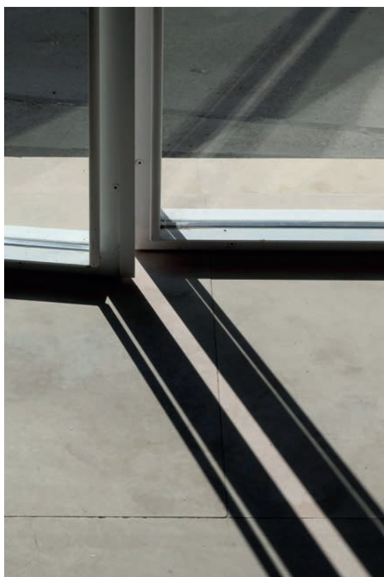
Foto fusteries o detall constructiu de les juntes obertes
