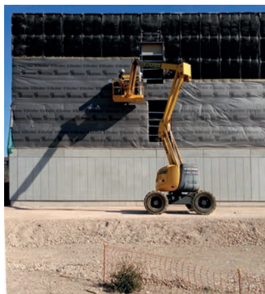
Aïllament i impermeabilització de façanes
