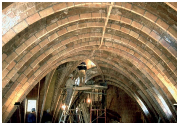
Restauració de les golfes de La Pedrera
