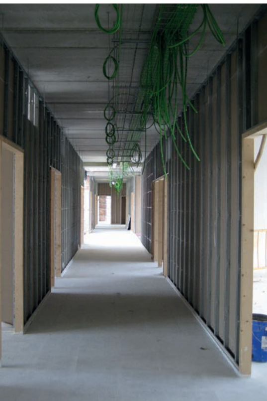
Muntatge de les divisòries del passadís
