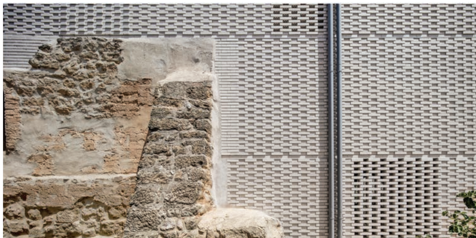
Imatge exterior on s'observen els materials originals i els nous.
