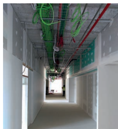
Instal·lacions del cablejat interior
