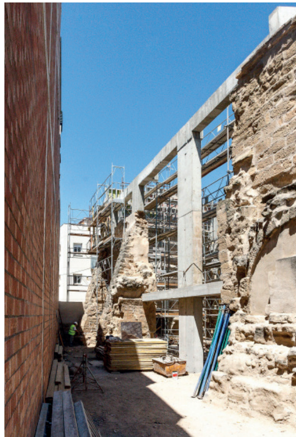
Reforç estructural i travat de murs
