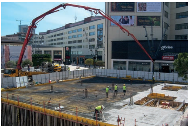
Obres al Centre Comercial Glòries a Barcelona
