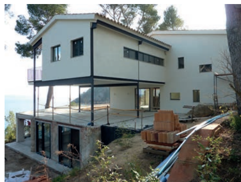
Imatges d'alguns detalls del procés d'obra amb reforç de fonaments, estructura metàl·lica i noves instal·lacions
