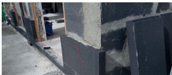
Primera capa d'aïllament amb placa PROPAM® AISTERM EPS GRAFITO
