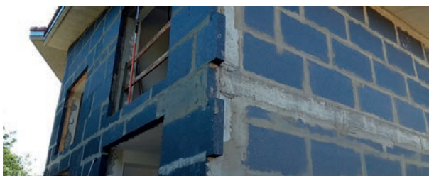
Primera capa d'aïllament amb placa PROPAM® AISTERM EPS GRAFITO
