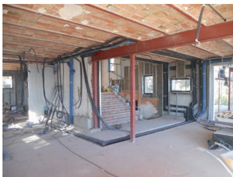
Imatges d'alguns detalls del procés d'obra amb reforç de fonaments, estructura metàl·lica i noves instal·lacions
