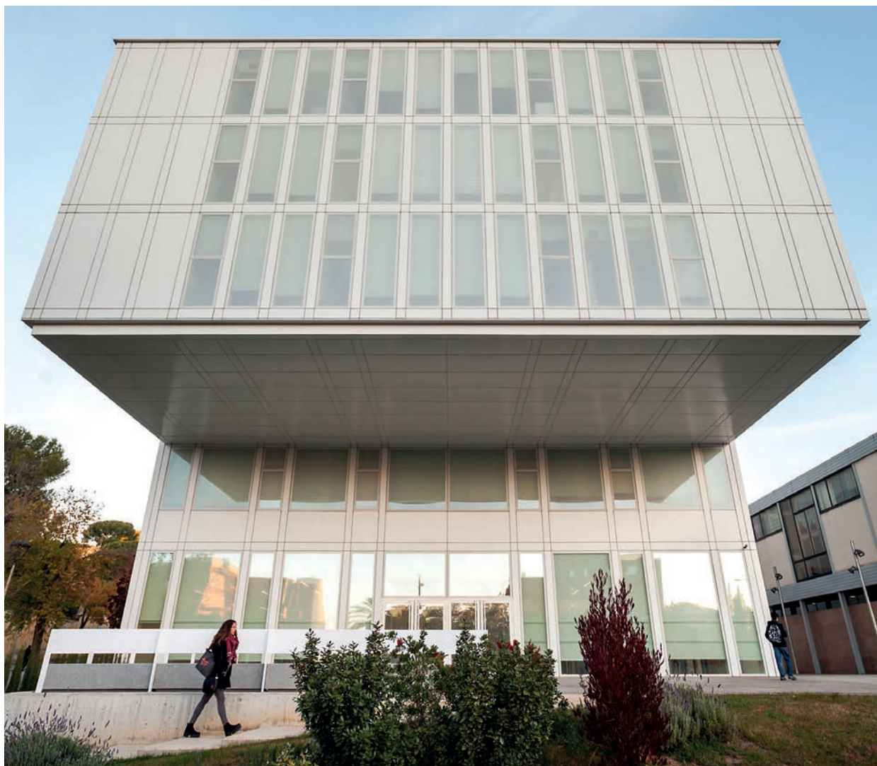
El voladís està revestit amb fals sostre de panell composite . Foto: Chopo
