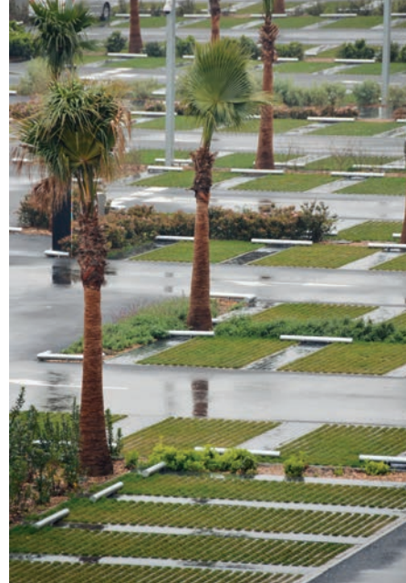
Aparcament exterior durant de dia 24 de març amb pluja torrencial.
