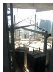
Detalls del procés d'execució de la torre Al Thuraya un altre gratacel de 42 plantes
