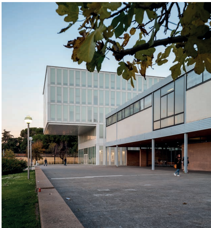
L'ampliació de la Facultat de Dret, al costat de l'edifici original de 1958, que va ser primer Premi FAD. Foto: Chopo
