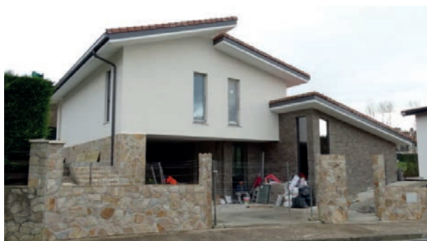
Habitatge unifamiliar acabat
