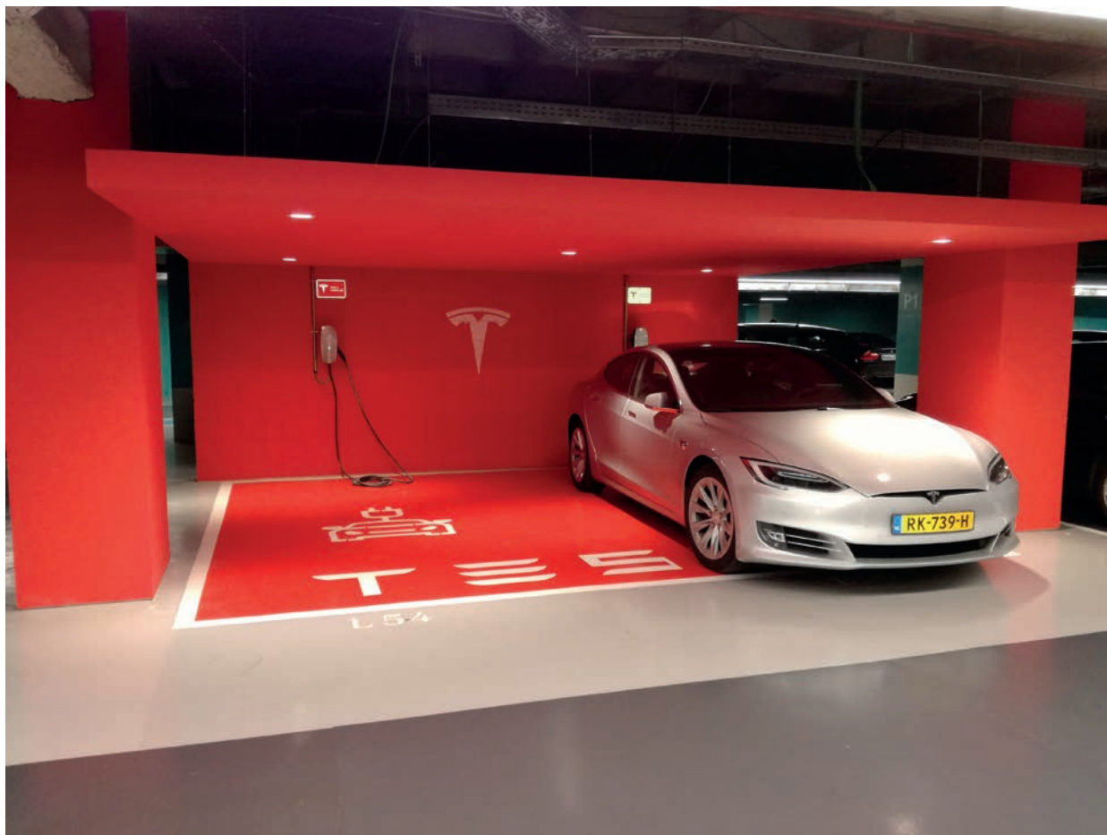
Punt de recàrrega vinculat, robust i exclusiu per al vehicle elèctric amb manega específica
