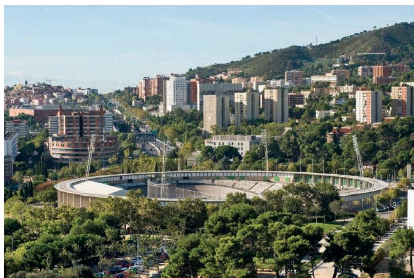
Vista del Velòdrom d'Horta, construït al vessant de la muntanya (Foto Chopo)
