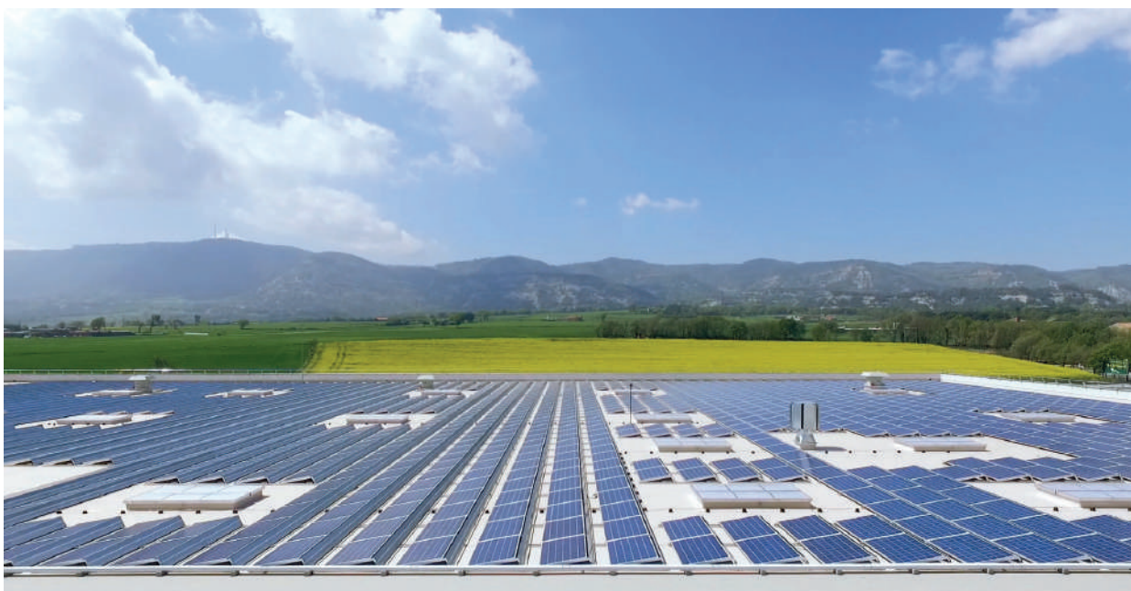
Instal·lació d'autoconsum fotovoltaic de 650 kWp a la coberta del nou magatzem del Grup Bon Preu
