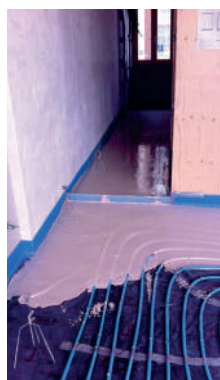
Formigonat del terra radiant amb anhidrita
