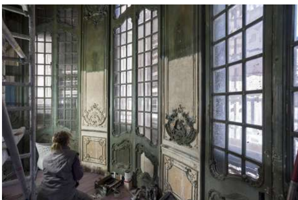
Diversos operaris decapant i restaurant les portes i vitralls de la Sala Oval de la Casa Burés
