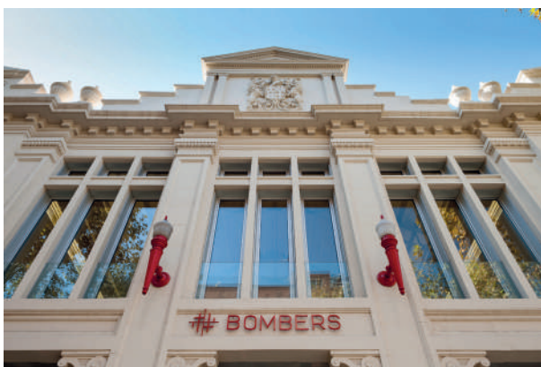
Detall de façana amb els nous tancaments de finestres
