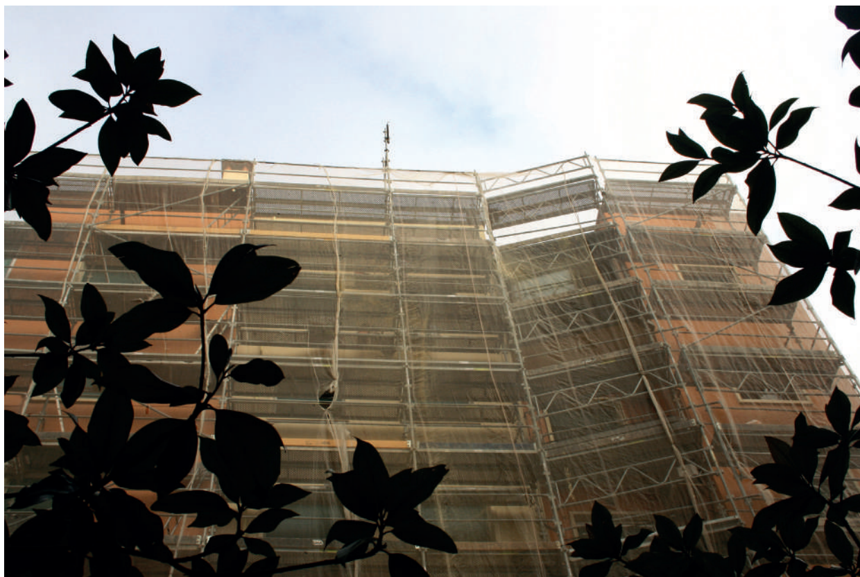
Edifici d'habitatges sotmès a un procés de rehabilitació (Foto: Helena Castro)
