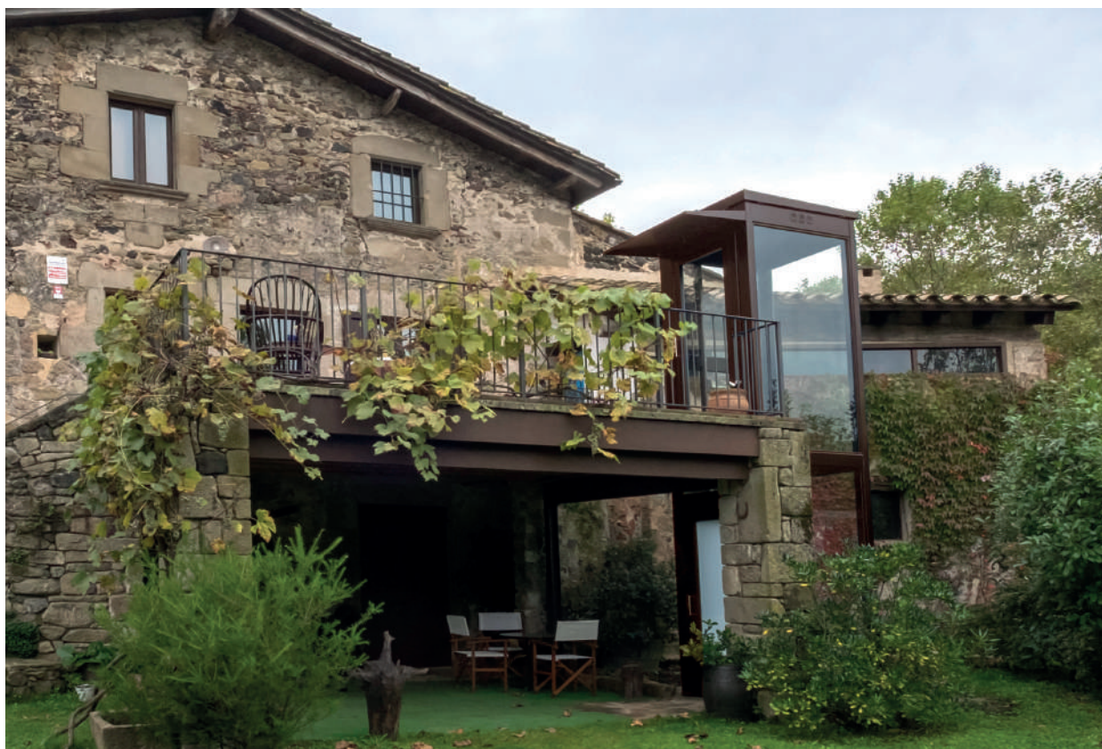
Ascensor ubicat en estructura exterior, perfectament integrat
