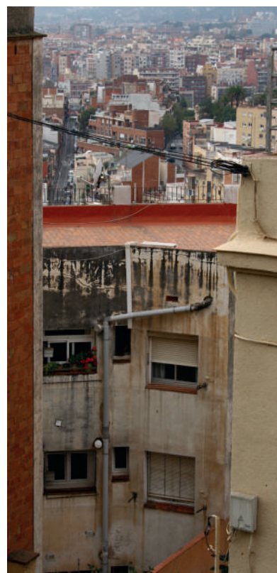
Encara hi ha molta feina a fer per generalitzar la pràctica de la rehabilitació energètica (Foto: Helena Castro)
