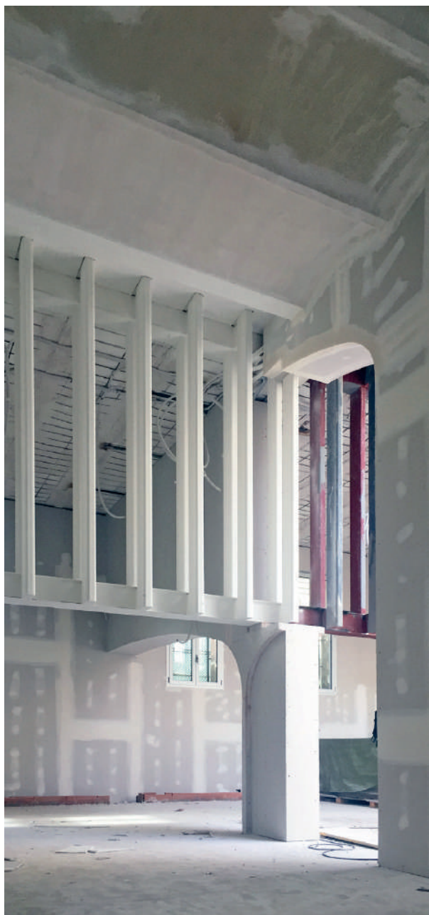
Fase d'execució de les estructures portants de la nau central
