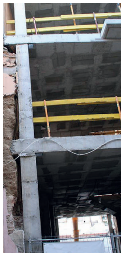
Figura 4. Estructura de formigó encaixada dintre d'un cós
