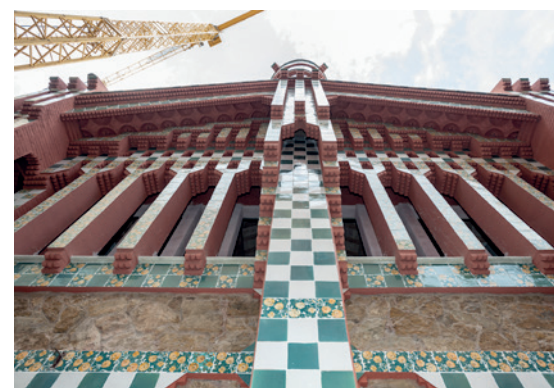
Detall de la façana
