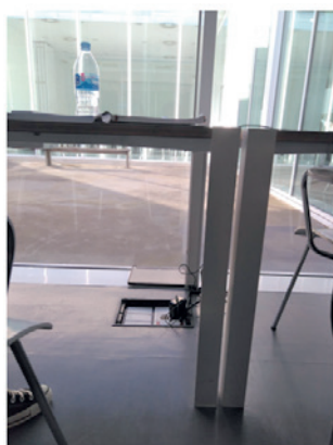
Caixes encastades paviment
