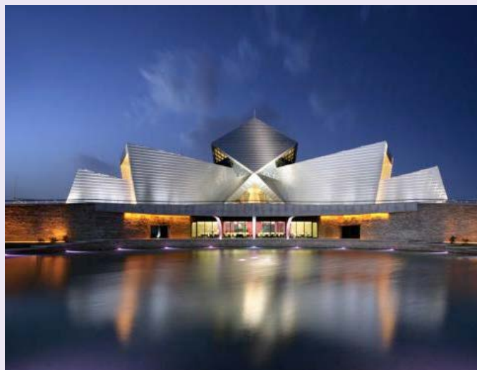
Bodegas Irius a Barbastro (Osca). Arquitectes J. Marino Pascual y Asociados (2008). Celler en el qual l'estructura superior ha estat realitzada amb perfils laminats d'acer soldats, i la pell de les cobertes amb acer inoxidable 316 L.
