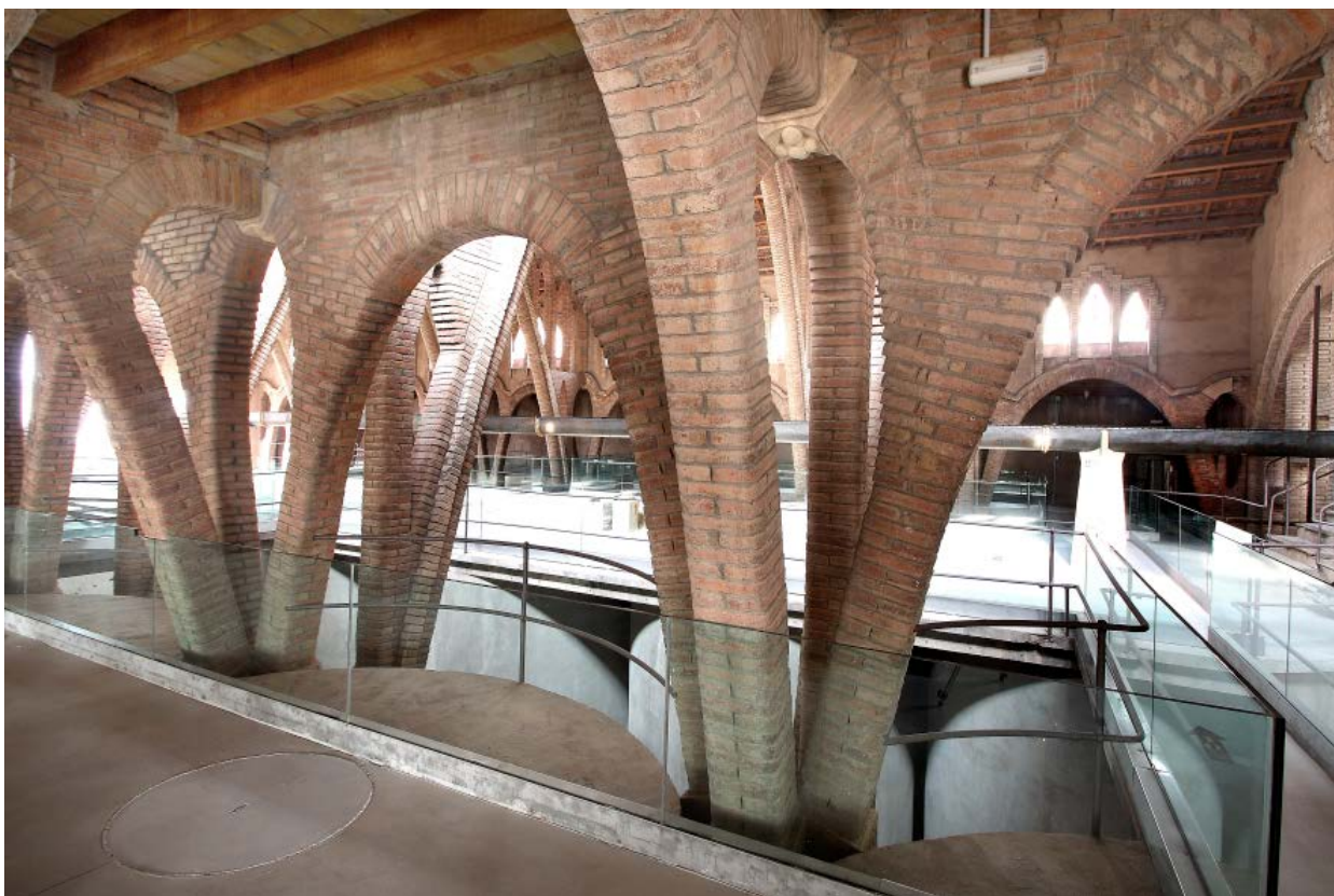
La restauració del celler cooperatiu de Pinell de Brai (Terra Alta) va ser candidata als Premis Catalunya Construcció 2014
