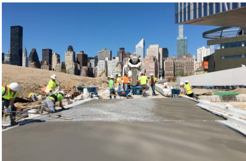
Adequació de la urbanització exterior en l'obra nova aïorquesa
