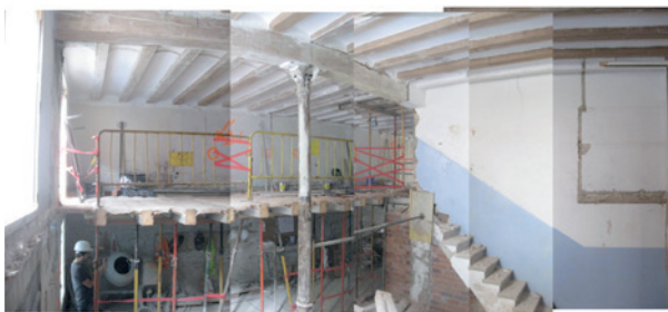
Obra a la zona de l'altell posterior de la casa
