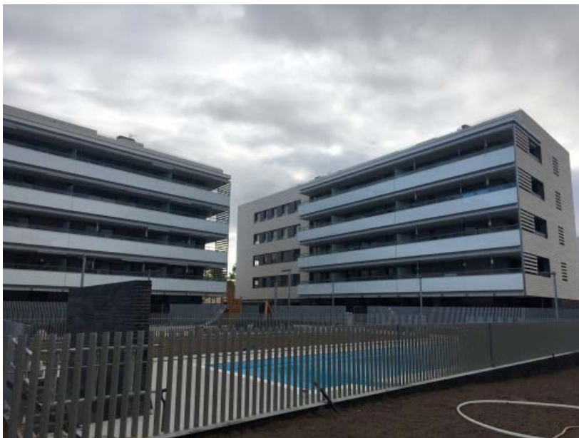
Vista general de l'obra de Traditerm EPS a la població de Sant Cugat del Vallès
