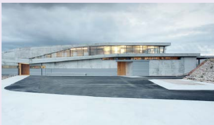
Nueva Bodega Qumrán a Ribera del Duero, de Konkrit Blu Arquitectura: el formigó ama el vi (2007). Celler on el formigó és l'element dominant amb acabats vistos tant a l'exterior com a l'interior, combinat amb la fusta de les barriques i l'acer inoxidable dels dipòsits.
