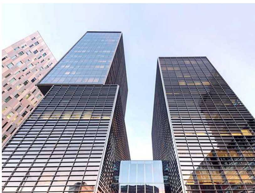
L'execució de l'edifici d'oficines per a la firma d'advocats Cuatrecasas va guanyar el premi 2017 en la categoria de direcció
