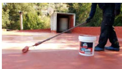
Sistema vist amb trànsit i entollament d'aigua. Obra realitzada amb AguaStop Hybrid P3
