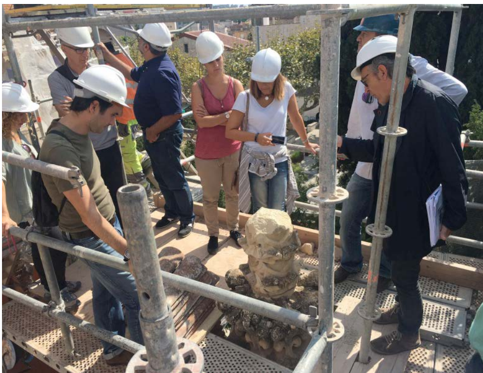
En Pep Brazo explicant els detalls de la 1a fase de les obres durant una visita de la delegació del Maresme del CAATEEB
