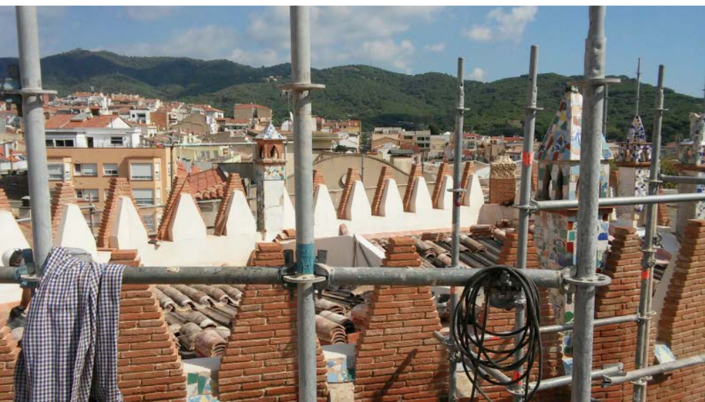
Vista general de l'estructura de formigó de calç per estabilitzar els merlets
