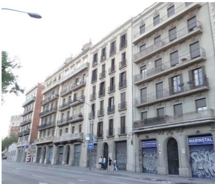
Edificis de gran alçada afectats
