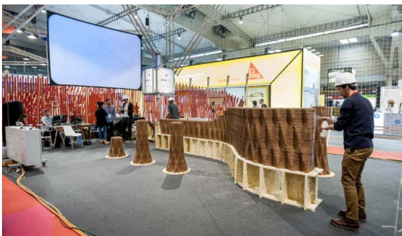
La construcció, in situ, d'un estand, un exemple de les moltes possibilitats de la impressió 3D en construcció
