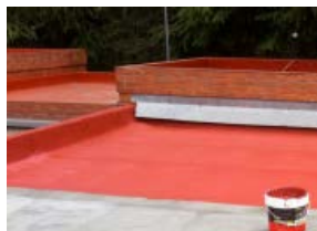
Sistema vist sense trànsit. Obra realitzada amb AguaStop Caucho Fibras
