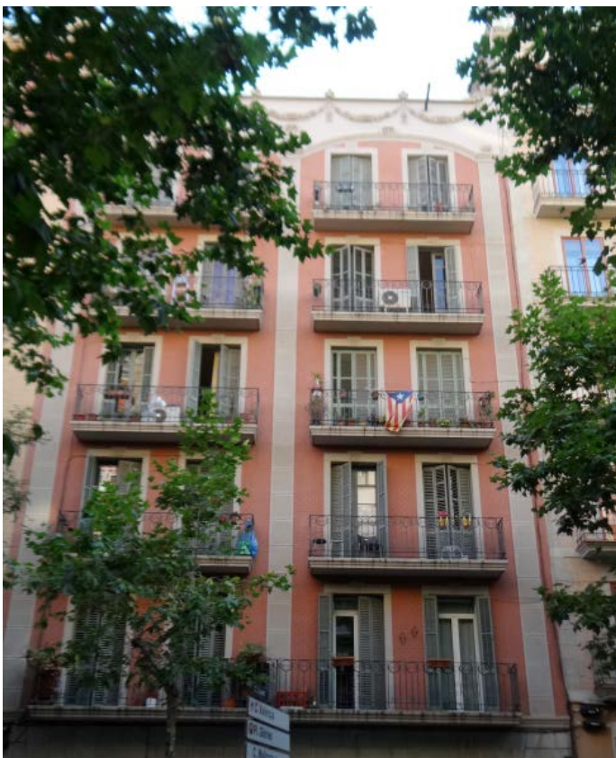
Façana a Sardanya d'un dels edificis afectats que donen als jardins
