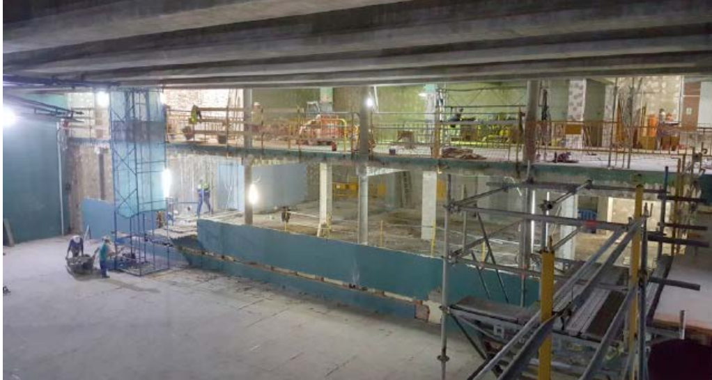
Obres al Pavelló Poliesportiu Municipal a la Rambla del Carmel
