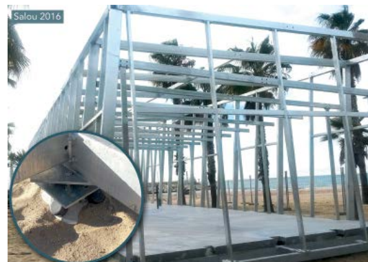
Sistema de fonamentació Piloedre
