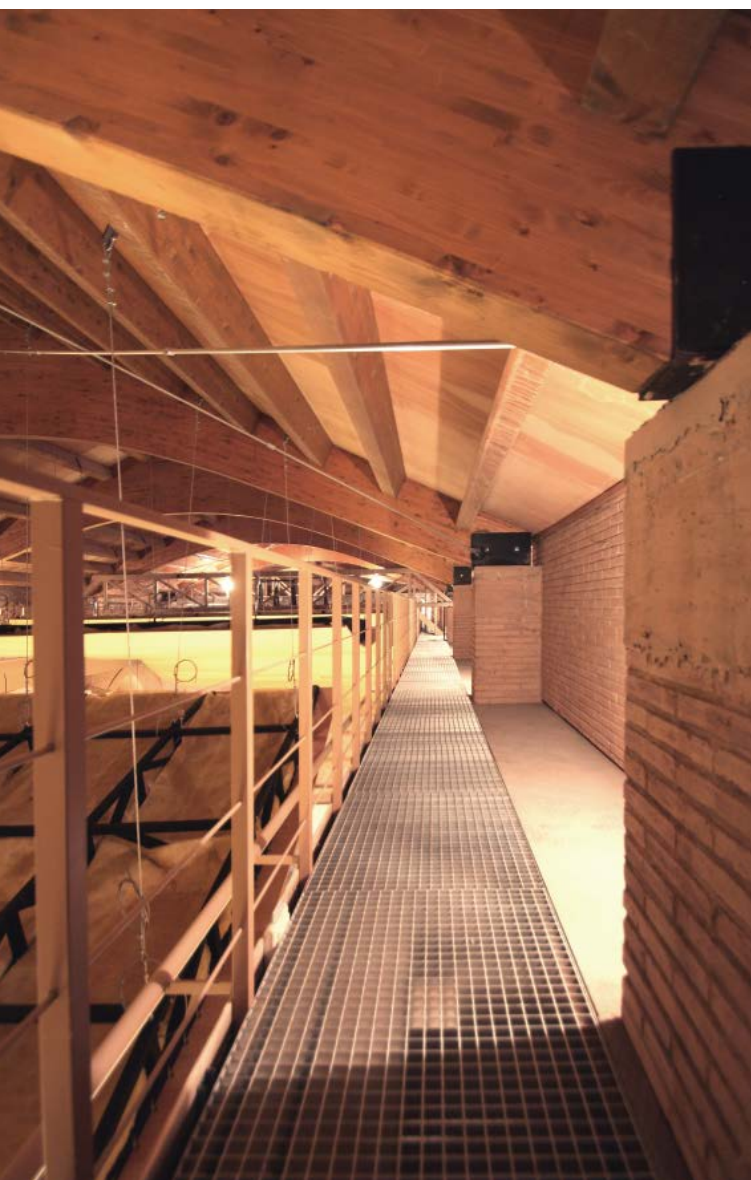
Recuperació de la cornisa que circumda la nau
