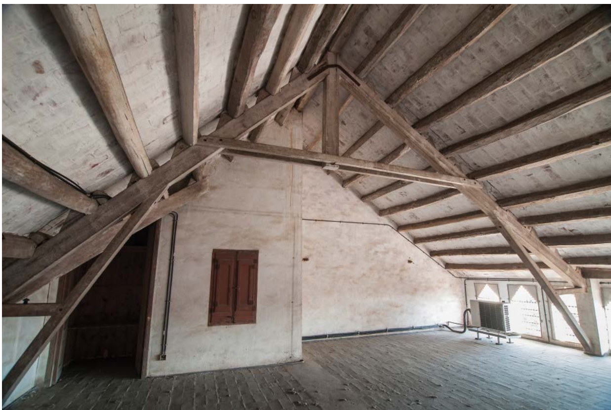
Detall de les golfes on es pot observar l'estructura de coberta
