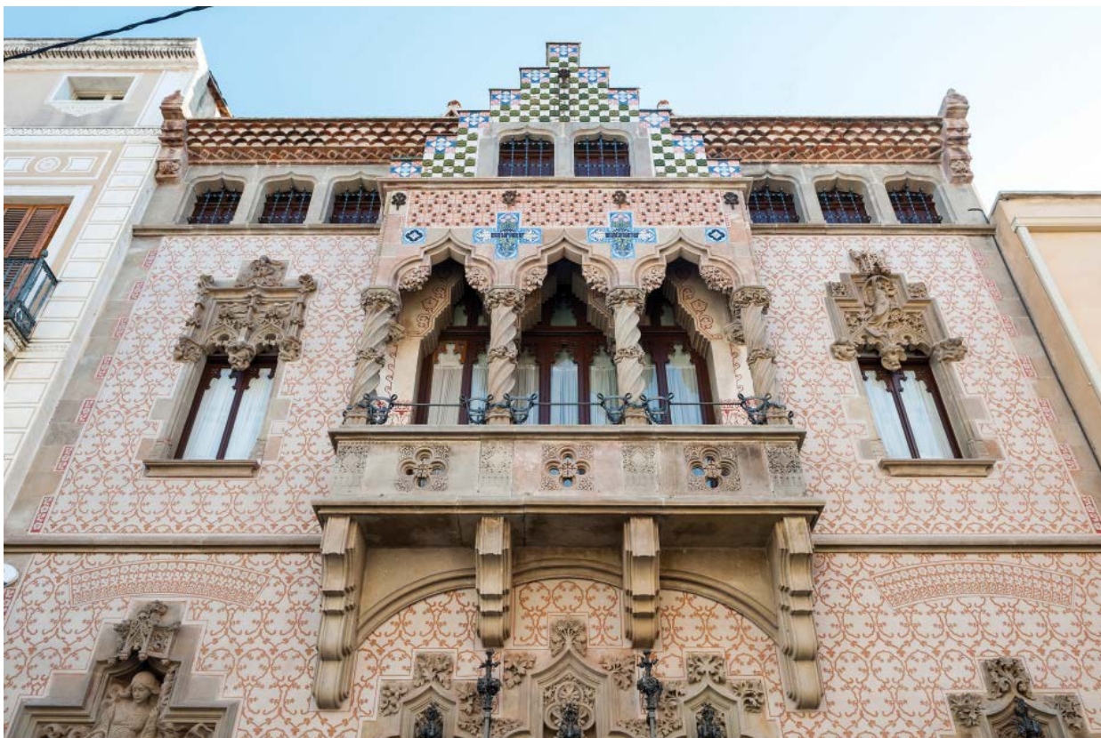
Façana de la Casa Coll i Regàs del carrer Argentona de Mataró
