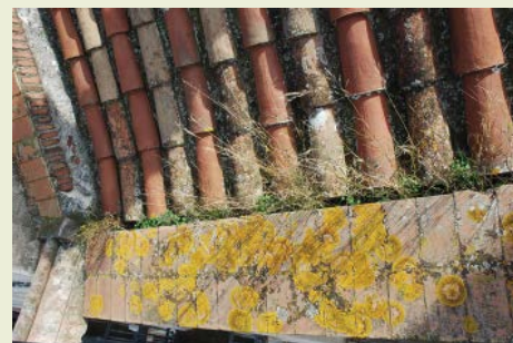
Vista canal de coberta banda est
