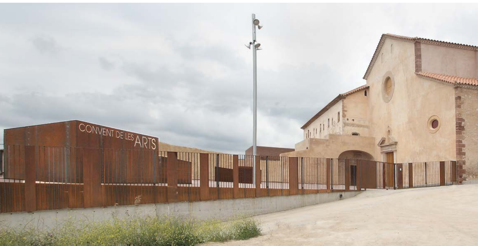
Vista general del nou Convent de les Arts
