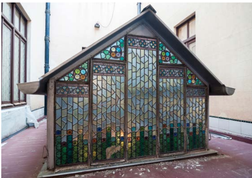
Detall de la claraboia vista des del terrat
