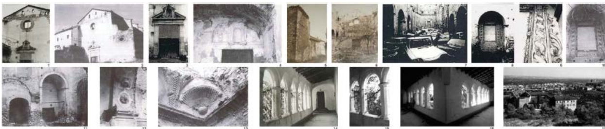
Imatges de l'estat previ a la intervenció
