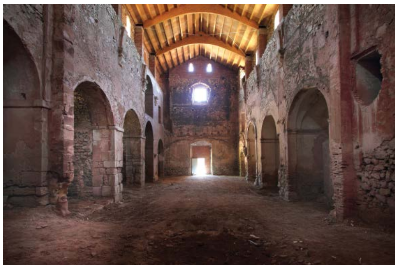
Nau de l'església amb coberta rehabilitada.
