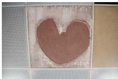
La perforació de les plaques existents als falsos sostres em va permetre crear un agafador mecànic en col·locar la malla de jute i argila
