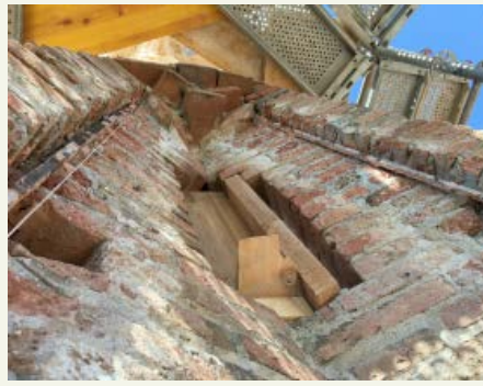
Restauració estructural de l'agulla del campanar. Sistema d'atirantament original, sistema passiu i sistema d'atirantament de reforç, sistema actiu.
