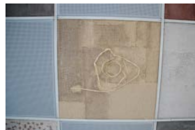
La perforació de les plaques existents als falsos sostres em va permetre crear un agafador mecànic en col·locar la malla de jute i argila
