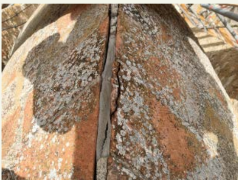
Restauració de les voltes principals i restitució dels junts amb reintegració volumètrica de la secció de les voltes.
