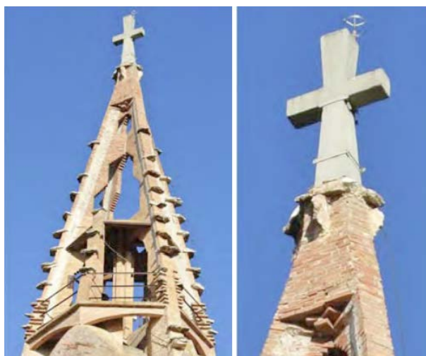
Campanar i detall del vèrtex de l'agulla i de la creu abans de la seva restauració.
