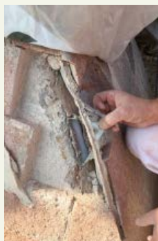
Restauració de les voltes principals i restitució dels junts amb reintegració volumètrica de la secció de les voltes.
