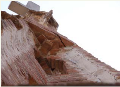
Restauració estructural de l'agulla del campanar. Sistema d'atirantament original, sistema passiu i sistema d'atirantament de reforç, sistema actiu.
