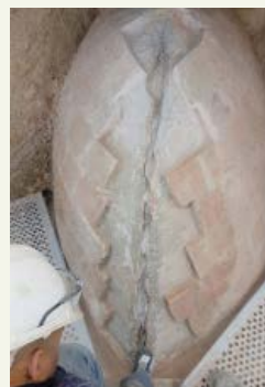
Restauració de les voltes principals i restitució dels junts amb reintegració volumètrica de la secció de les voltes.
