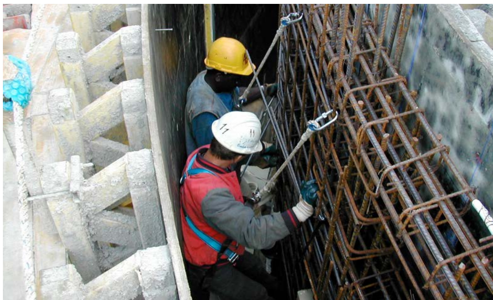
Dos treballadors preparen l'armadura d'un mur de formigó amb un equipament de seguretat adequat
