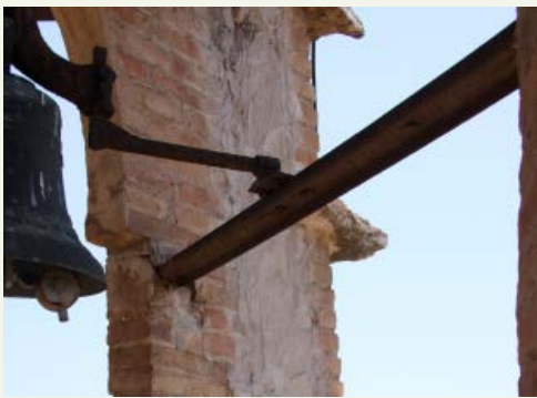
Restauració estructural de les costelles - atirantament original i reforç.
