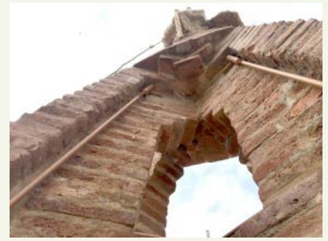
Restauració estructural de l'agulla del campanar. Sistema d'atirantament original, sistema passiu i sistema d'atirantament de reforç, sistema actiu.
