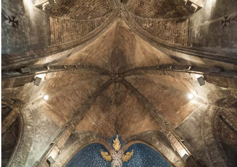
Figura 5: Imatge de l'interior de la volta principal
