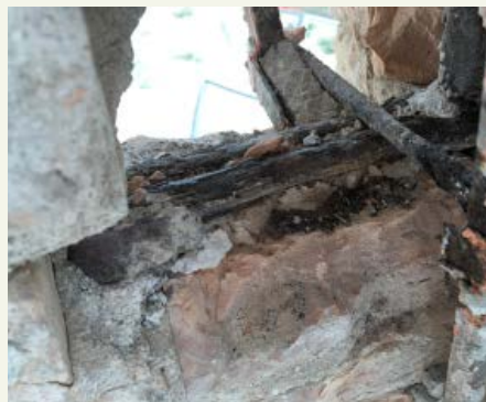
Restauració estructural d'atiraments, substitució d'elements de ferro encastats per elements d'acer inoxidable.
