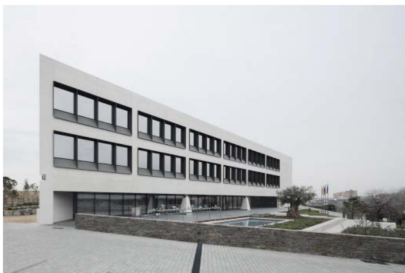
Edifici d'oficines per a la seu d'Endress & Hauser a Sant Cugat del Vallès guardonat en la categoria de direcció d'execució d'obra en l'anterior edició
