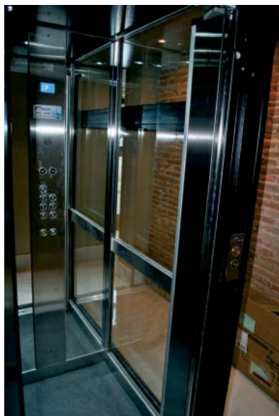
Instal·lació d'ascensor en edifici existent
