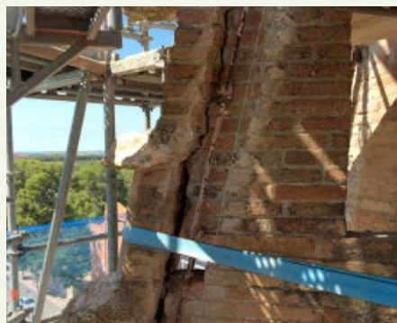
Restauració estructural de les costelles - atirantament original i reforç.
