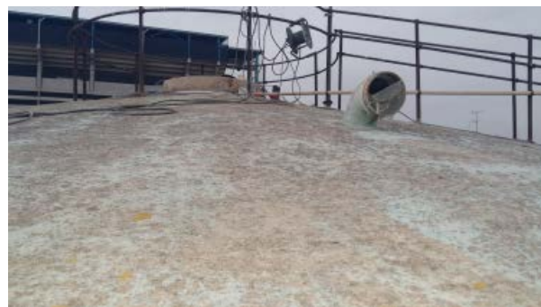
Reparació i reforç de l'estructura de formigó del dipòsit
