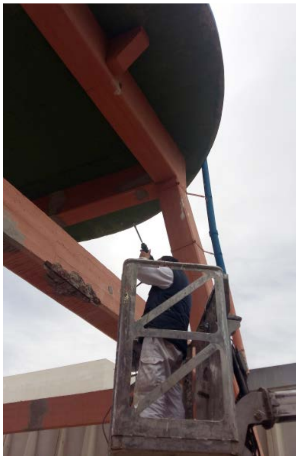
Reparació i reforç de l'estructura de formigó del dipòsit
