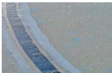
Reforç de la cúpula mitjançant fibres de carboni.
