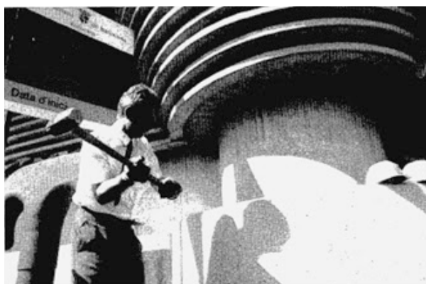
Acabats els Jocs Olímpics, l'alcalde Pasqual Maragall, amb una maça a les mans, escenifica el pròxim enderrocament del pavelló de l'INI, que encara trigaria un any a fer-se efectiu. (Foto: Rafel Bosch)
