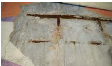
Danys localitzats, escrostonats i fissures associades a l'oxidació
