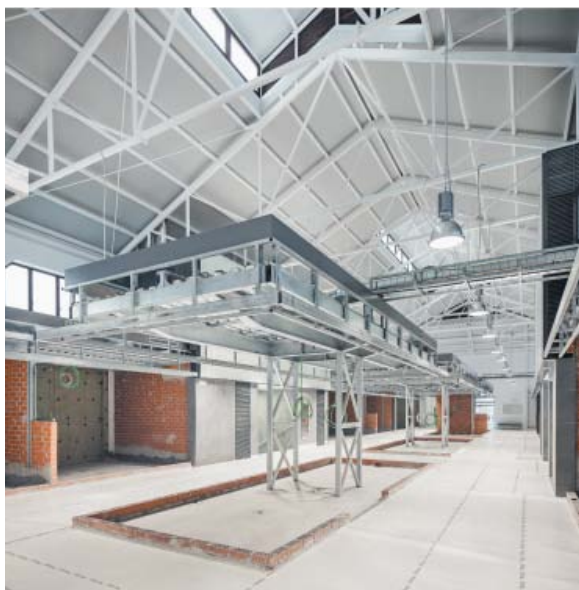
VISTA INTERIOR PROCÉS D'OBRES. MUNTATGE PARADES
