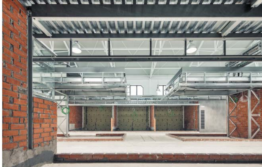
LES IMATGES MOSTREN DIFERENTS MOMENTS DEL PROCÉS D'EXECUCIÓ DE LES OBRES AIXÍ COM ELS MATERIALS QUE HAN ESTAT UTILITZATS
