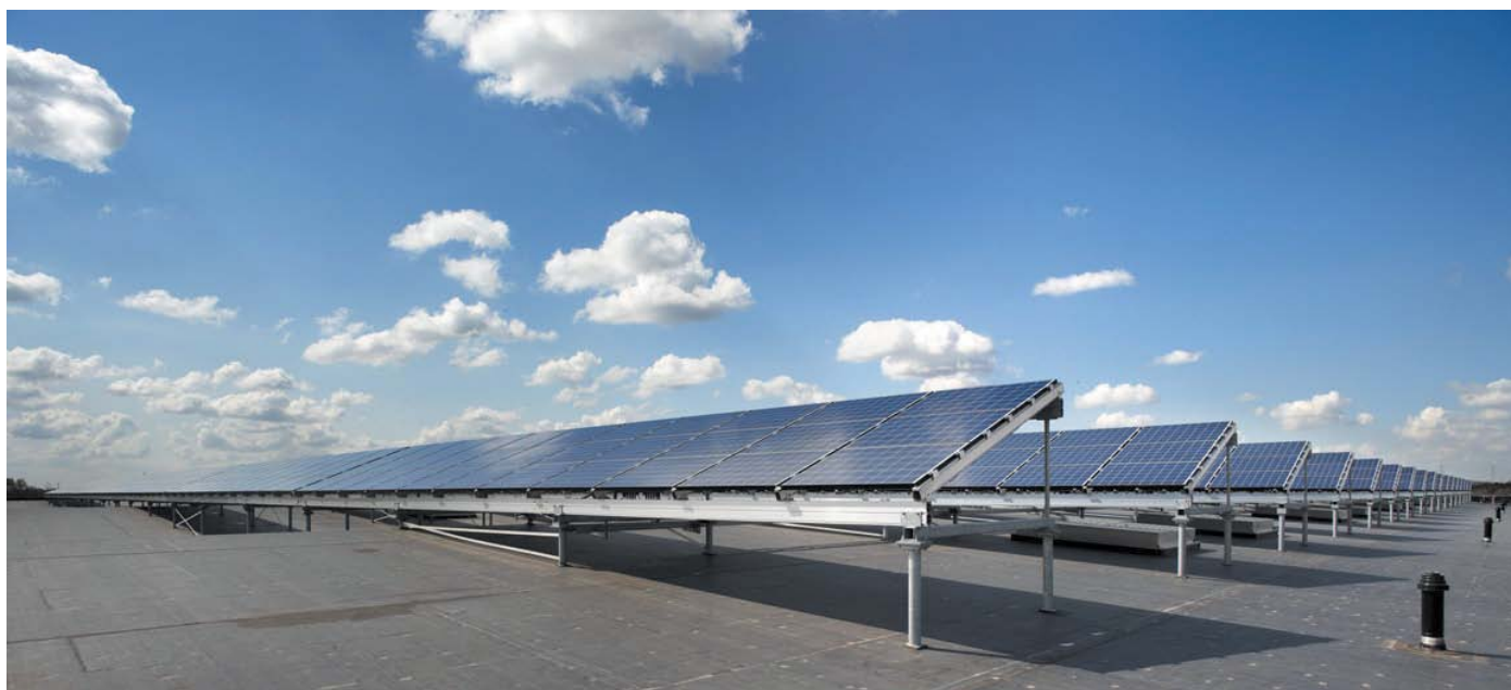
INSTAL·LACIÓ DE CAPTADORS SOLARS AL SOSTRE D'UN EDIFICI A CATALUNYA ©REYNAERS
