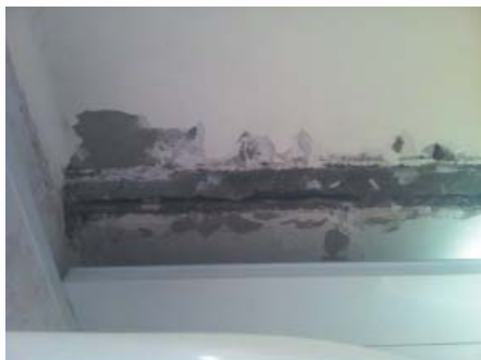
Fotografia 14: extracció fals sostre registrable
