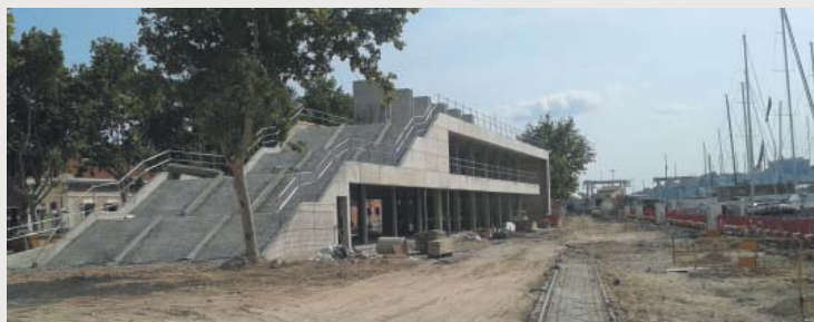
VISTA GENERAL DURANT LES OBRES.
