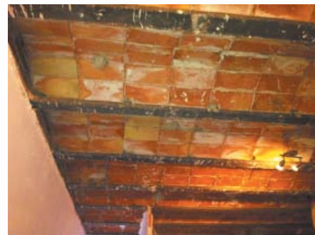
Fotografia 15: extracció tot el fals sostre.
