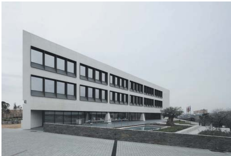
SEU CORPORATIVA D'ENDRESS+HAUSER A SANT CUGAT DEL VALLÈS PREMI A LA DIRECCIÓ D'EXECUCIÓ DE L'OBRA
