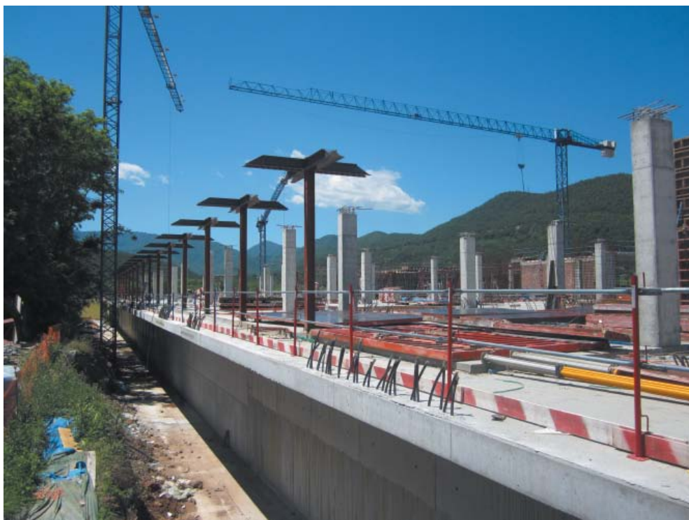
OBRES A L'HOSPITAL D'OLOT DE L'ANY 2015
