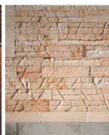
DETALL DE FAÇANA, CAN JORDÍ I N'ÀFRICA, MALLORCA
