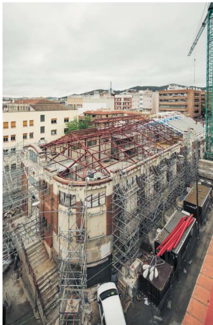
LES OBRES D'INTERVENCIÓ HAN SABUT CONSERVAR BONA PART DE L'ESTRUCTURA AIXÍ COM L'ESSÈNCIA DE L'EDIFICI ORIGINAL
