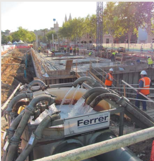
VISTA DE LES BOMBES D'EXTRACCIÓ I DETALLS DELS TREBALLS D'IMPERMEABILITZACIÓ
