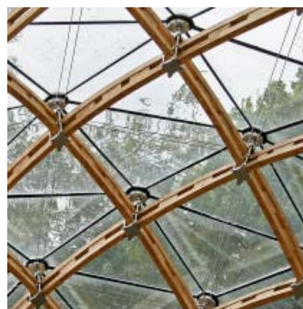
FIGURA 8: NEXE DE CONNEXIÓ EN EL PROJECTE DE CHIDDINGSTONE CASTLE DESENVOLUPAT PER L'EMPRESA HARAN GLASS DE GLASGOW ©: WWW.CARPENTEROAKANDWOODLAND.COM
