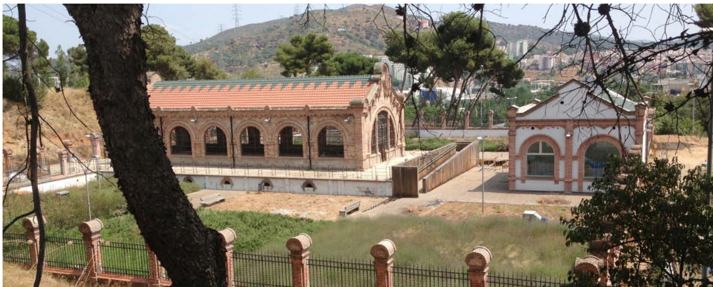
ESTAT PREVI A LA INTERVENCIÓ
