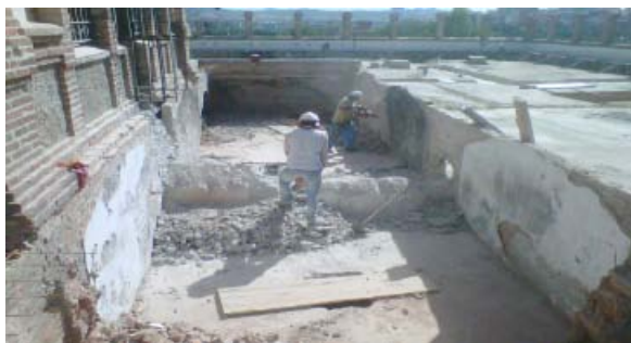
EDIFICI EN OBRES
