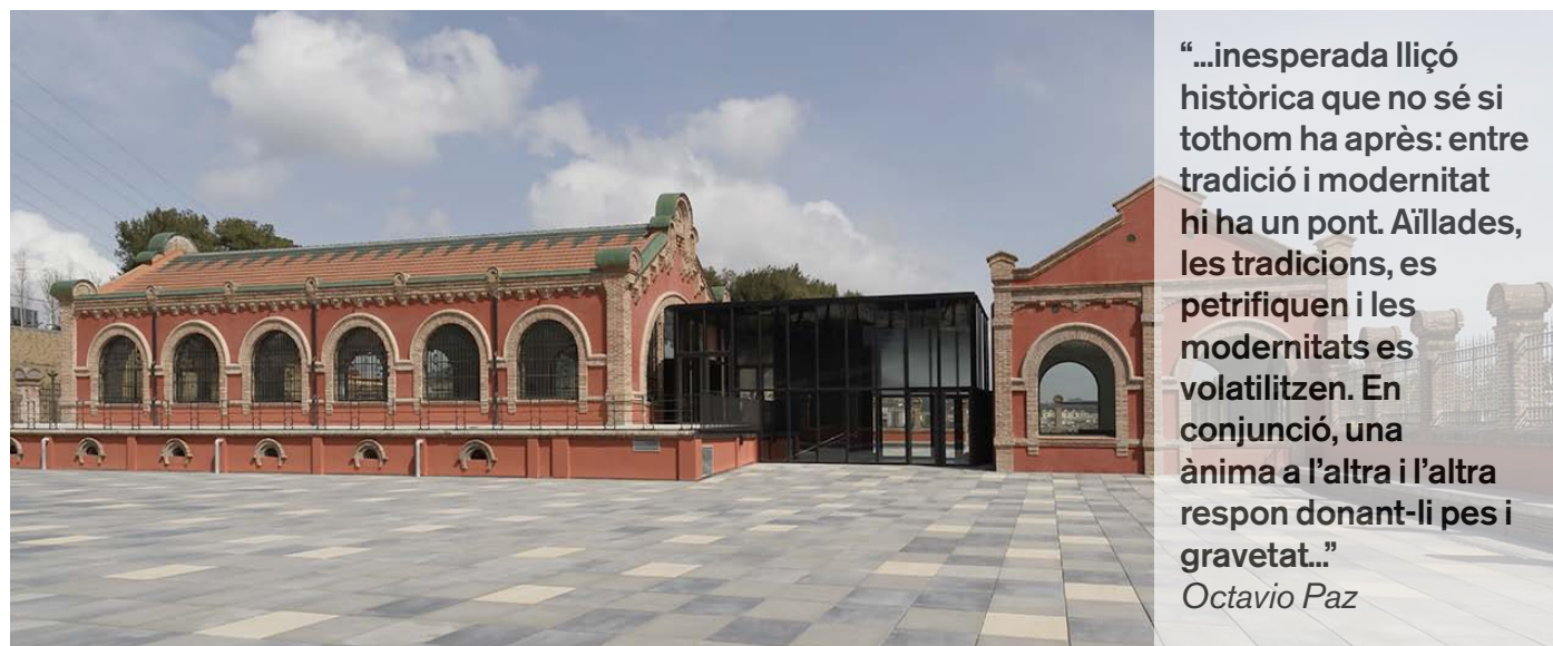
EDIFICI EN OBRES
