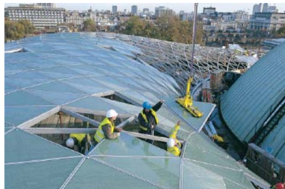
FIGURA 12. SISTEMA DE CONNEXIÓ CONTINU. PROJECTE: GREAT COURT DEL BRITISH MUSEUM. FOSTER & PARTNERS ©: WWW. NOVUMSTRUCTURES.COM/ NOVUM/INDEX.HTML
