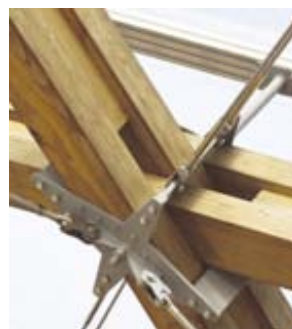
FIGURA 7: NEXE DE CONNEXIÓ EN EL PROJECTE DE WAITOMO GLOWWORM. ©: WWW.PATRICKREYNOLDS.CO.NZ
