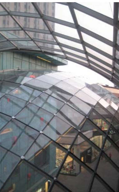
FIGURA 13. SISTEMA DE CONNEXIÓ PUNTUAL. PROJECTE: CABOT CIRCUS DE BRISTOL CRÈDITS: HTTP://WWW. NOVUMSTRUCTURES.COM/ NOVUM/INDEX.HTML
