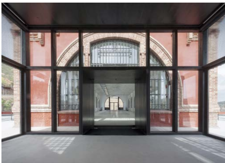
IMATGE INTERIOR DES DEL COS AFEGIT
