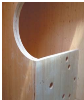
VISITA D'OBRES. ESTRUCTURA MASSISSA DE FUSTA LAMINADA. DETALL D'UNIÓ ENTRE PLANTES.
