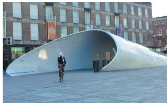
ENTRADA APARCAMENT SOTERRANI DE BICIS A EINDHOVEN
