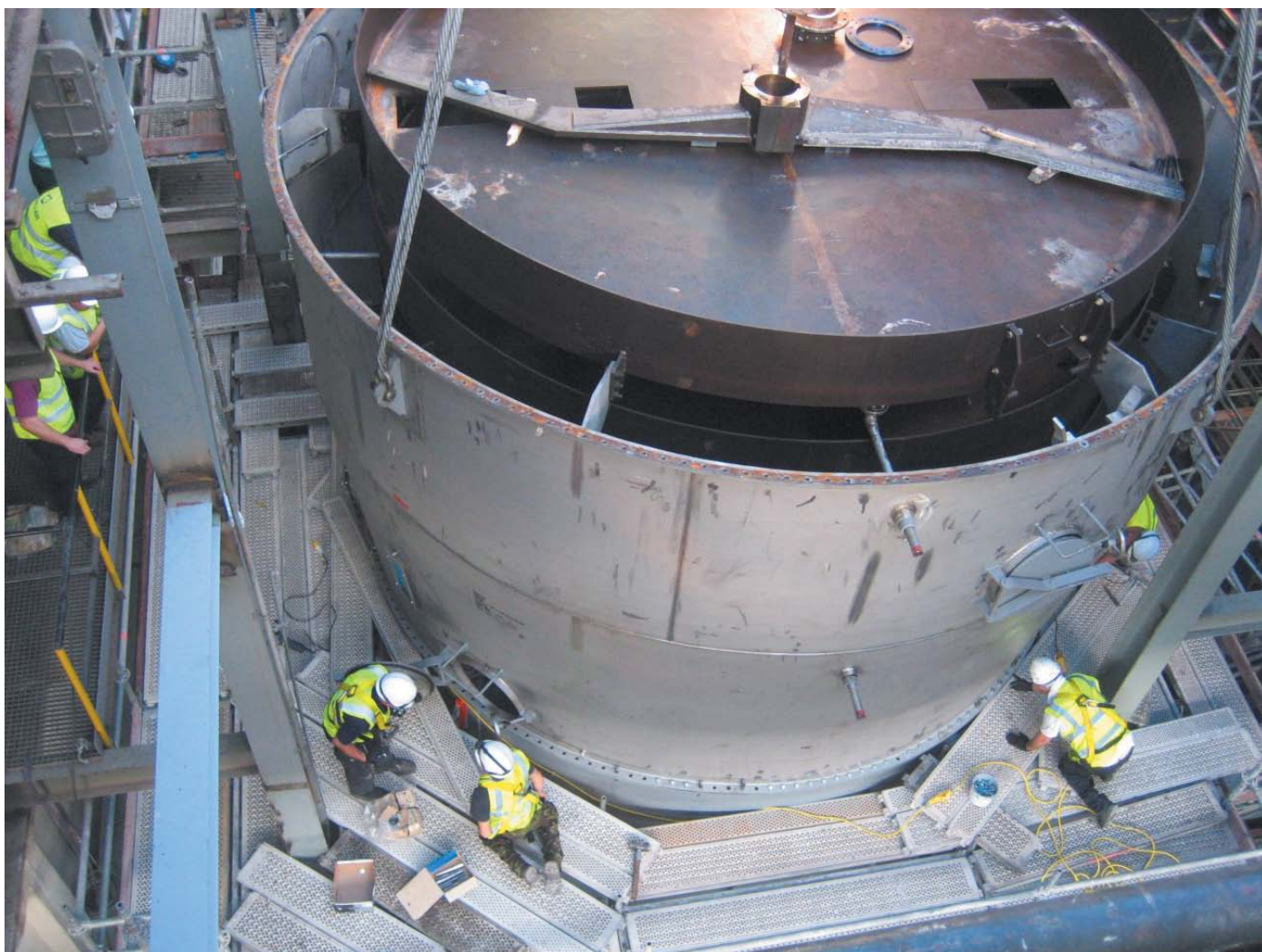
EL NOU DESOLVENTADOR DT-70 QUE ES VA INSTAL·LAR
