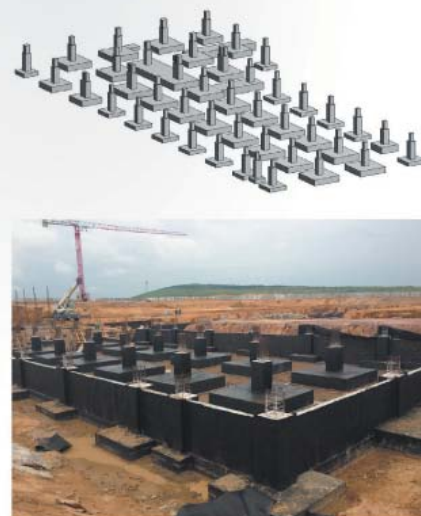
Modelo BIM vs. Realidad de la obra Modelado y detalle de cimentación
