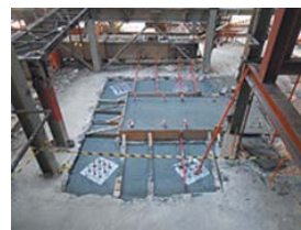
NOVA FONAMENTACIÓ DE MICROPILOTATGES I LLOSA
