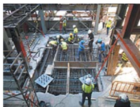
NOVA FONAMENTACIÓ DE MICROPILOTATGES I LLOSA
