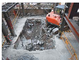
DESMUNTATGE DELS DOS DESOLVENTADORS EXISTENTS
