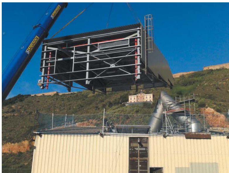
BADALOT DE LA COBERTA. TRASLLAT I MUNTATGE FINAL
