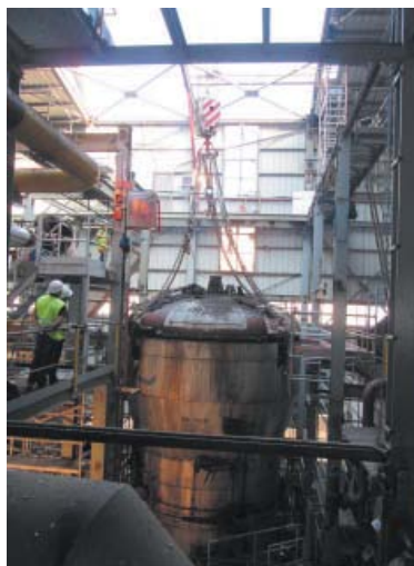
DESMUNTATGE DELS DOS DESOLVENTADORS EXISTENTS
