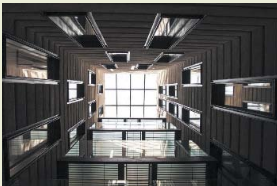
Fotografia de la obra finalitzada
