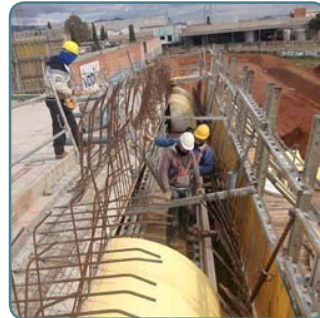
Ròtula d'unió de façana i coberta. Mostra de l'encofrat amb les peces prefabricades de poliestirè recobert amb poliurea.
