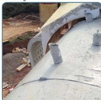
Retirada i neteja de la superfície un cop trets els motlles de la ròtula d'unió de coberta i façana.
