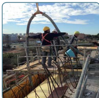
Procés de formigonat de la tercera fase. Abocat de formigó amb bomba mitjançant "xemenies" realitzades a l'encofrat de porex.
