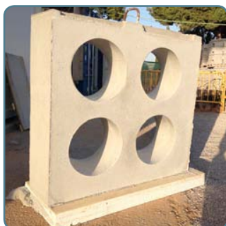
MOSTRA DE FAÇANA 1. Mostra de façana per a la verificació de l'encofrat i desencofrat de les perforacions cilíndriques mitjançant poliestirè projectat amb poliurea.
