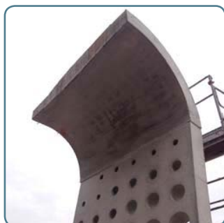
MOSTRA DE FAÇANA 2. Mostra de façana per a la verificació de l'encofrat i desencofrat de poliestirè de la ròtula d'unió entre la coberta i la façana suspensa.
