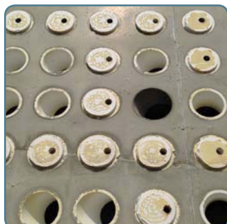
Procés de retirada de totes les peces d'emmotllat de porex i repàs dels residus adherits al formigó.
