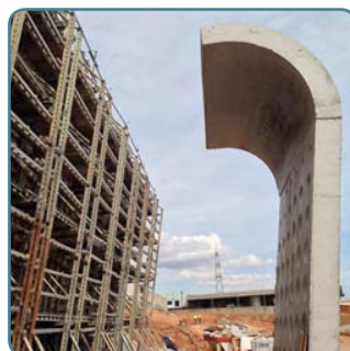
MOSTRA DE FAÇANA 3. Mostra de tram de façana. Validació de materials i processos.
