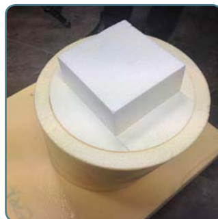
Procés de projecció de poliurea sobre els motlles de poliestirè per tal de compatibilitzar els diferents elements a l'obra i garantir el procés de desencofrat.
