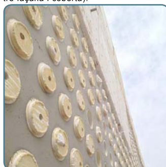
Procés de desencofrat de les perforacions cilíndriques de façana.
