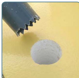
"Xemenies" de formigonat realitzades a la part superior de l'encofrat de porex projectat amb poliurea, per permetre el formigonat de la tercera fase (ròtula entre façana i coberta).
