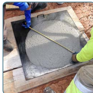
Determinació de les característiques de fluïdesa del formigó autocompactant mitjançant assaig d'escoriment.
