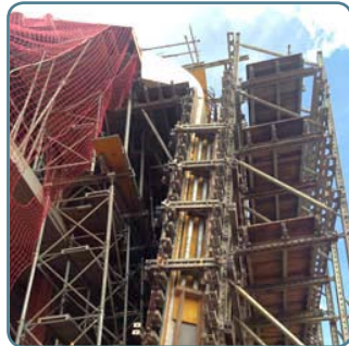
Mostra de l'encofrat del pla inclinat de façana previ al formigonat.
