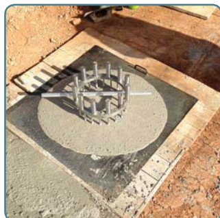
Determinació de l'assaig d'escoriment mitjançant anell japonès. Es buscava un formigó prou fluid per poder arribar a tots els racons de l'encofrat.
