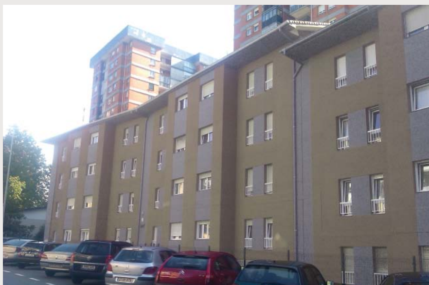
ABANS I DESPRÉS DE LA INTERVENCIÓ
