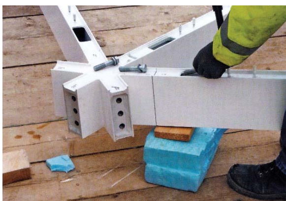
FABRICACIÓ I MUNTATGE DE NUSOS PEL PROJECTE DE WESTFIELD (LONDRES 2008). INNOVATIVE DESIGN+CONSTRUCTION. ED. DETAIL
