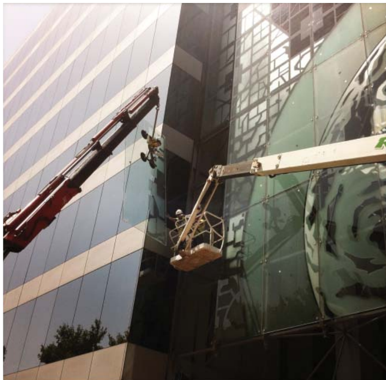
L'ÒCUL EXISTENT DE VIDRE DE COLORS S'HA SUBSTITUIT PER VIDRE TRANSPARENT, GARANTINT-NE LES PRESTACIONS DE PROTECCIÓ SOLAR
