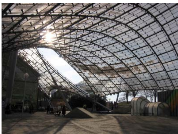
PAVELLONS ANNEXOS A L'ESTADI, EN EL PARC OLÍMPIC DE MUNIC
