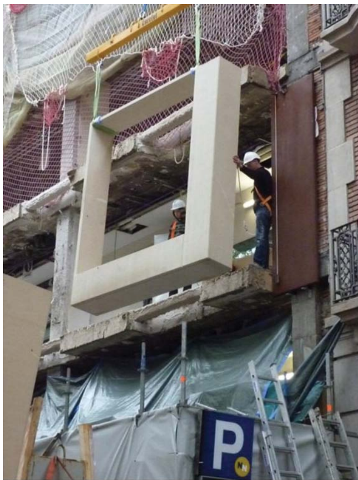
SUBSTITUCIÓ INTEGRAL DE FAÇANA D'EDIFICI D'OFICINES A LA GRAN VIA DE BARCELONA
