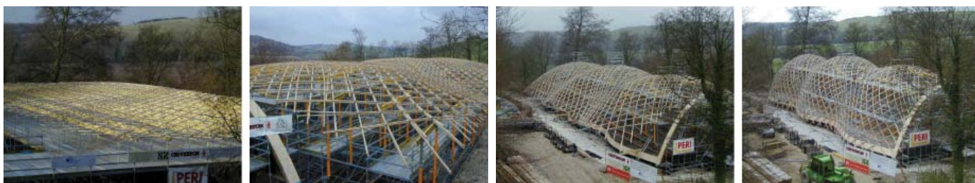
PROCÉS D'ELEVACIÓ AMB GATS HIDRÀULICS WEALD & DOWNLAND, 2002. ©: M.H.TOUSSAINT
