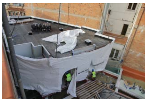
5. VISTA SUPERIOR DE L'ANTIGA TERRASSA CONVERTIDA EN LA PLANTA DE L'ÀTIC ON S'APRECIIEN LES BIGUES DE SUPORT I MÒDULS JA INSTAL·LATS, D'ESTRUCTURA D'ACER
