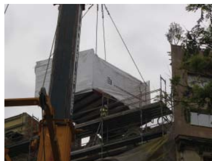
4. FINALITZACIÓ DEL PROCÉS D'HISSAT EN EL MOMENT DE DIPOSITAR EL MÒDUL A LA TERRASSA
