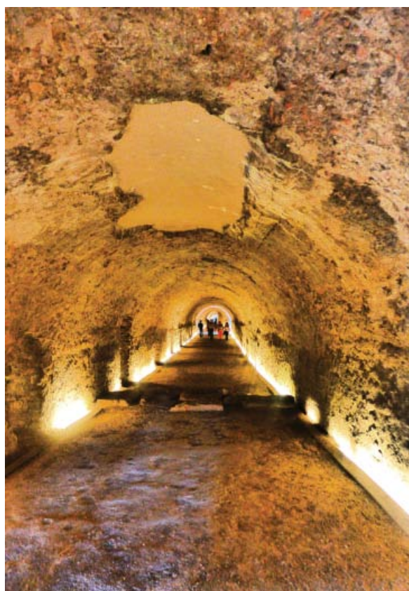
LA VOLTA SOTA DEL CARRER DE L'ENRAJOLAT
