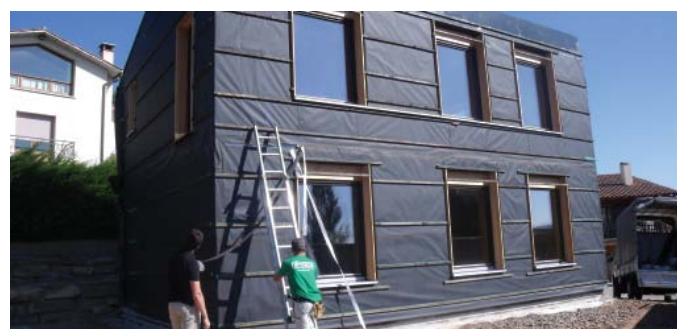
8-SEGELLAT EXTERIOR DEL L'ENVOLVENT PER GARANTIR LA ESTAN- QUEITAT DE L'HABITATGE.
