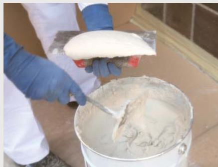
APLICACIÓ MANUAL D'UN MORTER DE REPARACIÓ NO ESTRUCTURAL
