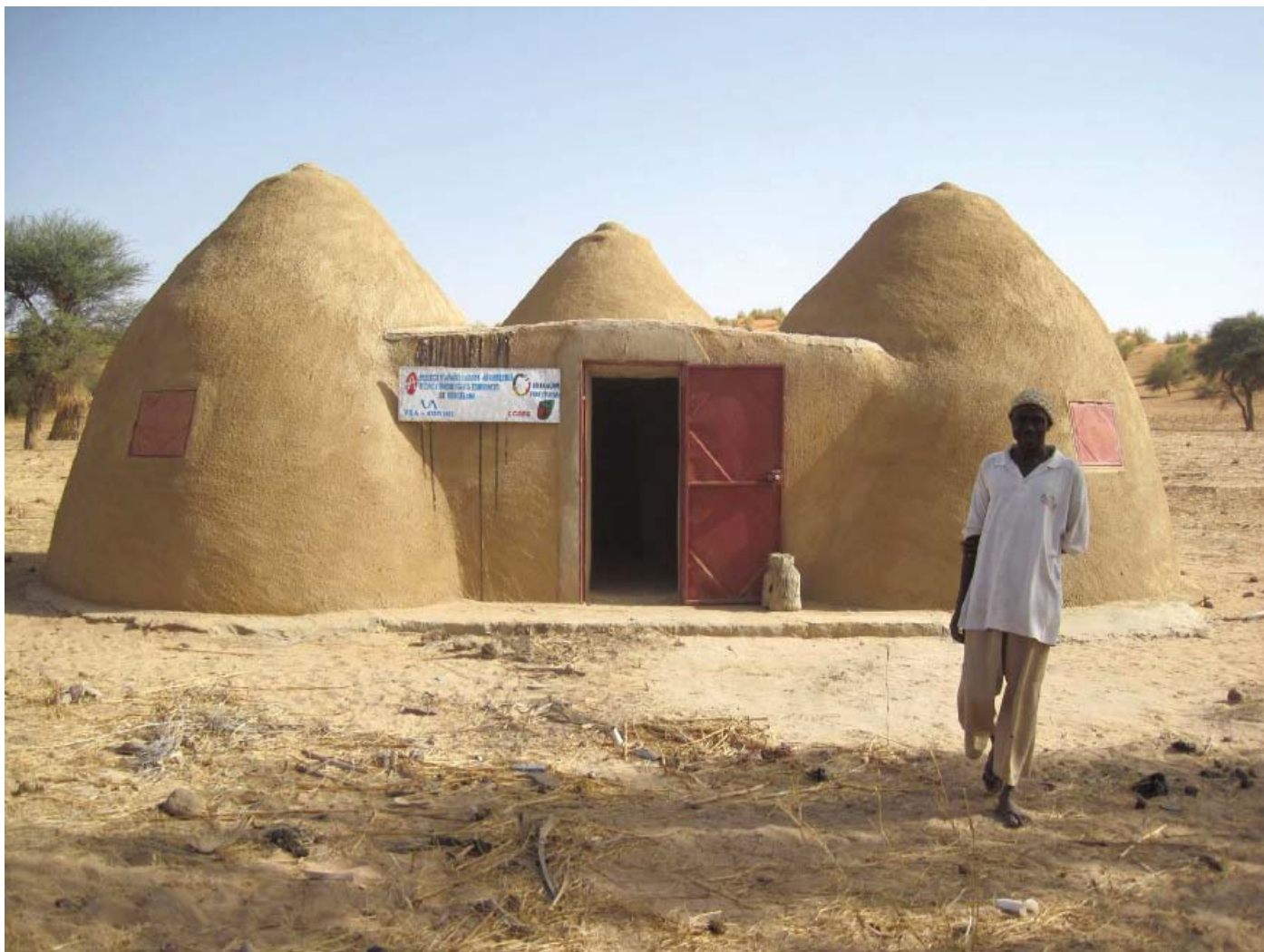
CONSTRUCCIÓ DE 10 HABITATGES AMB LA TÈCNICA DEL SUPERADOBE A LA COMUNA RURAL D'HOMBORI, MALI, AL 2012. CONG AYUDA AL DESARROLLO
