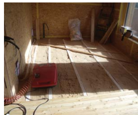
16-MUNTATGE DEL PARQUET DE FUSTA DE PLANTA BAIXA AMB COL·LOCACIÓ D'ÀLLAMENT DE FIBRA DE FUSTA ENTRE ELS RASTRELLS.
