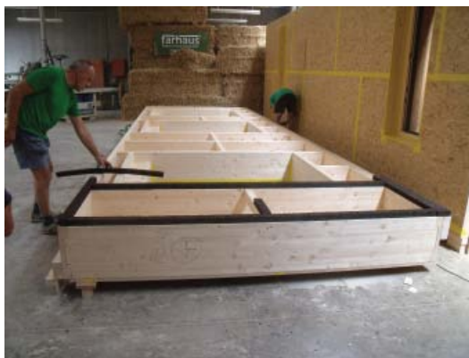
2-MUNTATGE DELS PANELLS A TALLER. COL·LOCACIÓ DE BANDES DE SURO PER TRENCAR EL PONT TÈRMIC.
