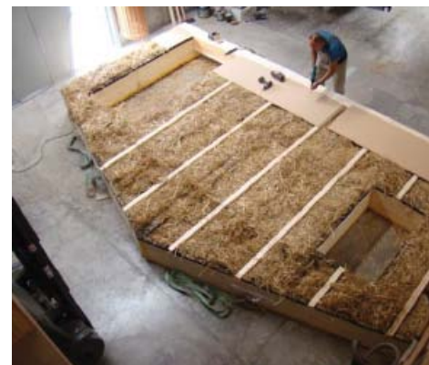
3-MUNTATGE DELS PANELLS A TALLER. COL·LOCACIÓ DELS PLAFONS DE FUSTA TRANSPIRABLE.
