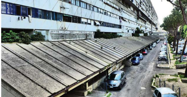
VISTA GENERAL DE LA FAÇANA DE L'EDIFICI PRINCIPAL.
