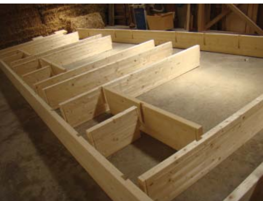
1-MUNTATGE DELS PANELLS A TALLER. COL·LOCACIÓ DELS MUNTANTS I TRAVERSERS DE FUSTA.
