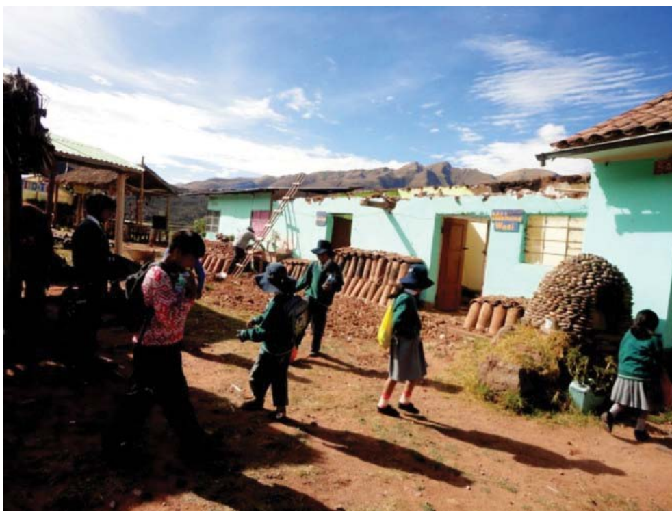
MILLORA DE LES INSTAL·LACIONS DE L'ESCOLA-ALBERG D'HUACRAPY A PERÚ
