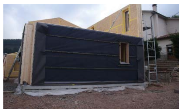
5-MUNTATGE DELS PANELLS A OBRA. ESTAT DE L'OBRA EN FINALITZAR EL SEGON DIA DE MUNTATGE.
