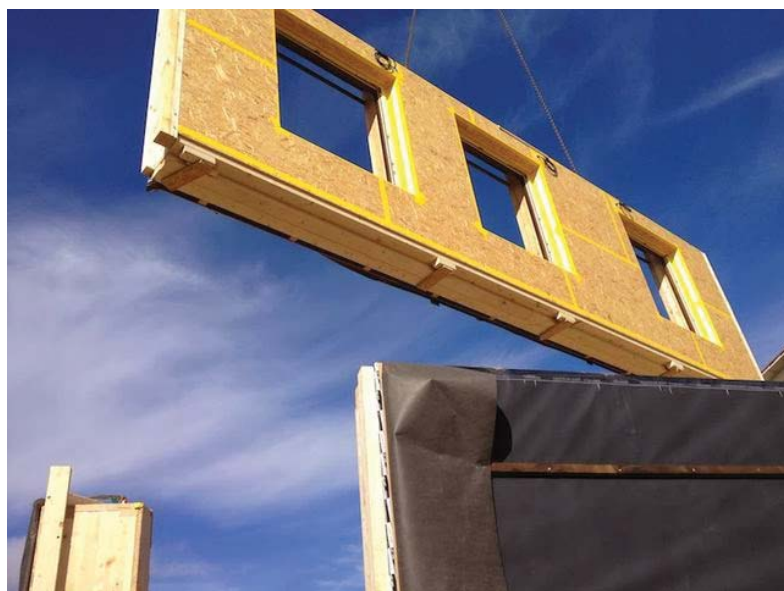
4-MUNTATGE DELS PANELLS A OBRA. MUNTATGE DEL PANELL CORRESPONENT A LA FAÇANA SUD EN PLANTA BAIXA.
