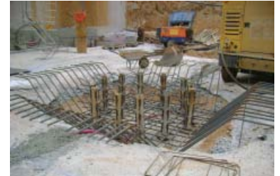
ENCEP PILAR FINALITZAT ARMAT I CON- NECTORS
