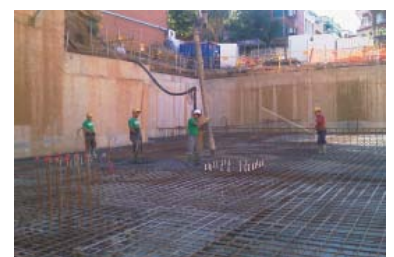
ABOCAT DEL FORMIGÓ AMB BOMBA
