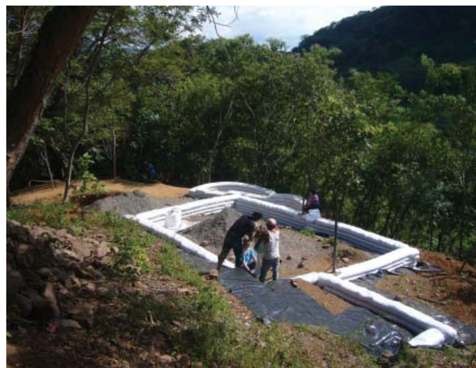
CONSTRUCCIÓ DEL CENTRE COMUNAL DE MEDECINA NATURAL PREVENTIVA A SAN RAMON, MATAGALPA (NICARAGUA)
