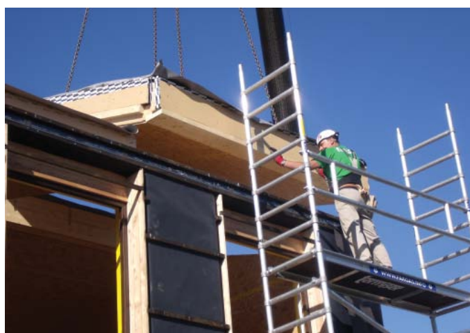
7-MUNTATGE DELS PANELLS A OBRA. COL·LOCACIÓ D'UN PANELL DE COBERTA.
