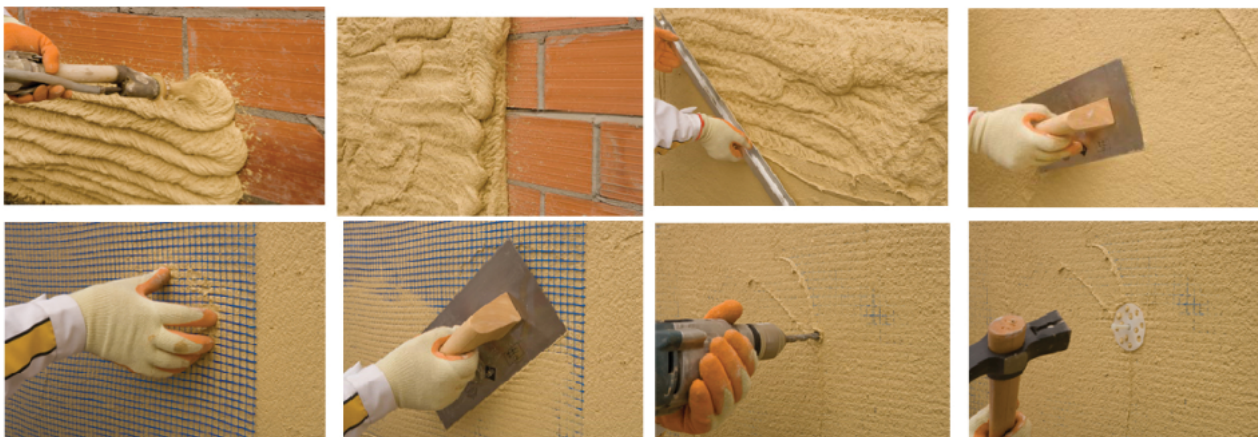
Procés d'aplicació del morter termoïllant weber.therm aislone
