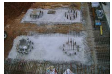
ENCEPPILARFORMIGÓIMETÀL·LICFOR- MIGONAT
