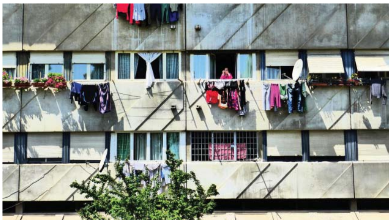
DETALL DE LA FAÇANA AMB MÒDULS DE FORMIGÓ.
