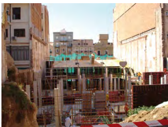
L'EDIFICI ES PERLLONGA EN FONDÀRIA FINS EL CARRERÓ POSTERIOR
