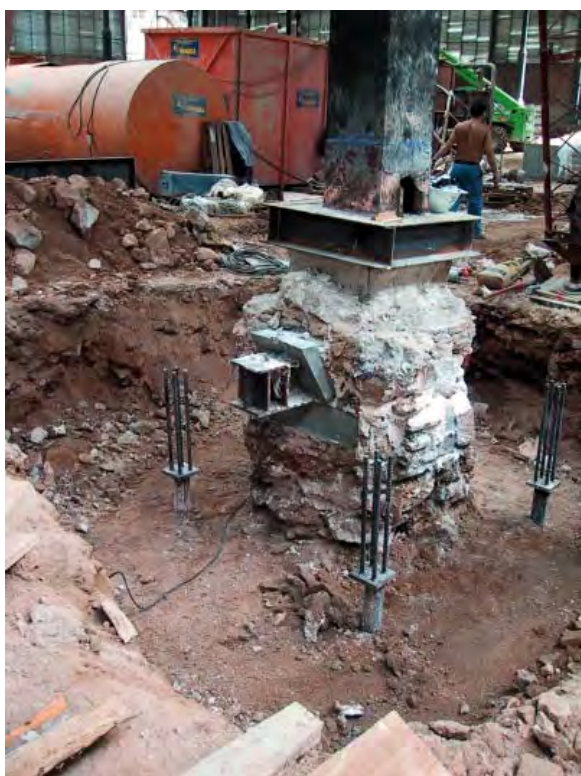
RECALÇAMENT DEL PILAR
