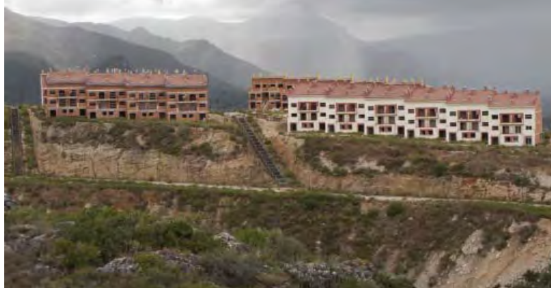
LA INACABADA URBANITZACIÓ BELLA ROTJA, A PEGO (ALACANT). JULIA SCHULZ-DORNBURG
