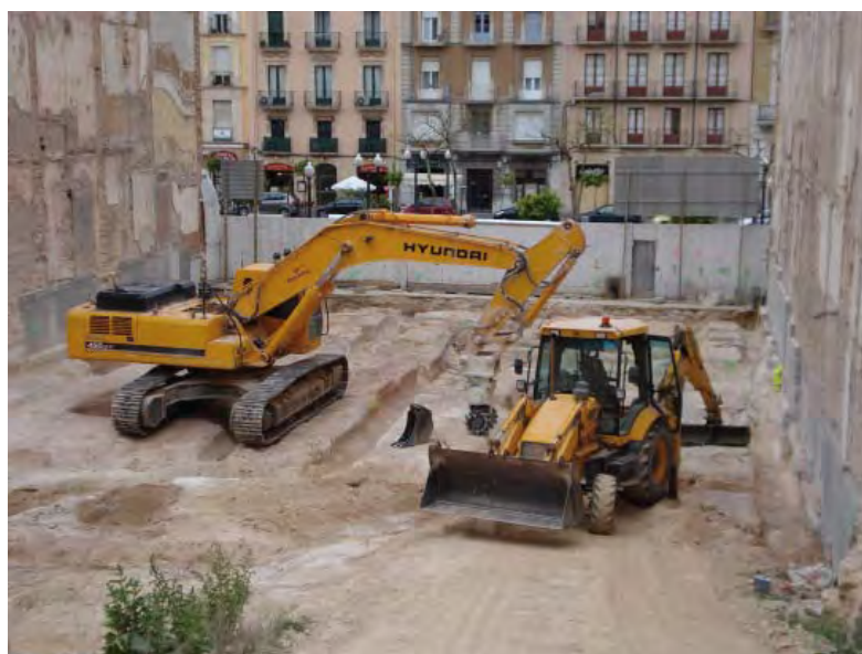
EXCAVACIÓ I ADEQUACIÓ DEL SOLAR ENTRE MITGERES
