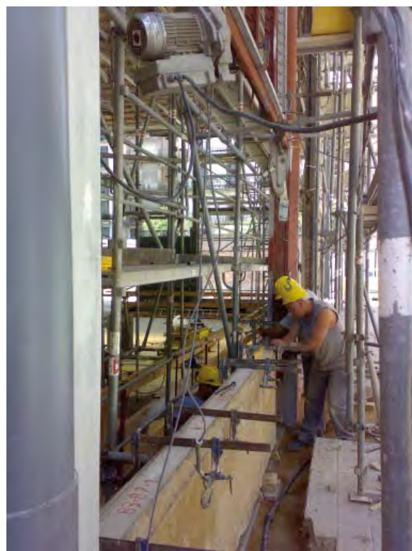
RESTAURACIÓ DE LA FAÇANA
