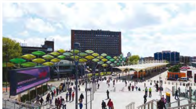
VISTA GENERAL DE L'ÀREA DE L'ESTACIÓ D'STRATFORD.
