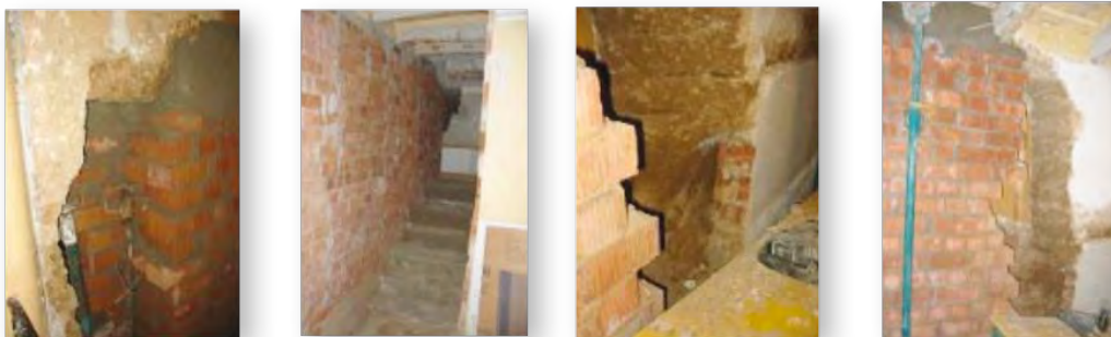
FIGURA 6.- IMATGES DE PROCÉS DE SUBSTITUCIÓ DE MITGERA DE TÀPIA PER PARET DE GERO
