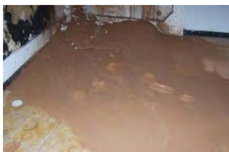
FIGURA 9.- IMATGES DE LESIÓ DE LIQÜEFACCIÓ EN PARET DE FAÇANA DE TÀPIA
