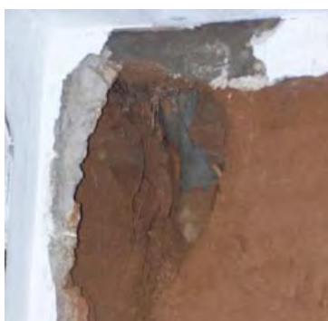
FIGURA 9.- IMATGES DE LESIÓ DE LIQÜEFACCIÓ EN PARET DE FAÇANA DE TÀPIA
