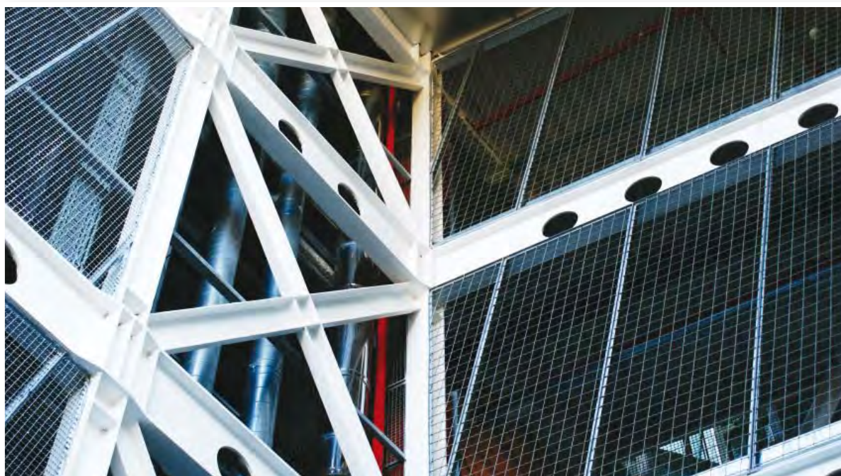
MAQUETES DE CADA UN DELS VOLUMS ON ES PODEN VEURE LES GELOSIES SUPERIORS I ELS ARRIOSTRAMENTS EN CADA ANGLE.
