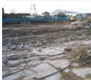
LA ZONA DE L'EAST END, ABANS DE LA INTERVENCIÓ.
