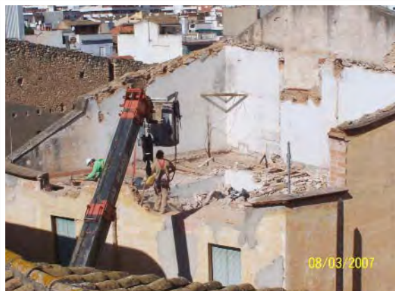
FIG 1. ENDERROC MANUAL AMB GRUA AMB CISTELLA D'EDIFICI DE TÀPIA AMB MOLT GREU RISC DE COL·LAPSE
