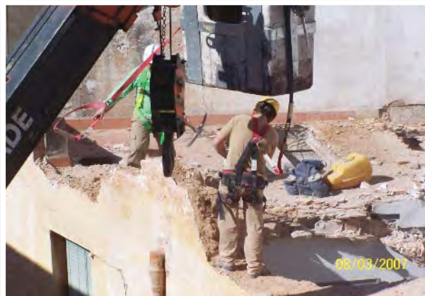
FIG 1. ENDERROC MANUAL AMB GRUA AMB CISTELLA D'EDIFICI DE TÀPIA AMB MOLT GREU RISC DE COL·LAPSE
