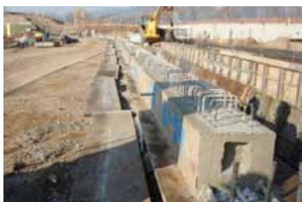
JÀSSERES PREFABRICADES IN SITU
