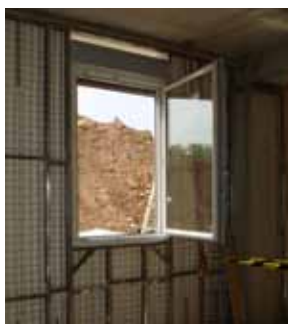
FINESTRA INTEGRADA EN EL TANCAMENT
