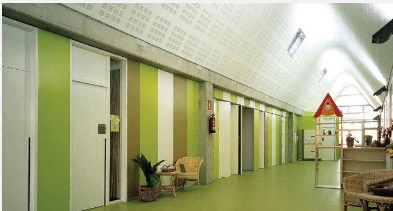
L'ESCOLA BRESSOL A TORRE-SANA (TERRASSA) FA SERVIR PER A LA CALEFACCIÓ UNA CALDERA DE BIOMASSA QUE UTILITZA RESIDUS VEGETALS PROCEDENTS DE LES PODES I NETEGES FORESTALS QUE FA LA BRIGADA MUNICIPAL, EVITANT AIXÍ L'ÚS DE COMBUSTIBLES FÒSSILS
