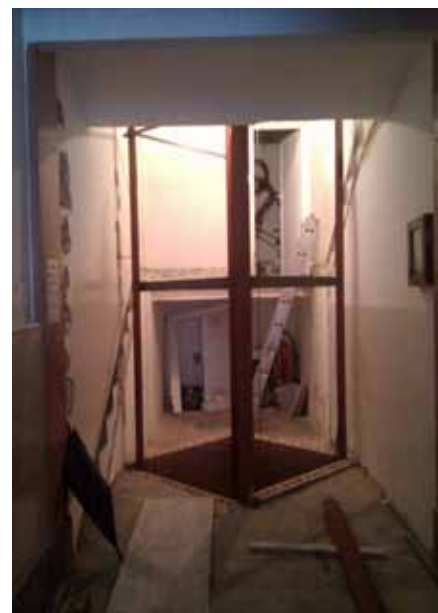
EL FOSSAT I ÀMBIT DEL ASCENSOR
