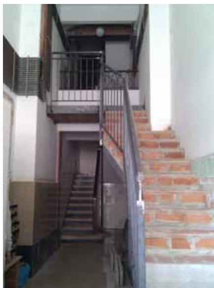
CONSTRUCCIÓ DE LA NOVA ARRENCADA DE L'ESCALA AMB L'ORIGINAL AL FONS
