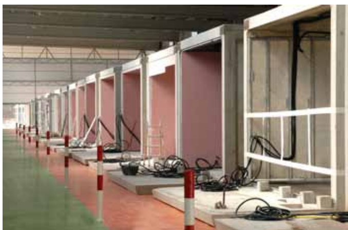
FABRICACIÓ DELS MÒDULS AL TALLER I TRANSPORT PER CARRETERA
