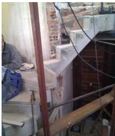
POSADA EN OBRA DE LA COSTELLA I ELS GRAONS PREFABRICATS
