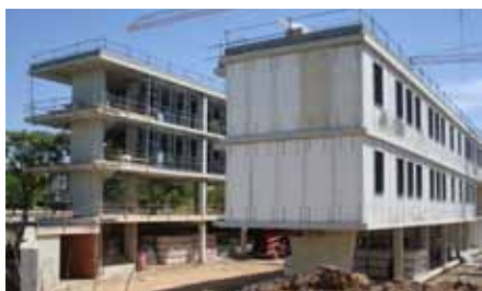
FASE OBRA ESTRUCTURA I TANCAMENTS MK2
