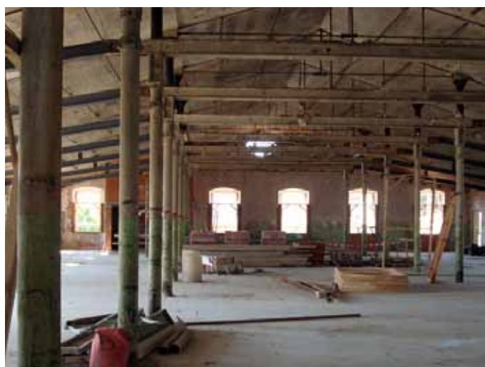
ESTRUCTURA DE PÒRTICS DE FOSA AMB UN SISTEMA D'UNIONS PER ENCAIXOS I FIXACIONS AMB CARGOLS
