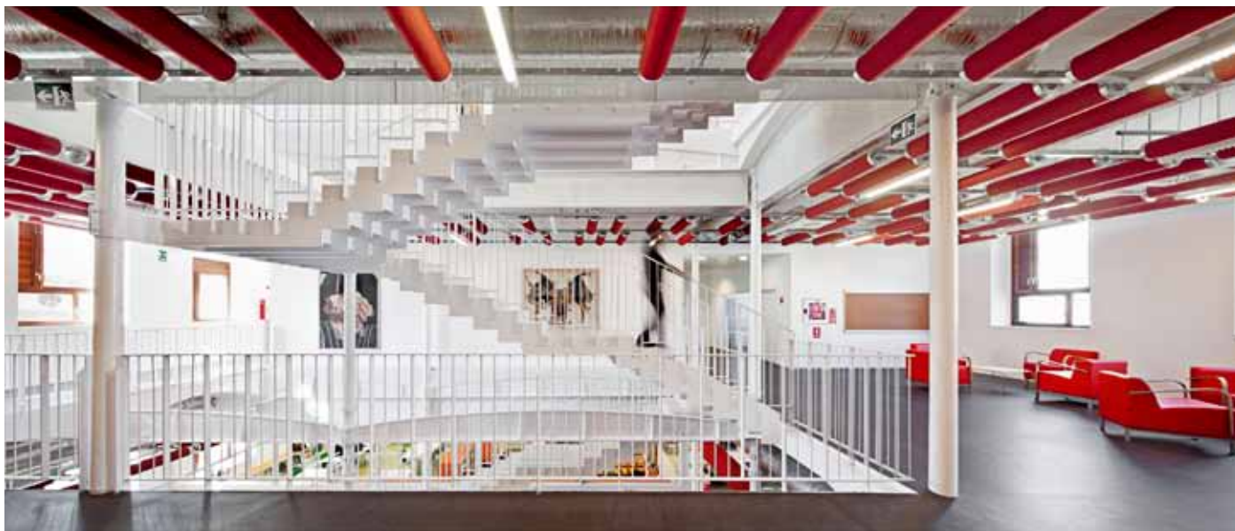
IMATGE INTERIOR DE L'EQUIPAMENT ACTUAL I DEL FALS SOSTRE ACÚSTIC AMB INSTAL·LACIONS VISTES
