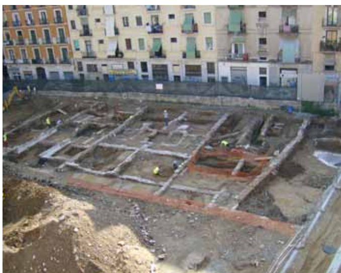
TREBALLS DE PROSPECCIÓ ARQUEOLÒGICA PREVIS A L'INICI DE L'OBRA
