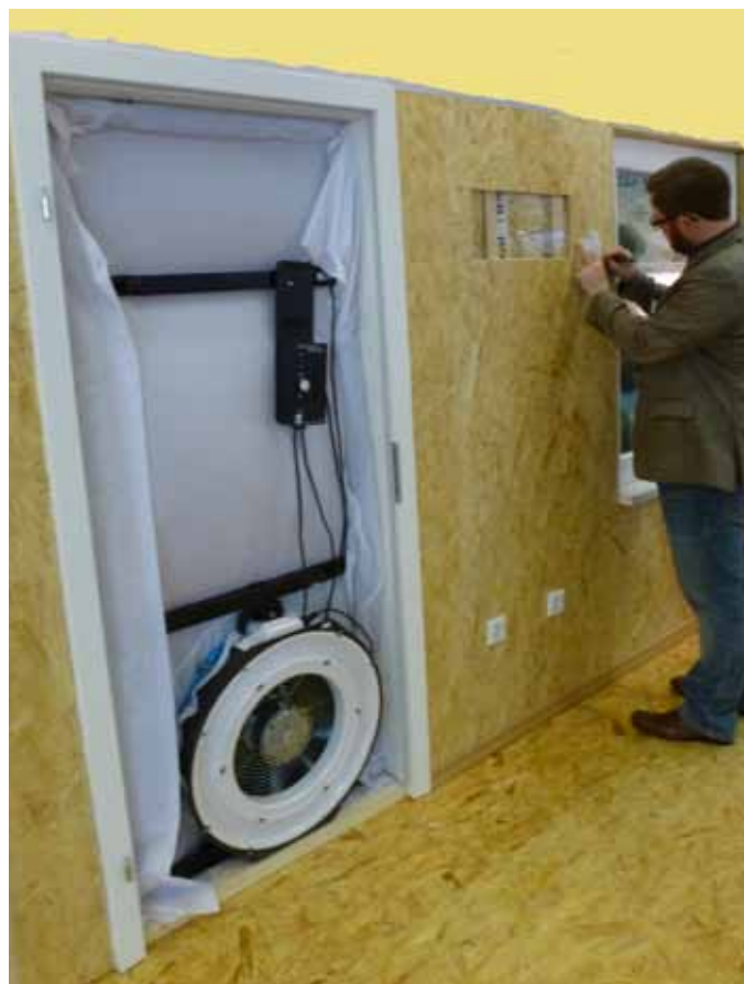
L'AÏLLAMENT I L'ESTANQUITAT SÓN DOS FACTORS CLAU EN LA MILLORA TÈRMICA DELS HABITATGES. EL BLOWER-DOOR TEST ÉS UNA PROVA SENZILLA QUE ENS PERMET DETERMINAR AMB PRECISIÓ LES INFILTRACIONS I LA SEVA IMPORTÀNCIA
