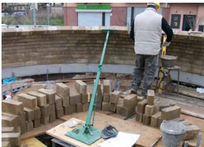
SISTEMA AMBELEMENT TELESCÒPIC PER A L'EXECUCIÓ DE CÚPULA NÚVIA AMB BLOC DE TERRA COMPRIMIT A L'ESCOLA BRESSOL DE SANTA EULÀLIA DE RONÇANA
