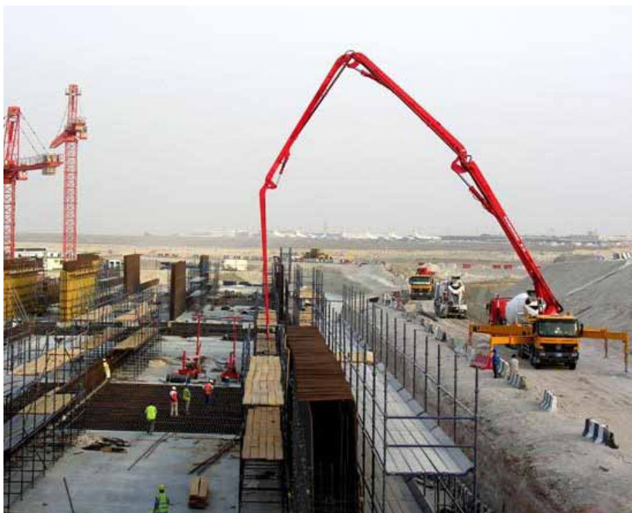
EXECUCIÓ D'OBRES DE GRAN ENVERGADURA A EQUADOR
