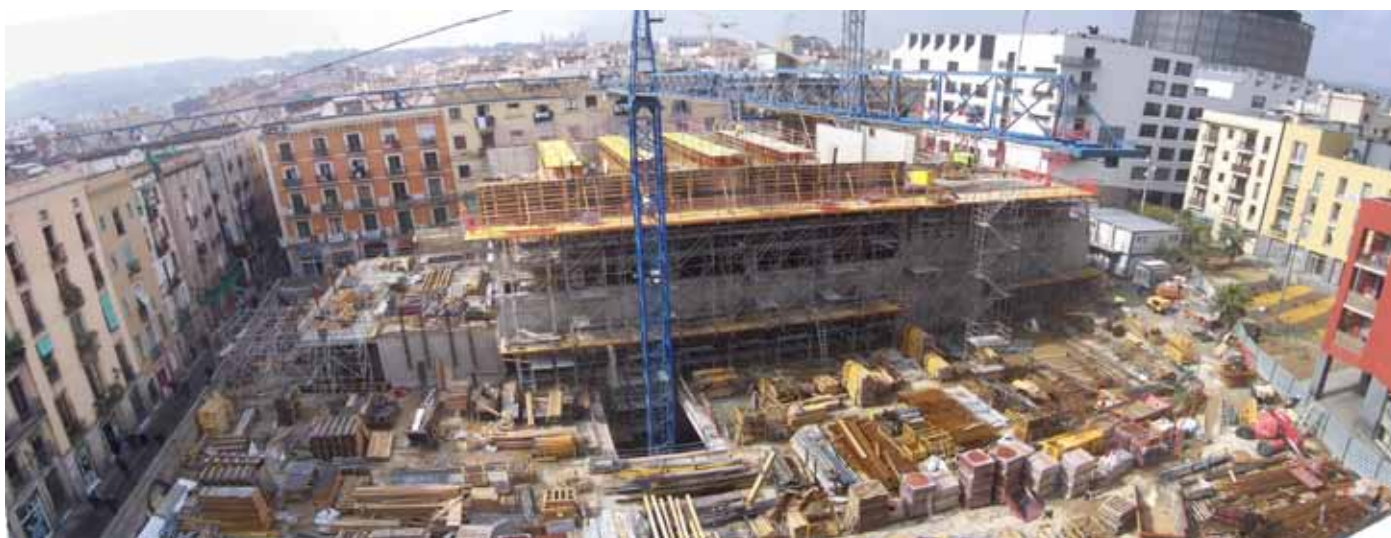
LA COMPLEXITAT DEL PROCÉS D'EXECUCIÓ FEIA IMPRESCINDIBLE UNA ORGANITZACIÓ I PLANIFICACIÓ MOLT ACURADES
