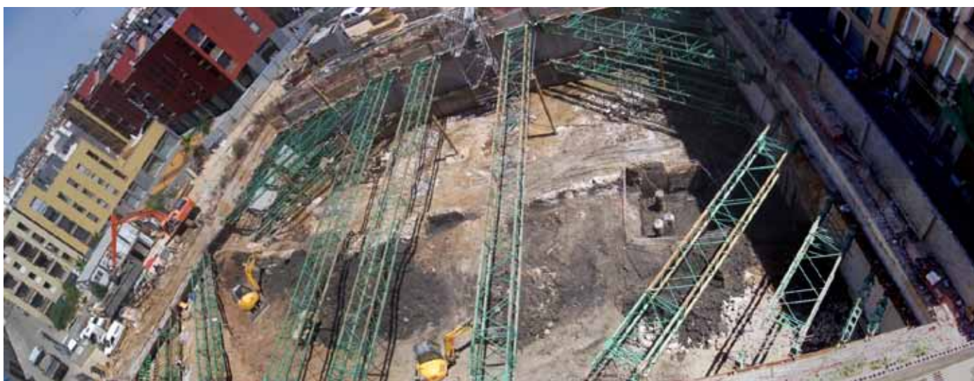
ESTINTOLAMENT DE LA PANTALLA PERIMETRAL I EXCAVACIÓ DEL SOLAR
