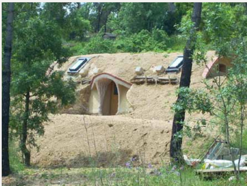
BANYS SEMISOTERRATS AMB VOLTA DE CANÓ, ESTRUCTURA DE BAMBÚ I PROJECTADA AMB TERRA, FIBRES VEGETALS I CALÇ, ACABAT EN JARDINAT
