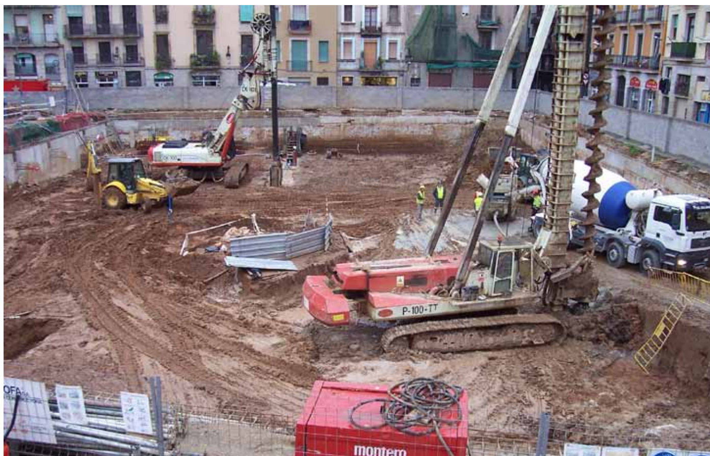
INICI DELS TREBALLS DE FONAMENTACIÓ AMB LA PRESERVACIÓ DE LES DARRERES ZONES DE TREBALL DELS ARQUEÒLEGS
