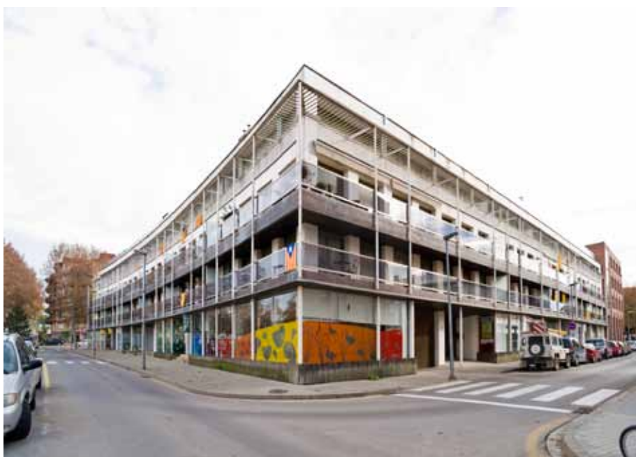
HABITATGES DE LA VILA OLÍMPICA DE BANYOLES
