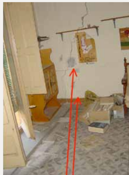
ESQUERDES (5), EN PLANTA PRIMERA QUE MARQUEN EFECTE D'ARC DE DESCÀRREGA PEL PROCÉS DE DESCENS DE LA MITGERA
