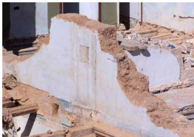
FIG1: IMATGES DE PARETS DE TÀPIA. L'ÚLTIMA IMATGE ÉS D'UN EDIFICI EN FASE DE DESCONSTRUCCIÓ, I S'HI POT APRECIAR LA COMPOSICIÓ DE LA SECCIÓ DE LA PARET DE TÀPIA
