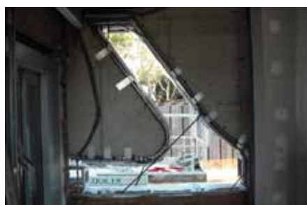
LA FUSTERIA EXTERIOR ÉS DE PERFILERIA OCULTA, AMB FORMES I DIMENSIONS ESPECIALS, INCLINADES, CORBADES, DESPLOMADES
