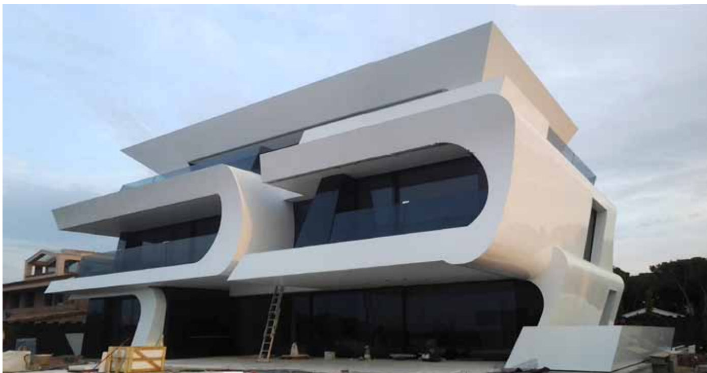
A PARTIR DEL TOPOGRÀFIC GENEREM UNA IMATGE VIRTUAL DE LA FAÇANA, QUE PERMET DISTRIBUIR ELS PANELLS D'ALUMINI, OPTIMITZAR EL MATERIAL I REDUIR EL NÚMERO DE JUNTES
