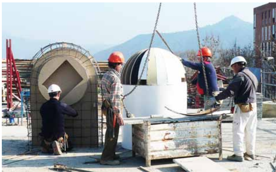
EXECUCIÓ DE L'ESCOLA EL TURONET A Cerdanyola. Amb una bona coordinació i vigilància de la seguretat
