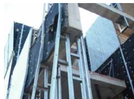
DETALL DE LA COL·LOCACIÓ DEL REVESTIMENT DE FAÇANA
