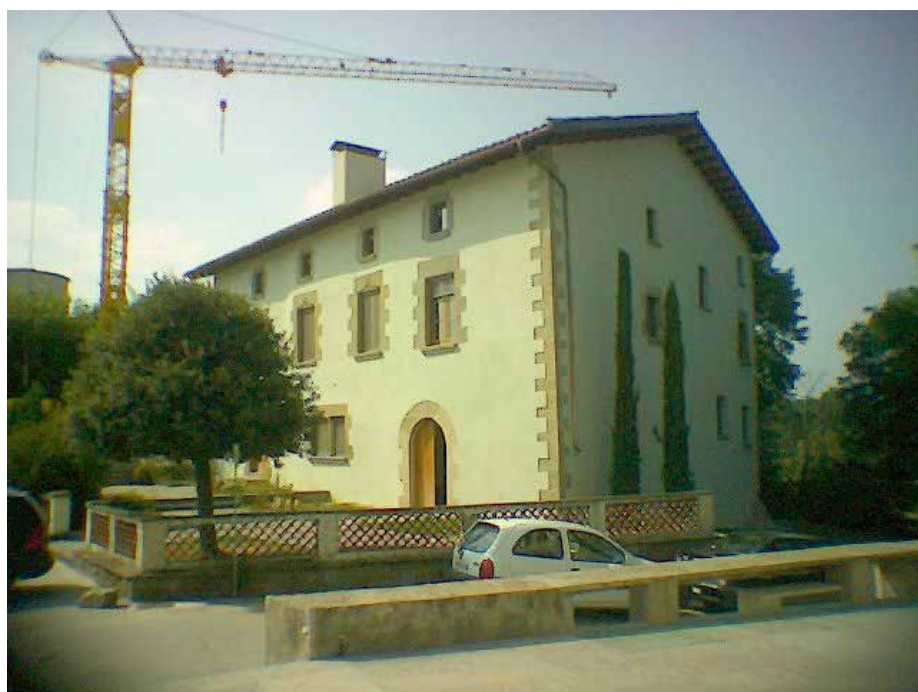
REHABILITACIÓ DE EL MACIÀ, A LES MASIES DE RODA, AMB SISTEMA SOLAR TÈRMIC
