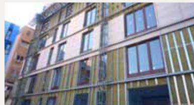
CONSTRUCCIÓ HABITATGES AL CARRER ROC BORONAT DE BARCELONA, PRIMER EDIFICI RESIDENCIAL, AMB CLASSIFICACIÓ ENERGÈTICA A A BARCELONA, DE TÈCNICS G3
