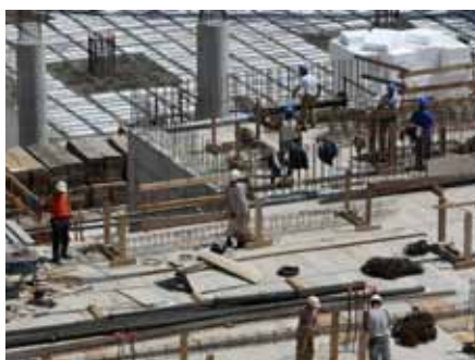
OBRES DE LA CLÍNICA DIAGONAL; AMB UNA BONA EXECUCIÓ I COORDINACIÓ DE SEGURETAT
