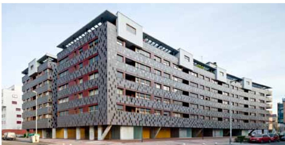
FIGURA 3: EDIFICI DE VIVENDES A BARAKALDO
