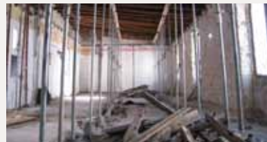
INTERVENCIÓ EN L'EDIFICI D'HABITATGES A LES BASSES DE SANT PERE DE BARCELONA, DE L'EQUIP D'ARQFÒRUM
