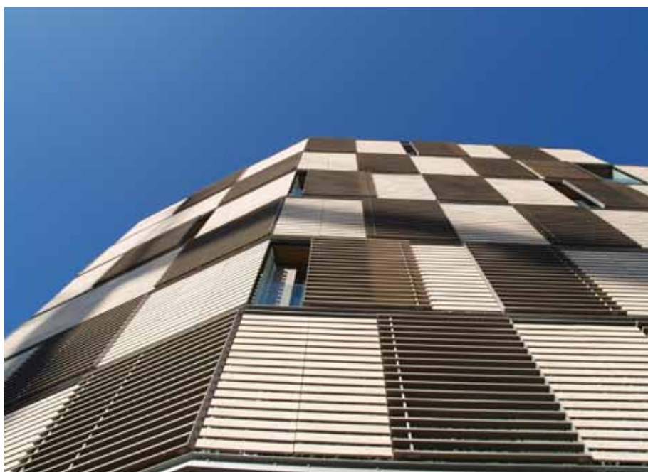
FIGURA 2: DETALL DE FAÇANA A BARCELONA
