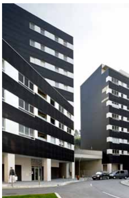
FIGURA 1: EDIFICI DE VIVENDES A ELGOIBAR
