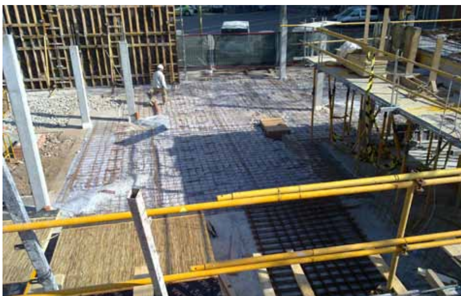
UNA IMATGE DE L'OBRA EN PROCÉS D'EXECUCIÓ
