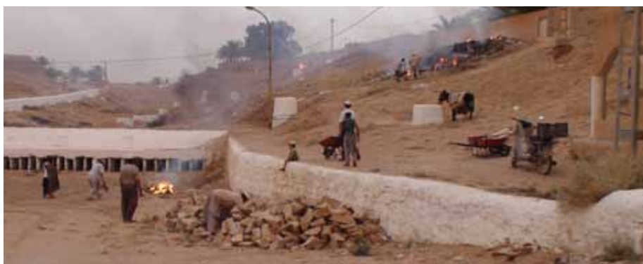
ELS TREBALLS DE MANTENIMENT REALITZATS PER LA TOUIZA EN ELS PALMERARS I ALS VOLTANTS DELS ENGINYS HIDRÀULICS N'FAVOREIXEN EL SEU CORRECTE FUNCIONAMENT
