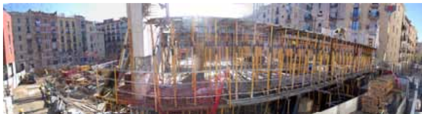
PROCÉS CONSTRUCCIÓ DE LA NOVA SEU DE LA FILMOTECA DE CATALUNYA
