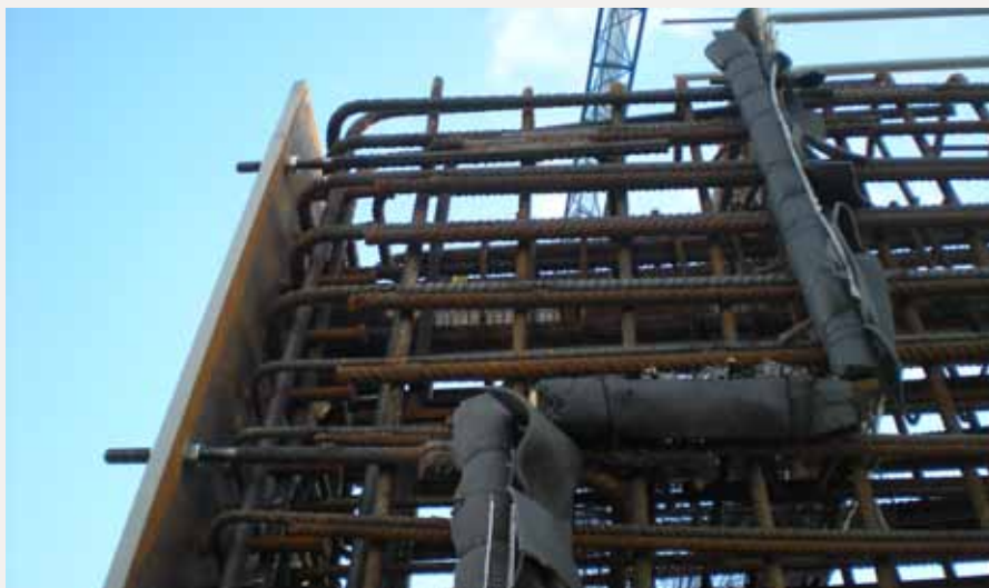
VISTA DE LA PLACA D'ANCORATGE SUPERIOR. S'OBSERVEN ELS PERNS D'ANCORATGE ABANS DE FORMIGONAR LA PRIMERA FASE PER DEIXAR-LOS SUBJECTES. ENTRE FASES DE FORMIGONAT ES COL·LOCA UN PANELL TIPUS NERVOMETAL AMB AÏLLAMENT (COL·LOCAT EN EL LÍMIT AMB LA CARA D'ENCOFRAT) PER CONFINAR EL LÍMIT DE FORMIGONAT I EVITAR FUITES DEL FORMIGÓ DE CONSISTÈNCIA FLUIDA.
