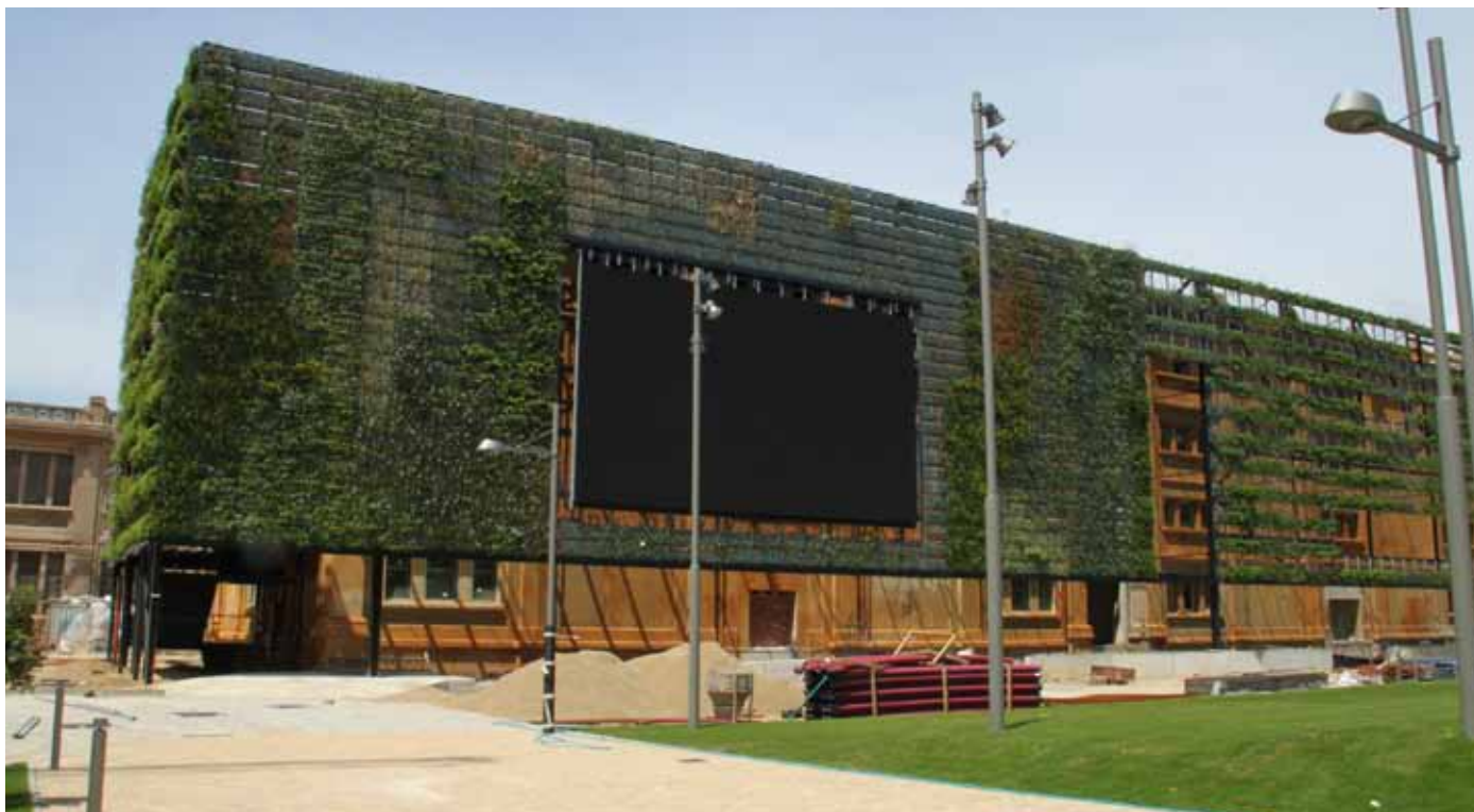
UNA REHABILITACIÓ, CADA DIA MÉS COMPLEXA, EXIGEIX CONCEPCIONS, TÈCNiques I MATERIALS ADEQUATS
