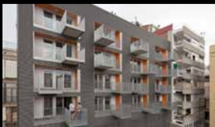
Edifici Cibeles, 32 habitatges dotacionals, CAP Vila de Gràcia i aparcament a Barcelona. Candidatura: Jaume Millat i Marcos Camba. Empresa: GPO Ingeniería.
