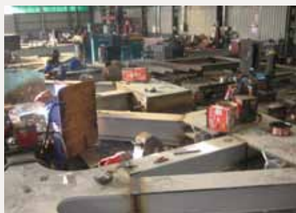
VISTA GENERAL DE L'ACOBAMENT DELS ANCORATGES AL PRIMER MÒDUL. ES TRACTA LA ZONA ON, A MÉS, ELS HEB-400 I IPE-400 ESTAN TANCATS AMB XAPONS PER PRECISAR MAJOR RIGIDESA QUE LA RESTA DE L'ESTRUCTURA
