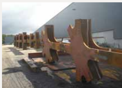
S'OBSERVEN ELS PILARS JA ACOBLATS. S'OBSERVEN COM LES XAPES DE LA FOTOGRAFIA ANTERIOR JA S'HAN SOLDAT CONTRA ELS PERFILS HEB-400 O IPE-400, SEGONS EL CAS, PER CONFORMAR ELS NUSOS, I AQUESTS AL SEU TORN S'UNEIXEN ALS PILARS
