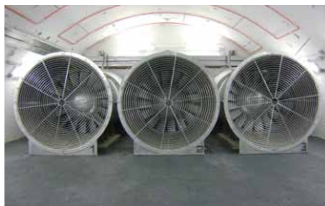
FIG. 7. DETALL POU VENTILACIÓ TÚNEL
