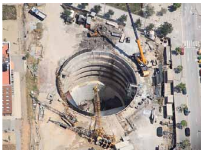
FIG. 2. IMATGE FASE OBRA CIVIL D'UN POU
