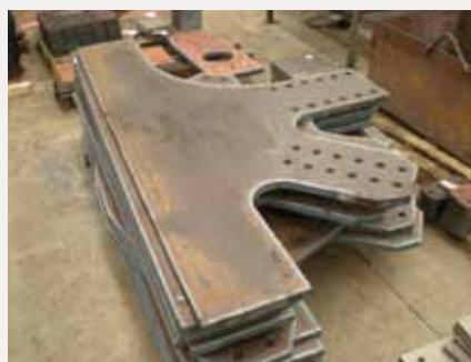
PECES PENDENTS D'ACOBLEAR PER A CONFORMAR UN PILAR. ES TRACTA DELS NUSOS DE LA PART SUPERIOR DELS VOLADISSOS, JA QUE EN UNA CARA NO TENEN ENTRONCAMENT
