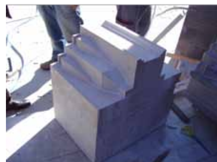
A PART DE MARCAR TOTES LES PECES QUE ES DESMUNTAVEN O MANIPULAVEN PER RESTAURAR I TORNAR A RECOL·LOCAR. DISCRETAMENT, CADA NOVA PEÇA PORTA IMPRESA LA DATA "AD MMV", TESTIMONI RIGORÓS DE LA INTERVENCIÓ ACTUAL
