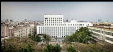
Habitatges de protecció oficial al barri del Raval de Barcelona. Candidatura: Salvador Arisa.
