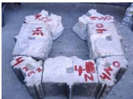
A PART DE MARCAR TOTES LES PECES QUE ES DESMUNTAVEN O MANIPULAVEN PER RESTAURAR I TORNAR A RECOL·LOCAR. DISCRETAMENT, CADA NOVA PEÇA PORTA IMPRESA LA DATA "AD MMV", TESTIMONI RIGORÓS DE LA INTERVENCIÓ ACTUAL
