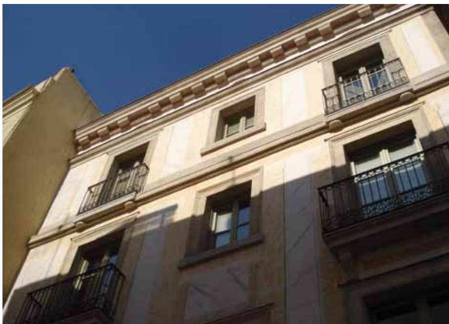
FAÇANA DEL PATI POSTERIOR D'EDIFICI CATALOGAT D'HABITATGES AL CARRER PORTAFERRISSA DE BARCELONA. REHABILITACIÓ INTEGRAL REALITZADA PER JOAN RAMON FREIRE I PABLO SEN ROLDUÀ
