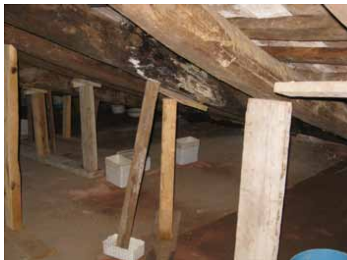
PATOLOGIES GENERADES PER MANCA DE MANTENIMENT EN DIVERSOS MONUMENTS. ESTRUCTURA MALMESA PER MANCA DE MANTENIMENT A LA COBERTA
