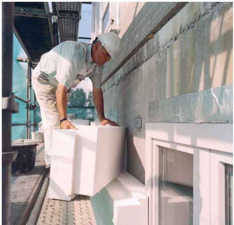
INSTAL·LACIÓ DE PANELLS D'AÏLLAMENT DE POLIESTIRÈ
