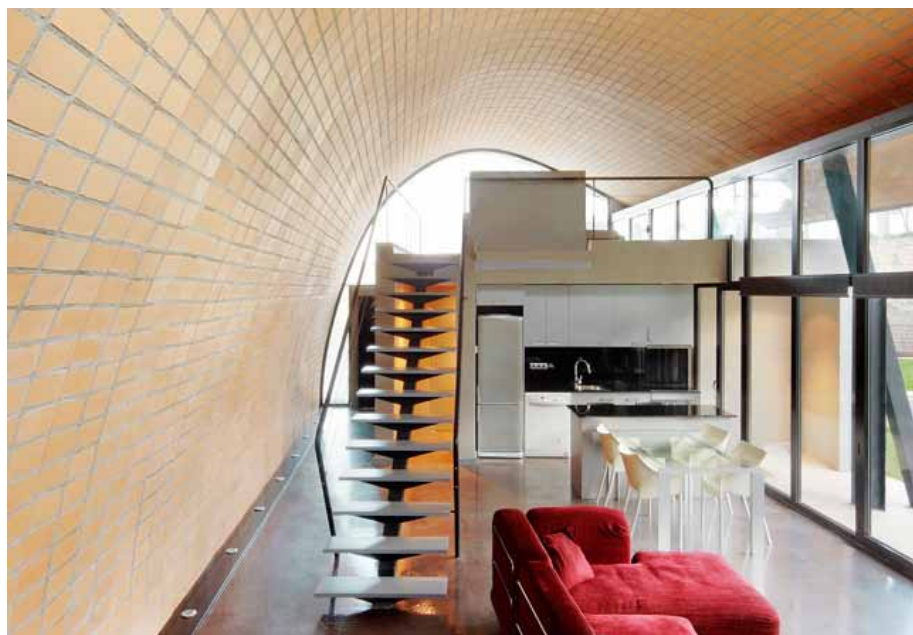
EL TEIXIT CERÀMIC FLEXBRICK ÉS UN INNOVADOR SISTEMA INDUSTRIALITZAT DE TRENAT DE BARRES D'ACER QUE SUSTENTA UNA RETÍCULA DE PECES D'ARGILA DISPOSADEN TAULA. A LA FOTO, APLICAT A LA CASA MINGO DE SANT MARTÍ DE TOUS
