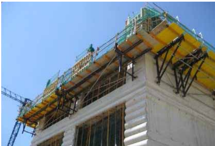
ENVOLUPANT VERTICAL EXTERIOR: FAÇANA PORTANT DE FORMIGÓ VIST IN SITU AMB MOTLLURES
