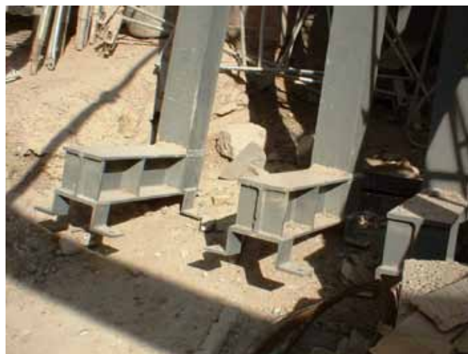
BASE PILAR EN MÈNSULA PREPARADA A TALLER
