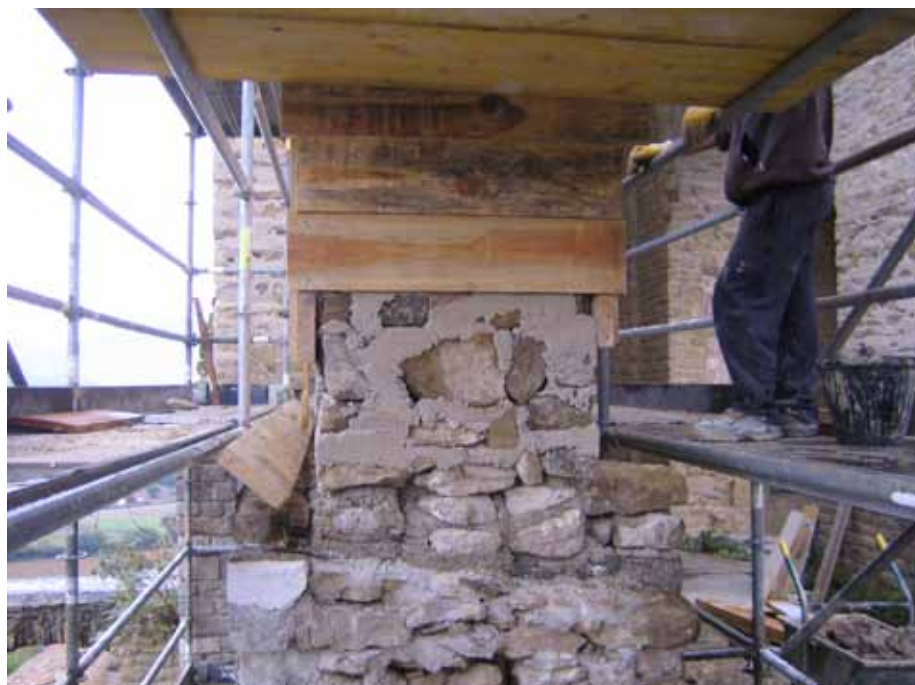
CONSTRUCCIÓ AMB SISTEMA TAPIAL DELS MURS
