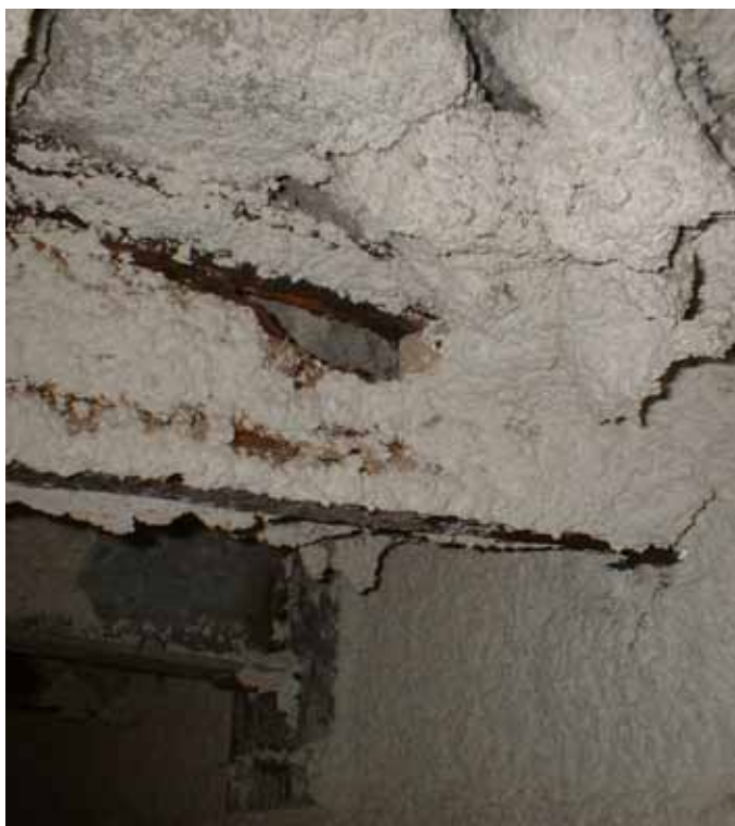
ESTAT DEL PERFIL "AMAGAT" PER LA PROTECCIÓ IGNÍFUGA FETA EN REHABILITACIONS ANTERIORS
