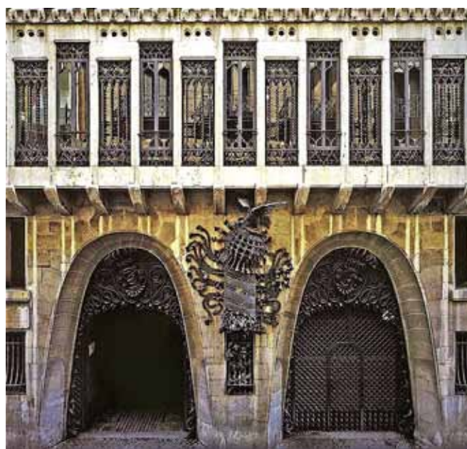
FOTOGRAFIA DE L'ACCÉS DES DE LA FAÇANA PRINCIPAL AL CARRER NOU DE LA RAMBLA
