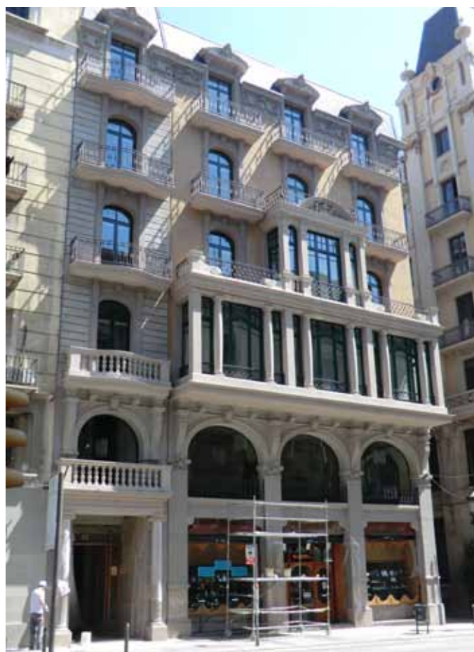
FAÇANA DE VIA LAIETANA REHABILITADA
