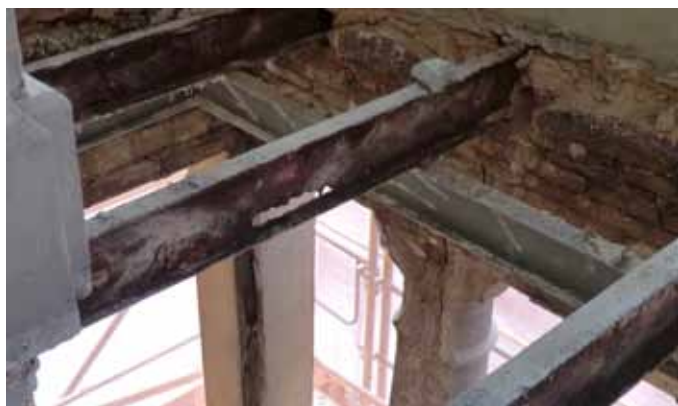
PATOLOGIES "AMAGADES" PELS REVOLTONS CERÀMICS AMB MORTERR DE CALÇ
