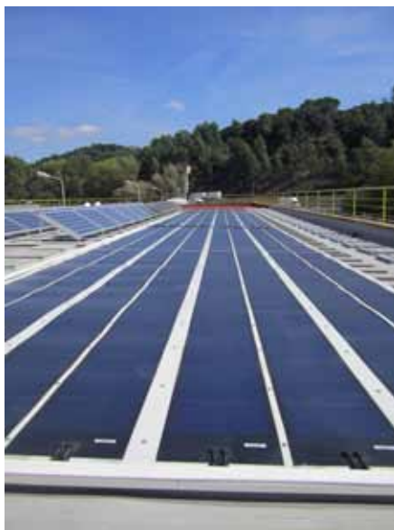
LÀMINES D'IMPERMEABILITZACIÓ DE PVC AMB CÈL·LULES FOTOVOLTAÏQUES A LA FÀBRICA DE RENOLIT A SANT CELONI
