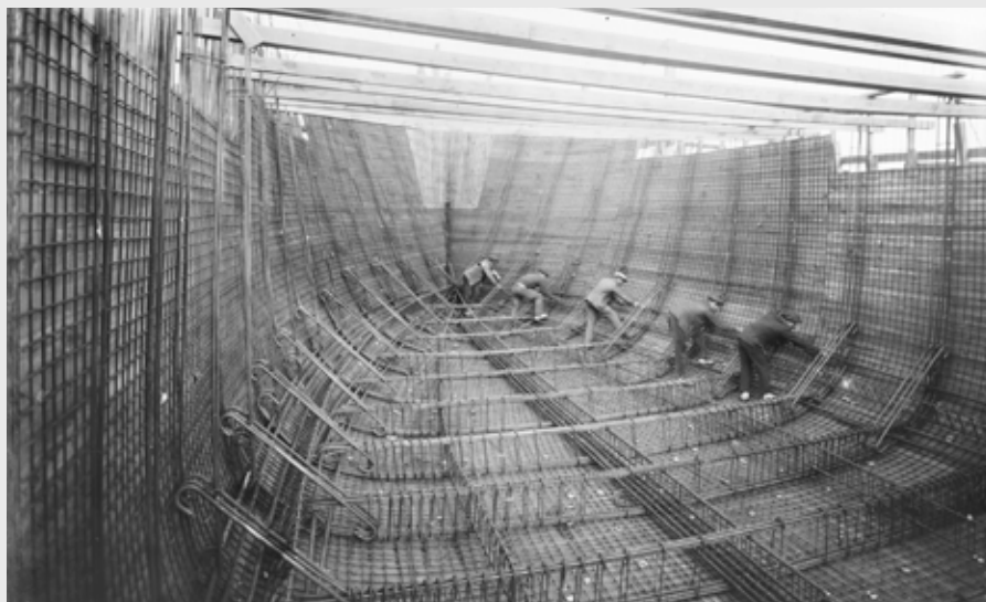
CONSTRUCCIÓ DEL MIROTRES, PRIMER VAIXEL·L DE CIMENT ARMAT FABRICAT A ESPANYA. DRASSANES DE MALGRAT DE MAR © BRANGULÍ / ANC, 2010
