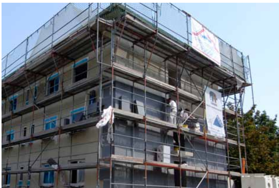
INSTAL·LACIÓ DE PANELLS DE POLIESTIRÈ EXPANDIT A L'EDIFICI DE LUDWIGSHAFEN
