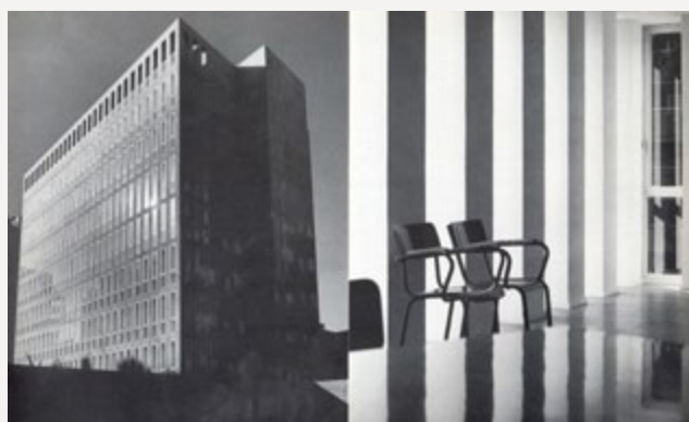
FOTO SUPERIOR: CASA UGALDE. ENMIG: EDIFICIS TRADE A BARCELONA. FOTO INFERIOR: INSTITUT FRANCÈS
