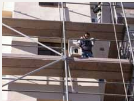
COL·LOCACIÓ DEL NIU ARTIFICIAL
