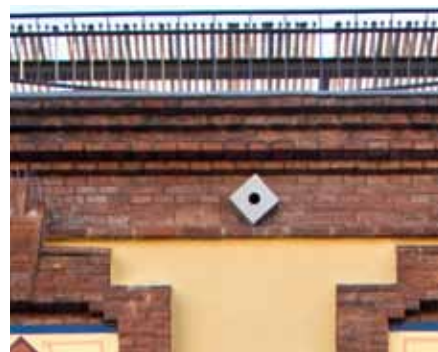
A L'ANTIGA FÀBRICA DEL GAS, LES GRALLES CRIAVEN EN FORATS DE VENTILACIÓ QUE ES VOLIEN TAPAR PER EVITAR QUE S'HI CONTINUESSIN INSTAL·LANT ELS COLOMS. LA SOLUCIÓ HA ESTAT REDUIR-NE EL DIÀMETRE (FOTO DE LA DRETA)
