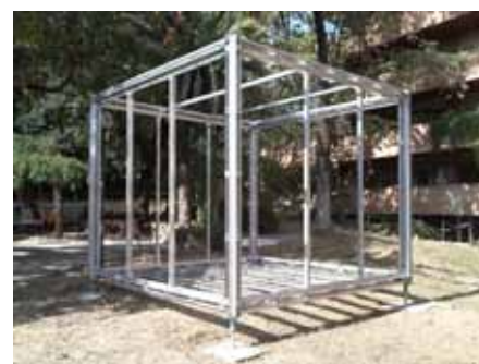
FIG. 4. ESTRUCTURA PRINCIPAL I SECUNDÀRIA
