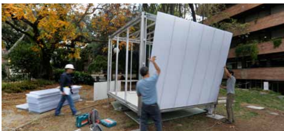
FIGS. 6 I 7. ESPECEJAMENT I ENCAIX DEL SISTEMA DE TANCAMENTS
